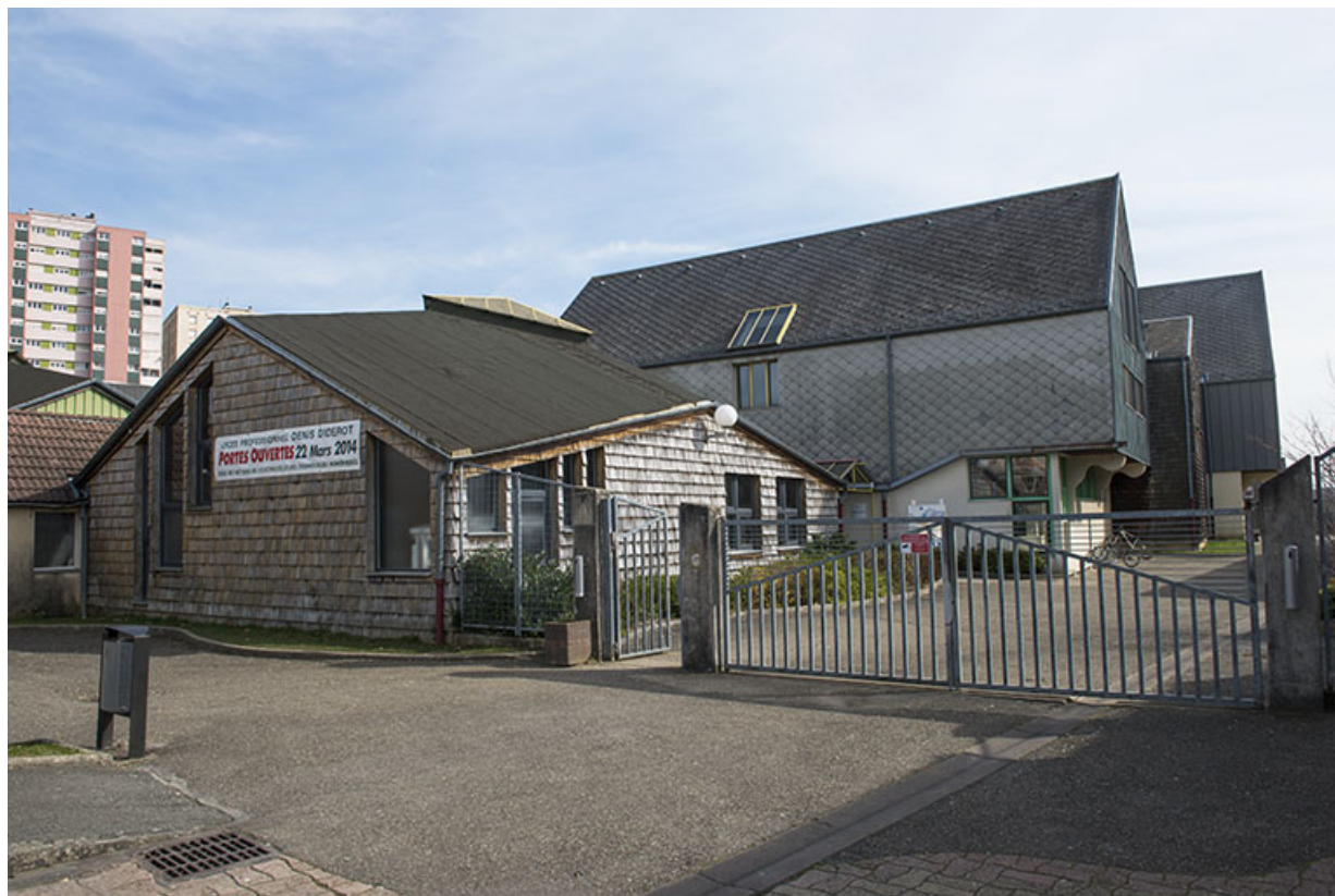
Entrée nord- ouest de la rue d'Alembert, donnant sur la place via la rue vers le nord.
