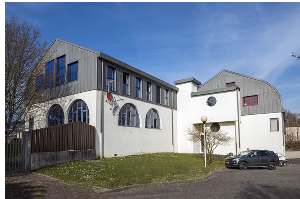
Façades sud et ouest de l'administration et de l'atelier électronique.
