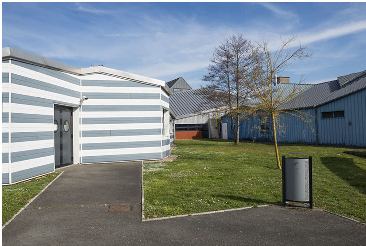
Cour engazonnée à l'ouest autour de laquelle sont disposés des ateliers de mécanique.
