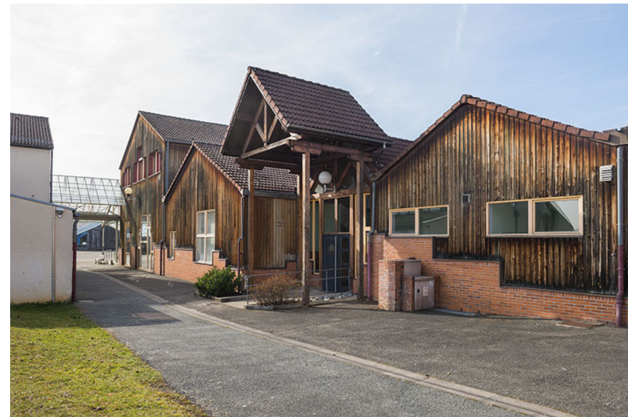
Façades sud de la restauration bordant la rue intérieure vers l'est.
