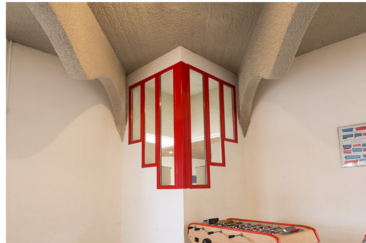
Détail de vue intérieure du foyer.
