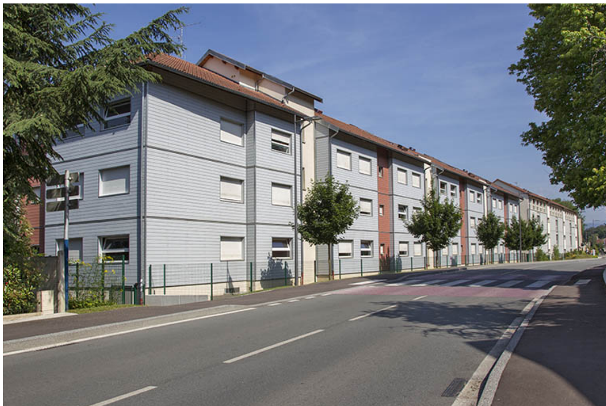
Façade postérieure est sur rue de l'externat nord-est et de l'internat, depuis le sud-est.
