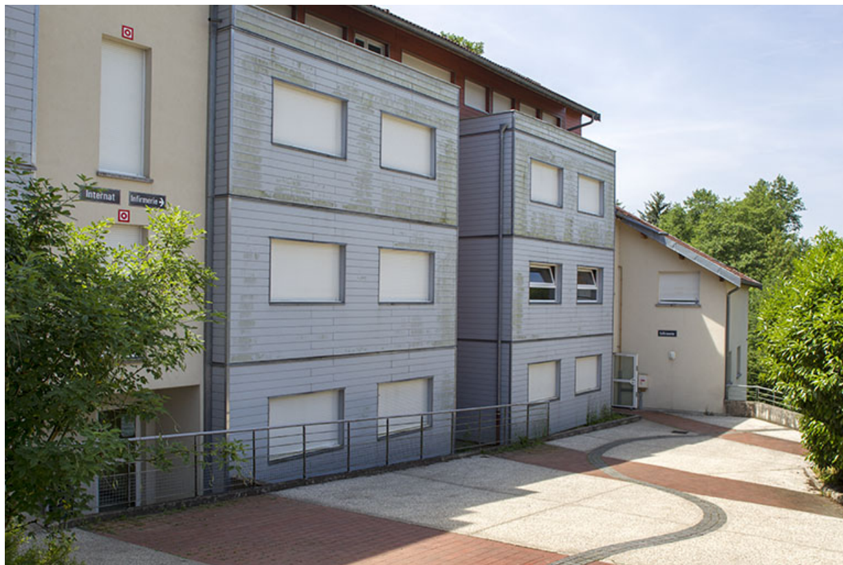
Détail des façades nord de l'aile sud de l'internat et de l'infirmerie.
