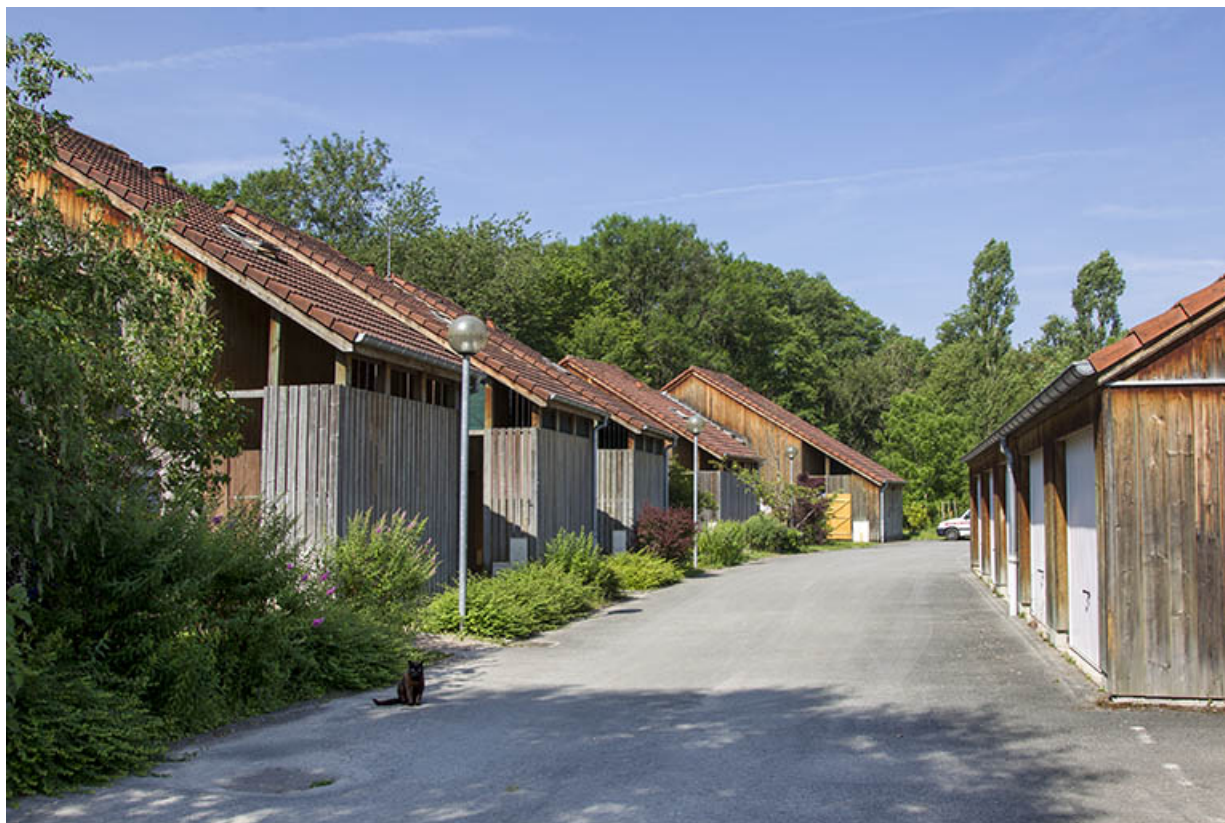
Façades nord des logements du site d'exploitation.
