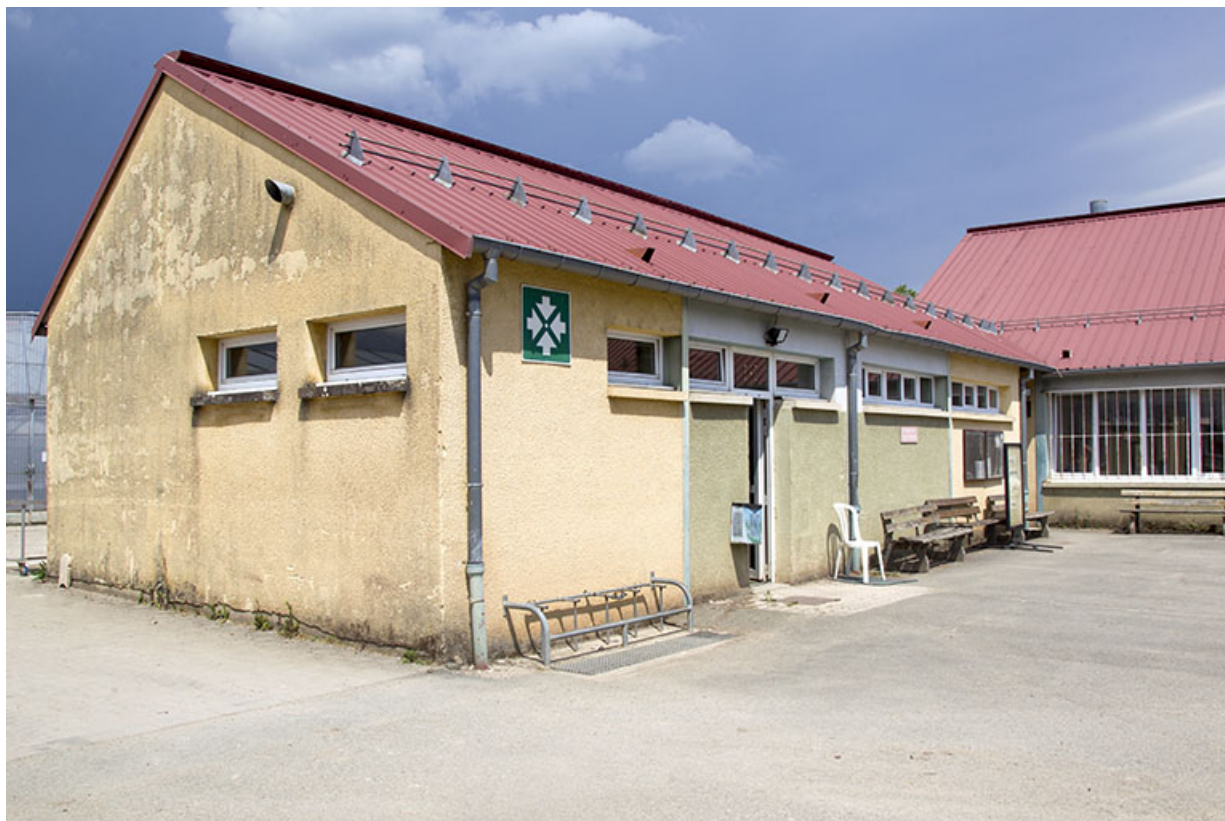
Ateliers. Angle sud-ouest et pignon ouest de l'atelier annexe.
