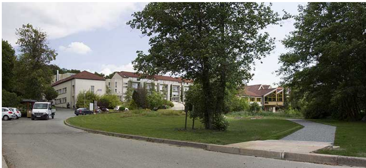
Angle nord-ouest de l'administration et des logements et vue d'ensemble.
