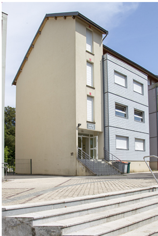
Entrée à l'angle nord-ouest de l'internat.
