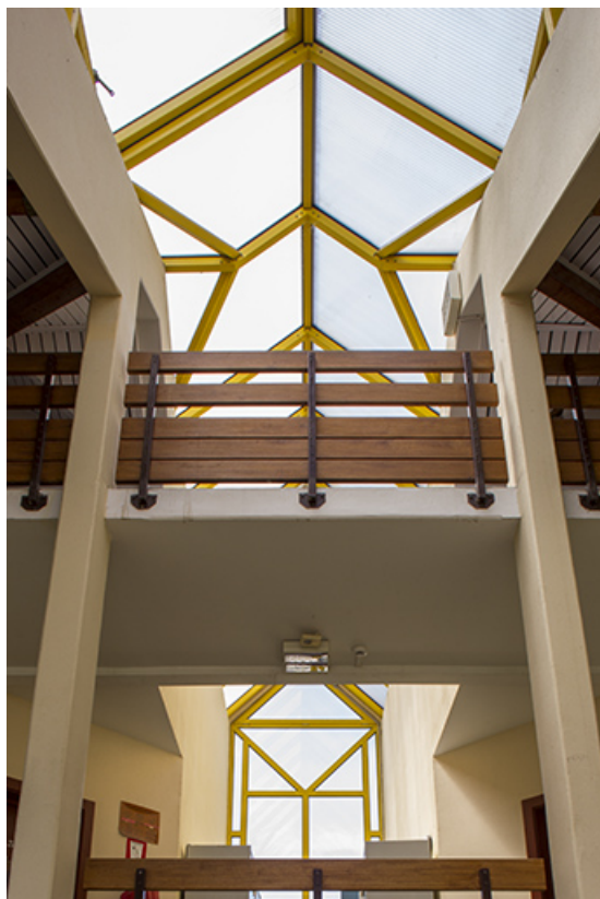
Détail intérieur de l'entrée de l'externat sud-ouest.
