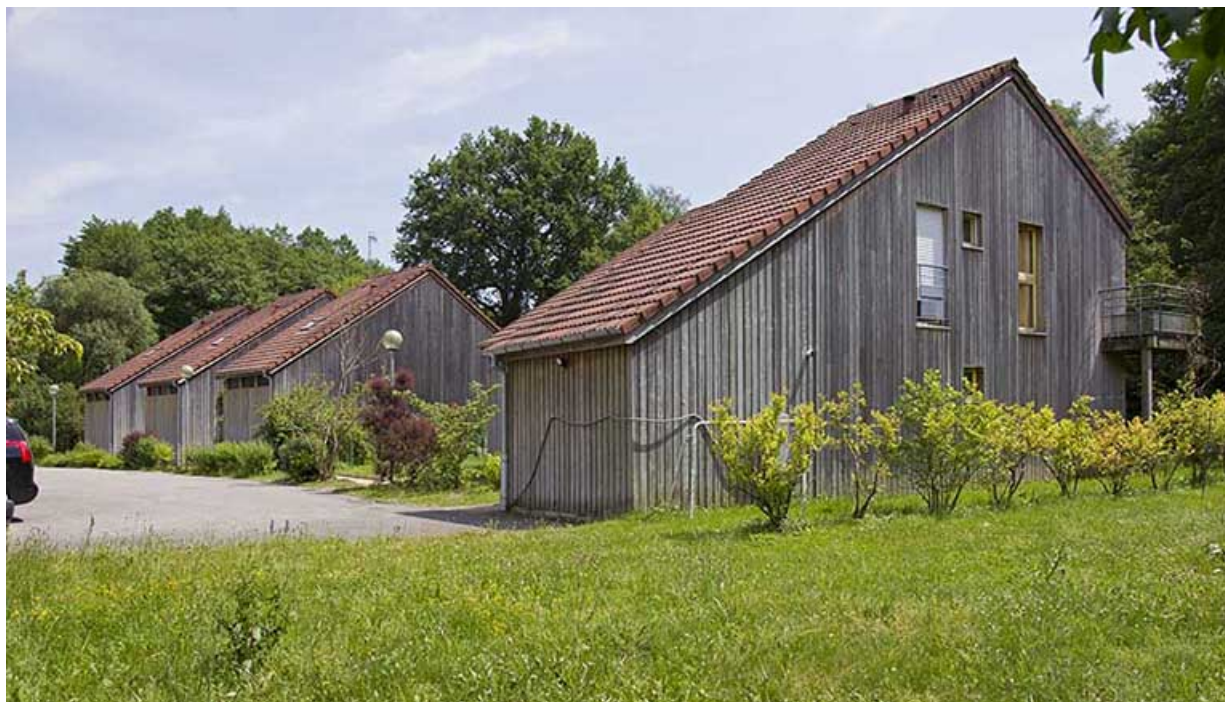
Angle nord-ouest des logements (ouest) du site d'exploitation.
