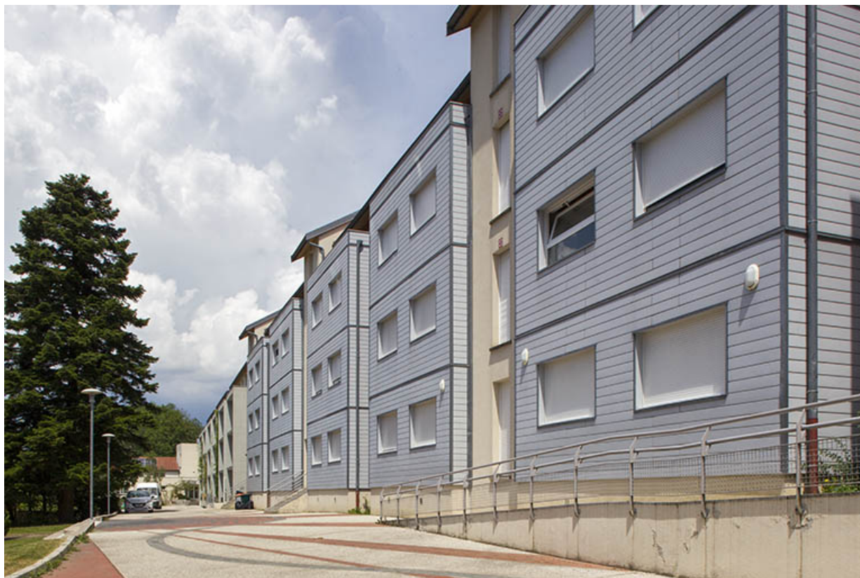
Façade antérieure ouest sur cour de l'externat nord-est et de l'internat, depuis le sud-ouest.
