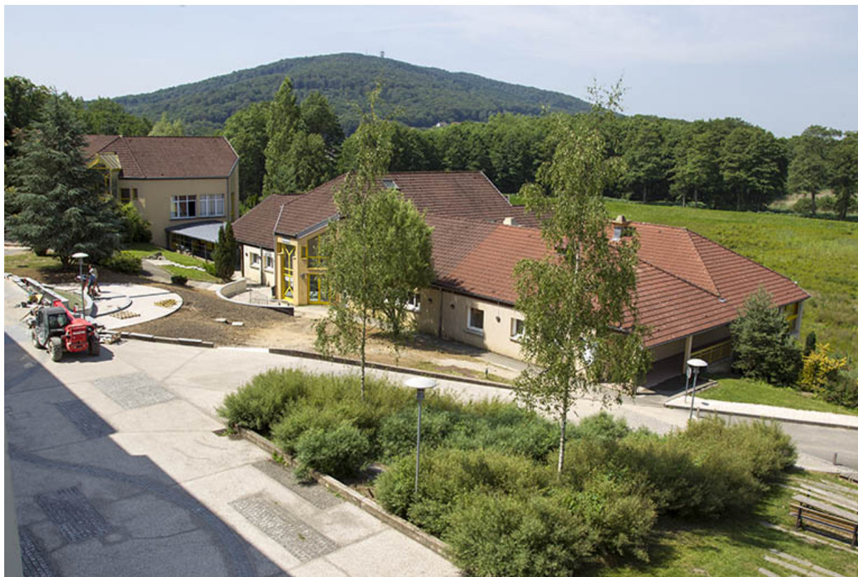
Vue d'ensemble de la cantine et de l'externat sud-ouest depuis le nord-est.
