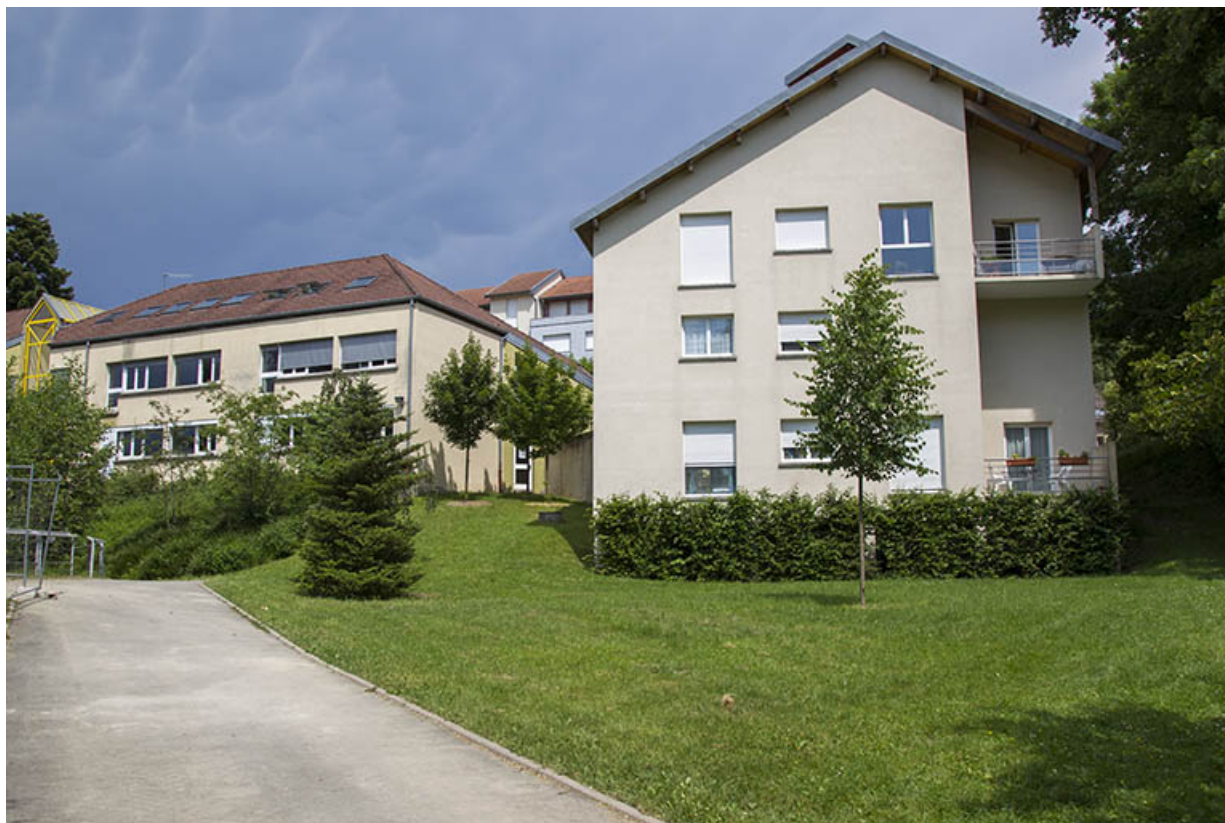
Pignon ouest de l'infirmerie et façade ouest de l'externat sud-ouest.
