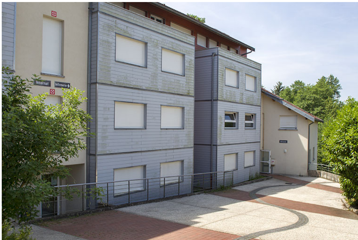
Détail des façades nord de l'aile sud de l'internat et de l'infirmerie.
