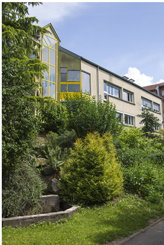
Détail de la façade postérieure ouest de l'externat sud-ouest.
