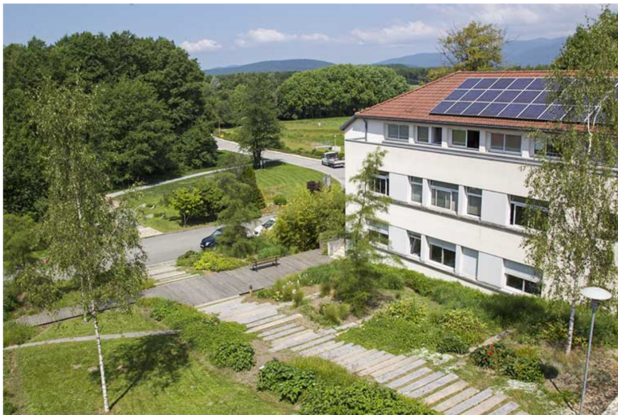
Escalier le long de la façade sud de l'administration et vue sur le nord-ouest.
