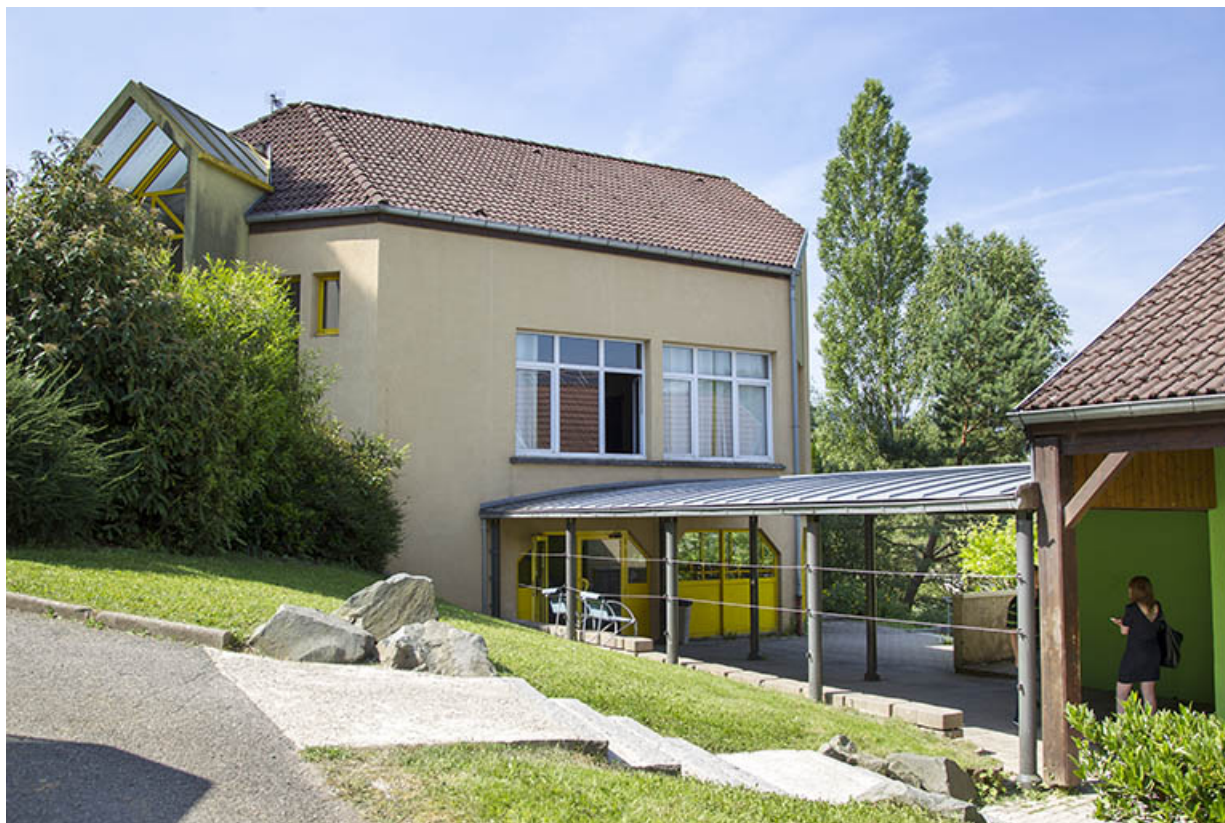
Liaison de la cantine à l'angle nord-est de l'externat sud-ouest.
