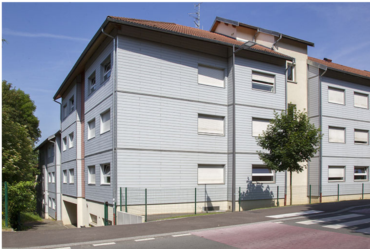
Pignon sud de l'internat, angle sud-est.
