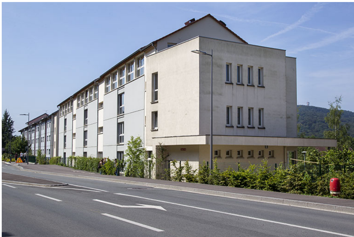
Façade postérieure est sur rue de l'externat nord-est et de l'internat, depuis le nord-est.
