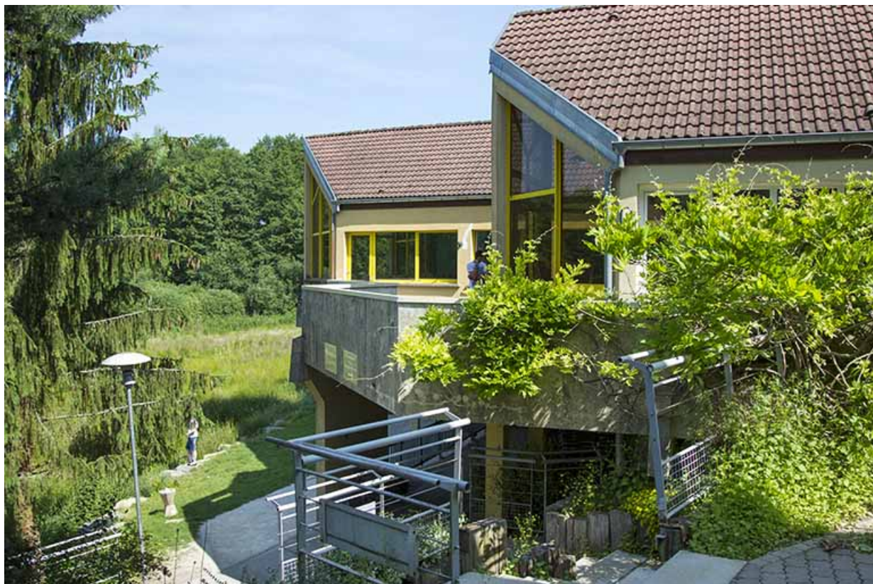
Détail des façades postérieures - ouest - de la restauration.
