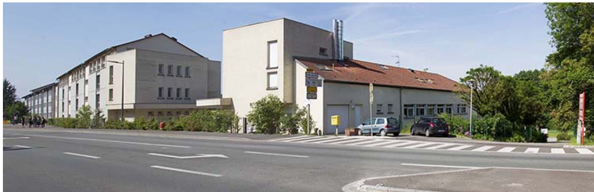
Façades de l'administration, des logements et de l'externat, rue de Turenne, vues du nord-est. 90, Valdoie, 95 rue de Turenne
