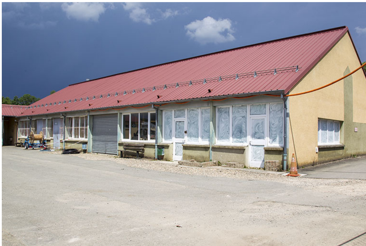
Façade ouest et pignon sud de l'atelier principal.
