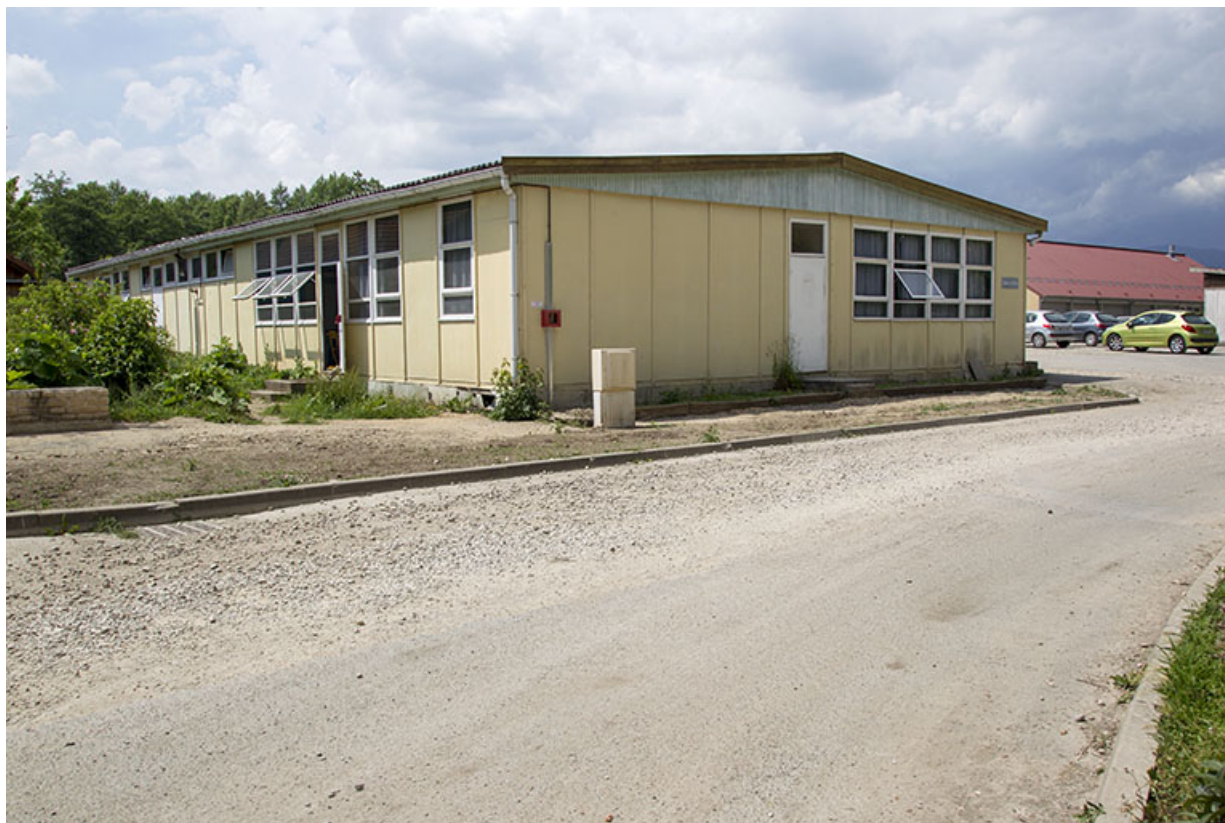
Pignon est et façade sud de la salle de cours sud du site d'exploitation.
