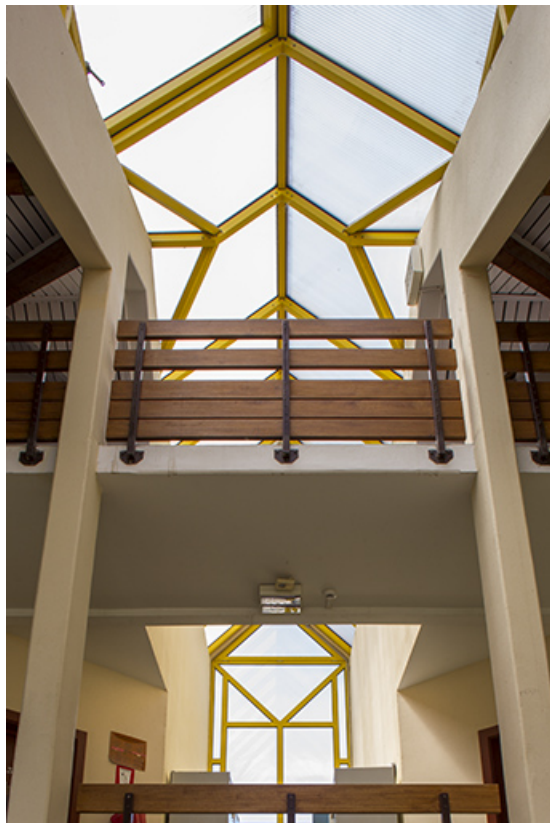
Détail intérieur de l'entrée de l'externat sud-ouest.
