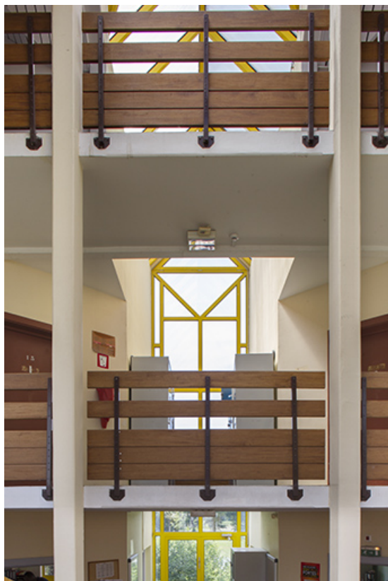
Détail haut intérieur de l'entrée de l'externat sud-ouest.
