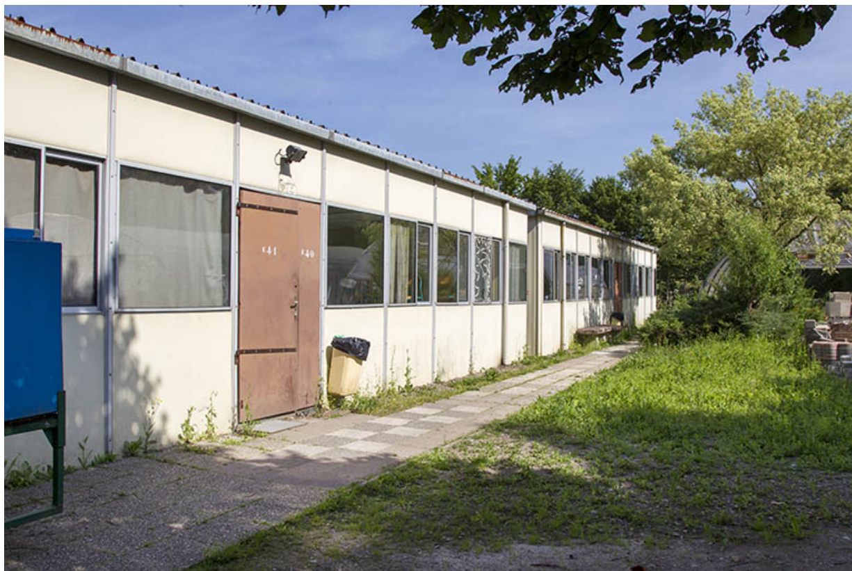
Façade postérieure des salles de cours nord-est.
