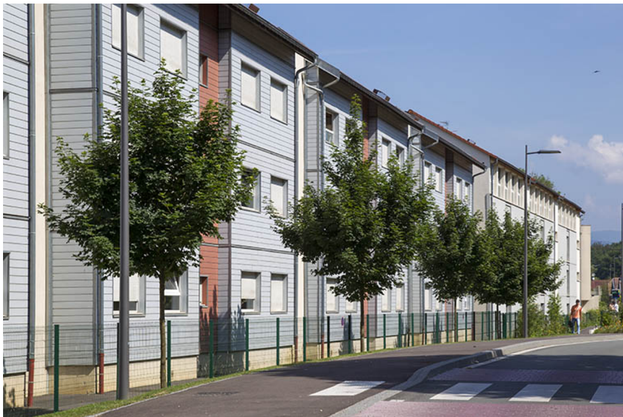
Détail de la façade postérieure est sur rue de l'externat nord-est et de l'internat, depuis le sud-est. 90, Valdoie, 95 rue de Turenne
