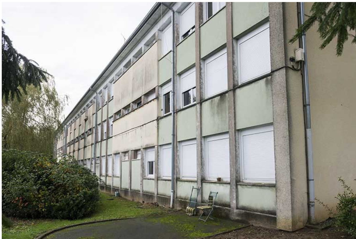
Façade ouest de la barre de logements au nord-ouest.
