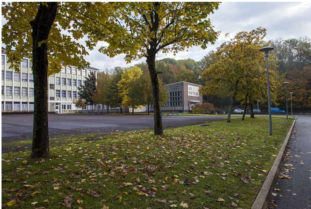
Au sud-est de la barre d'externat du pôle tertiaire, la salle de conférence dite Goldschmidt. 90, Belfort, 3 rue Louis Marchal
