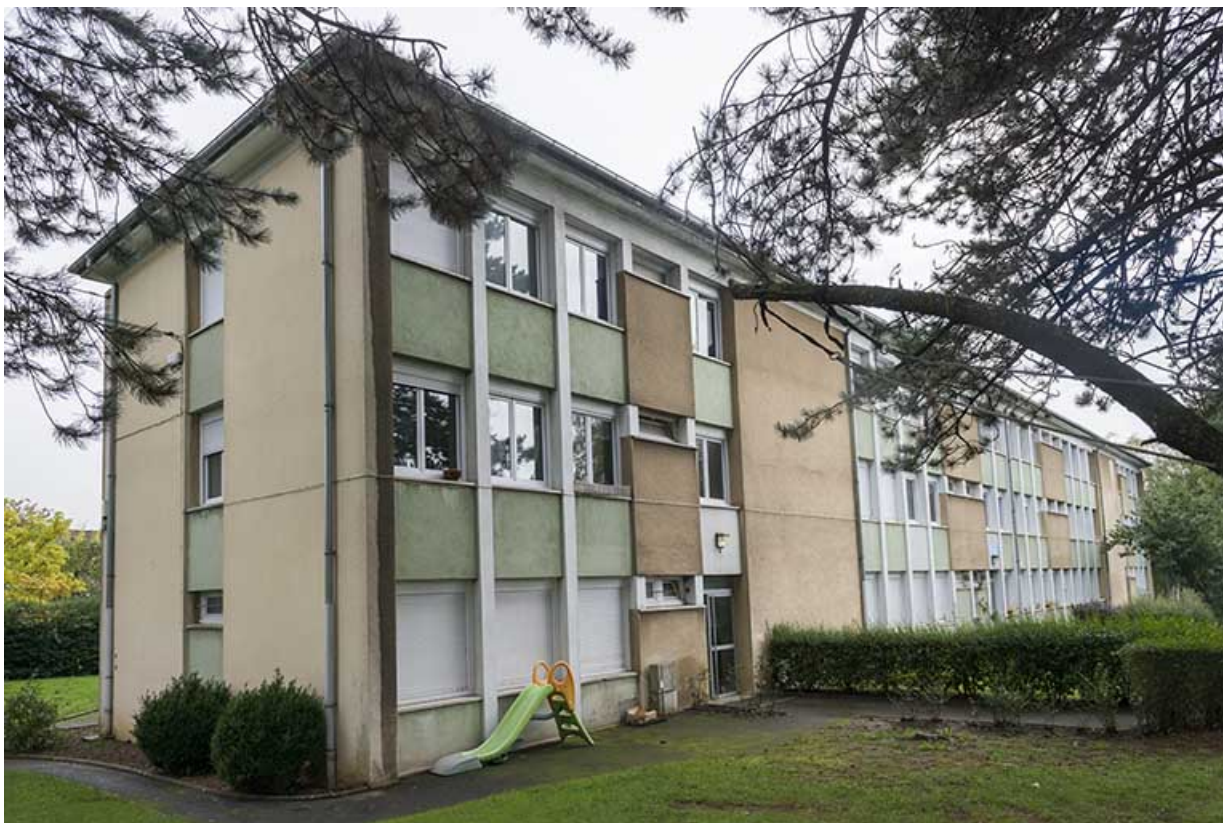
Façade est de la barre de logements.
