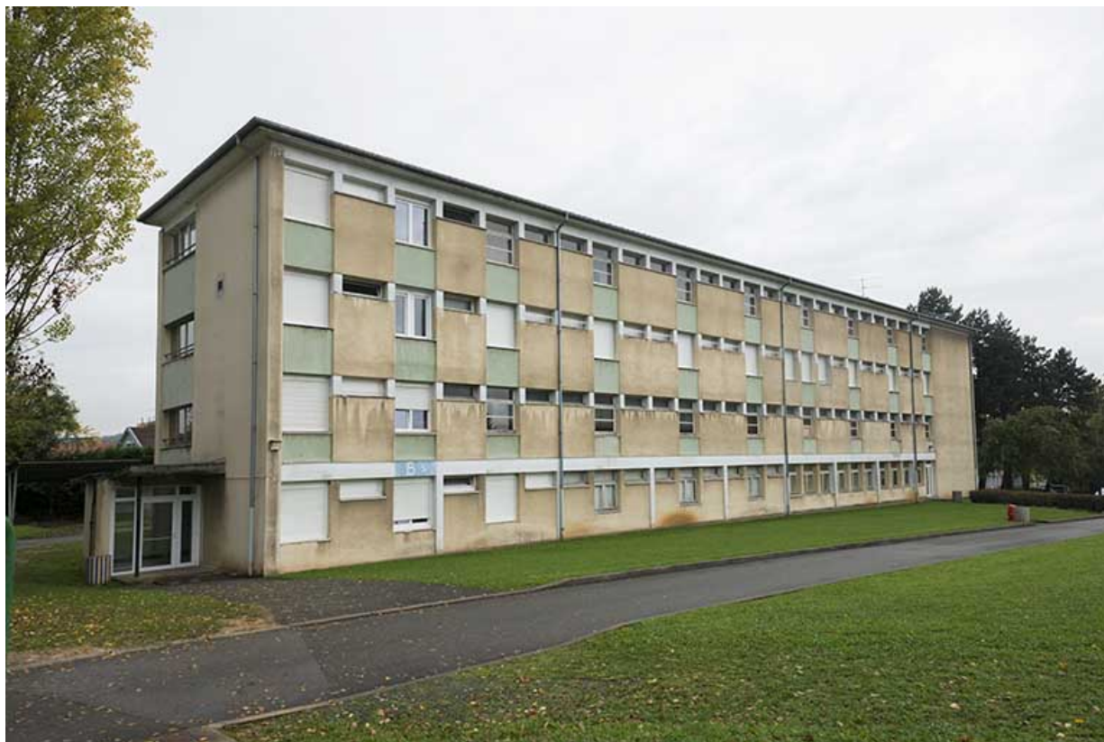
Angle sud-est et façade est de l'internat de garçons sud-ouest.
