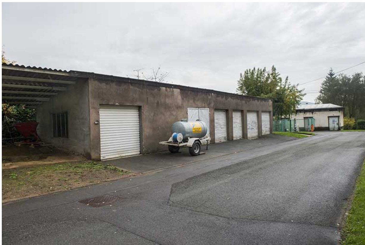
Garages des logements, à l'ouest de l'internat de garçons ouest.
