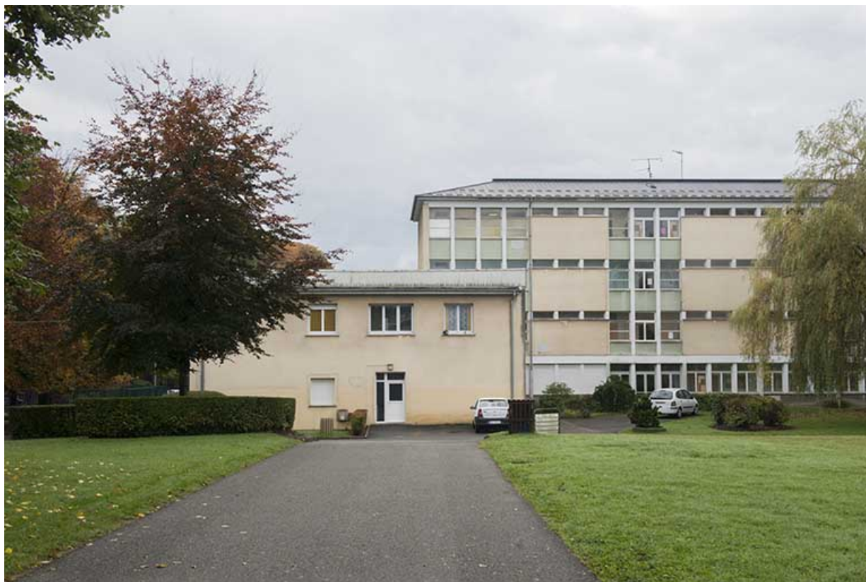
Angle est de la façade nord du pôle tertiaire et pignon nord de l'administration sud. 90, Belfort, 3 rue Louis Marchal
