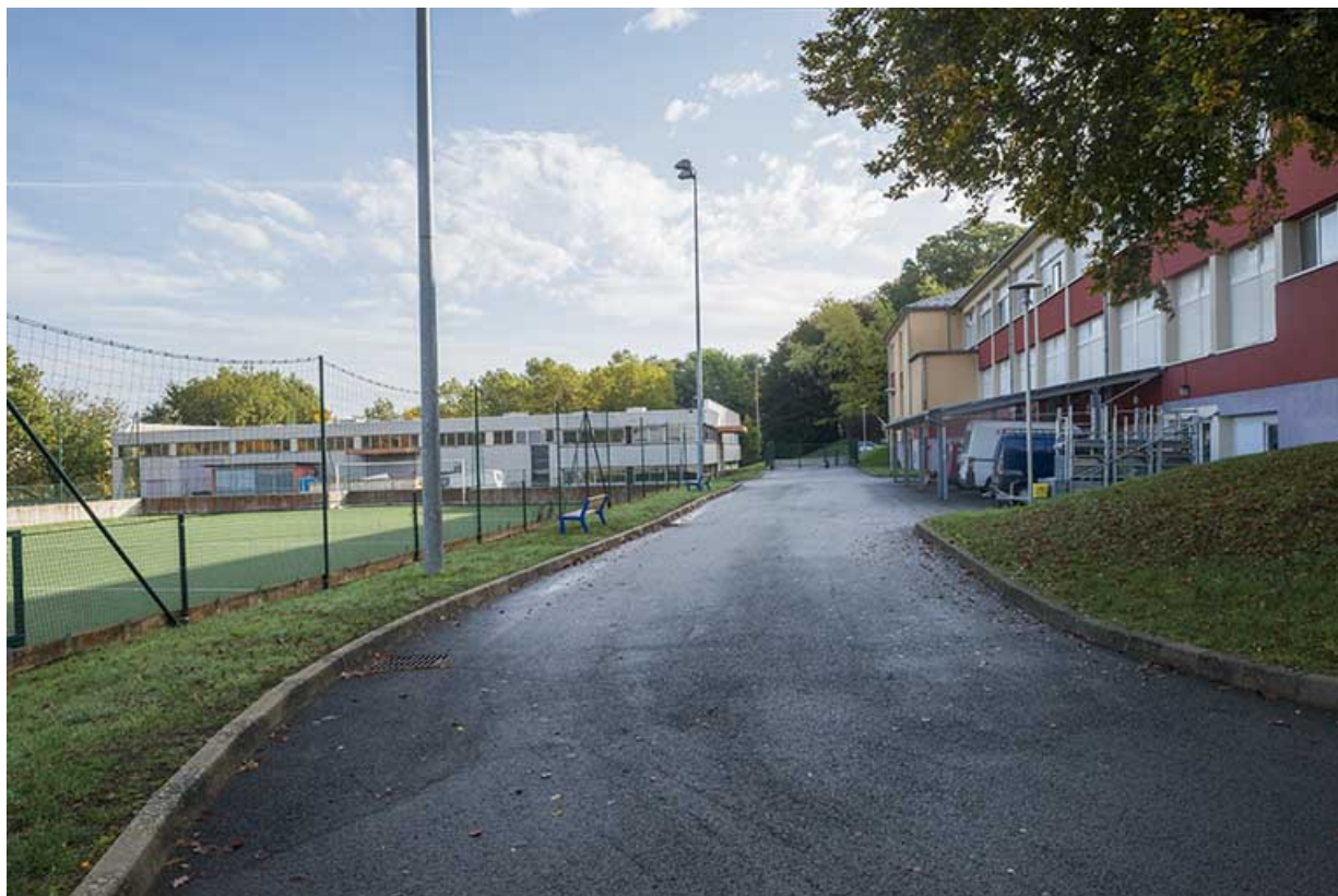
Accès entre la barre nord de l'externat du pôle industriel et métiers de la mode et l'atelier de chaudronnerie. 90, Belfort, 3 rue Louis Marchal
