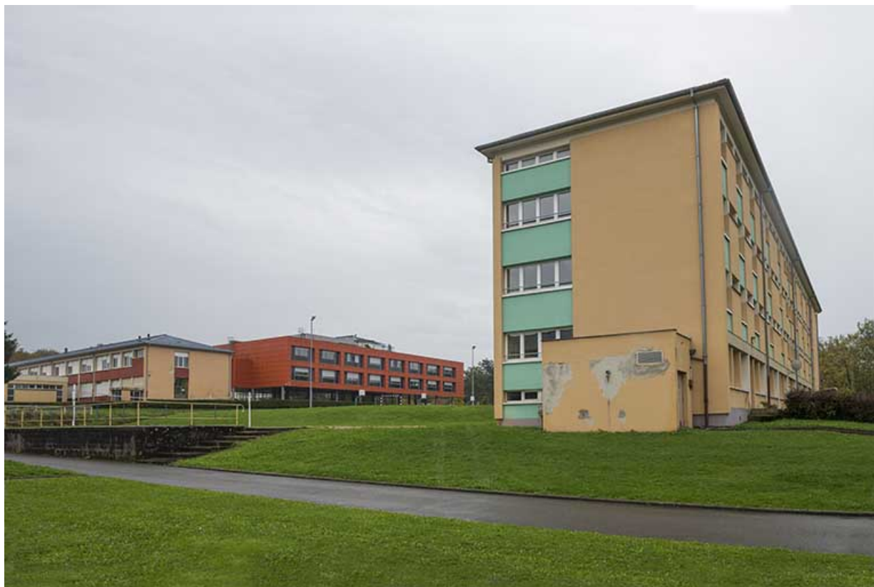
Angle nord-ouest de l'internat de garçons est, vue sur le stade et au-delà, le pôle scientifique et l'angle nord-ouest de l'externat. 90, Belfort, 3 rue Louis Marchal
