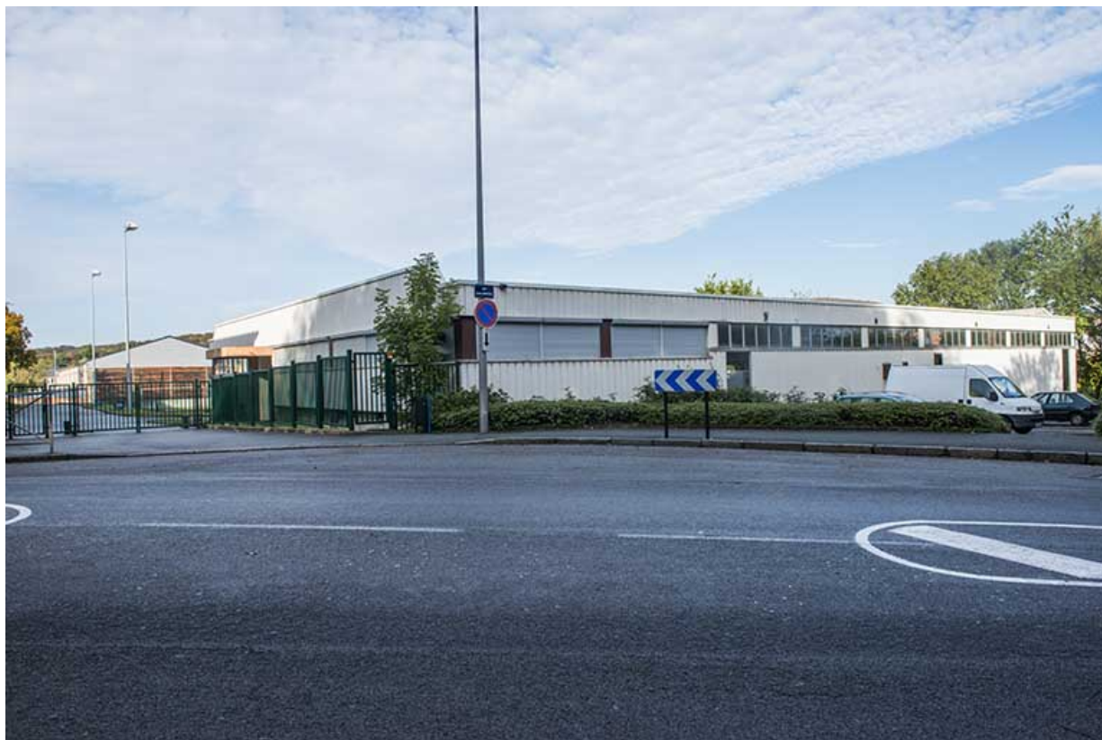
Façade est et angle sud-est de l'atelier de chaudronnerie.
