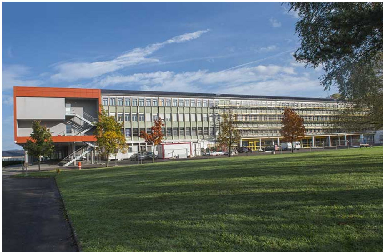
Cour et façade sud de l'externat des cours généraux et du centre de documentation et d'information. 90, Belfort, 3 rue Louis Marchal
