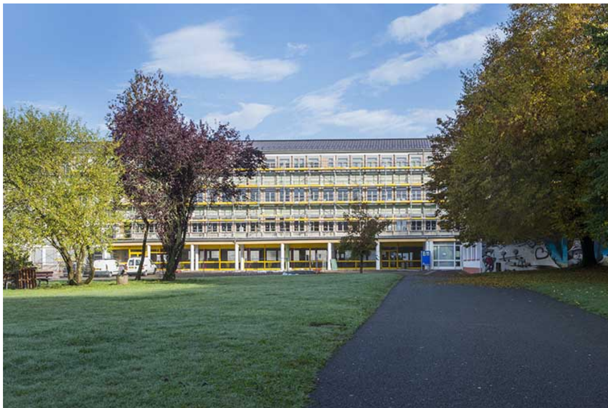
Cour et façade sud de l'externat des cours généraux, façade sud peinte de l'administration nord. 90, Belfort, 3 rue Louis Marchal
