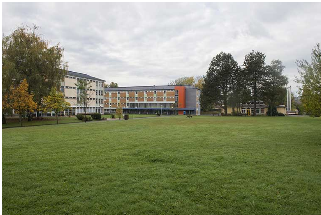
Grande cour centrale, façade nord du pôle tertiaire, façade est de l'internat de filles, face est de la cantine. 90, Belfort, 3 rue Louis Marchal
