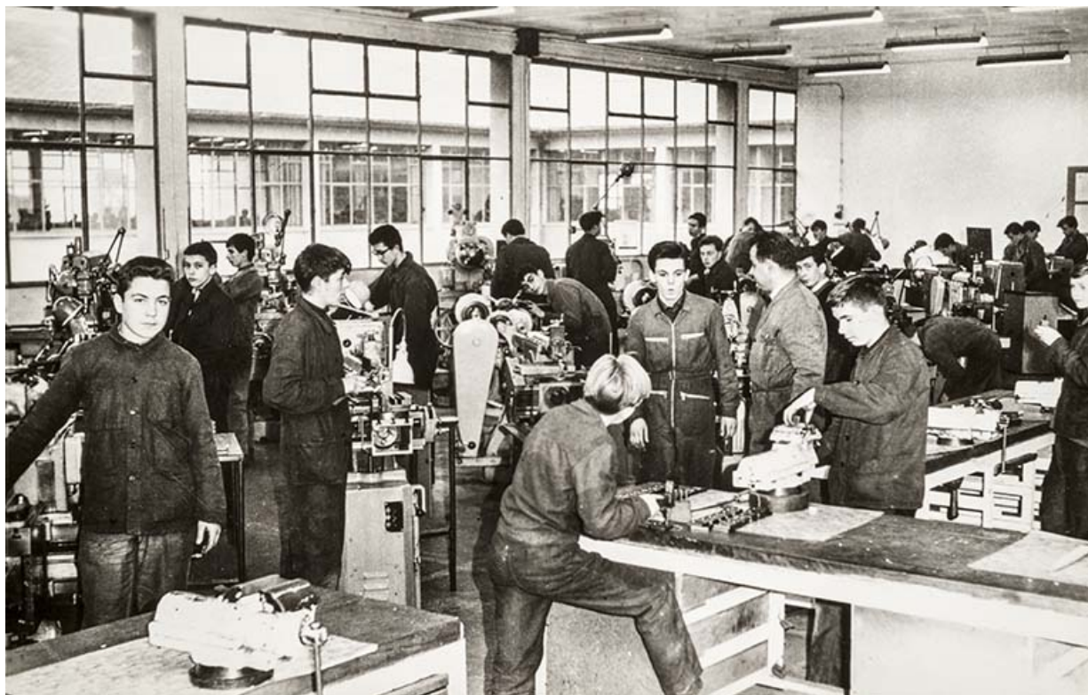
Lycée Raoul Follereau : dans les ateliers durant les années 1960. 90, Belfort, 3 rue Louis Marchal
