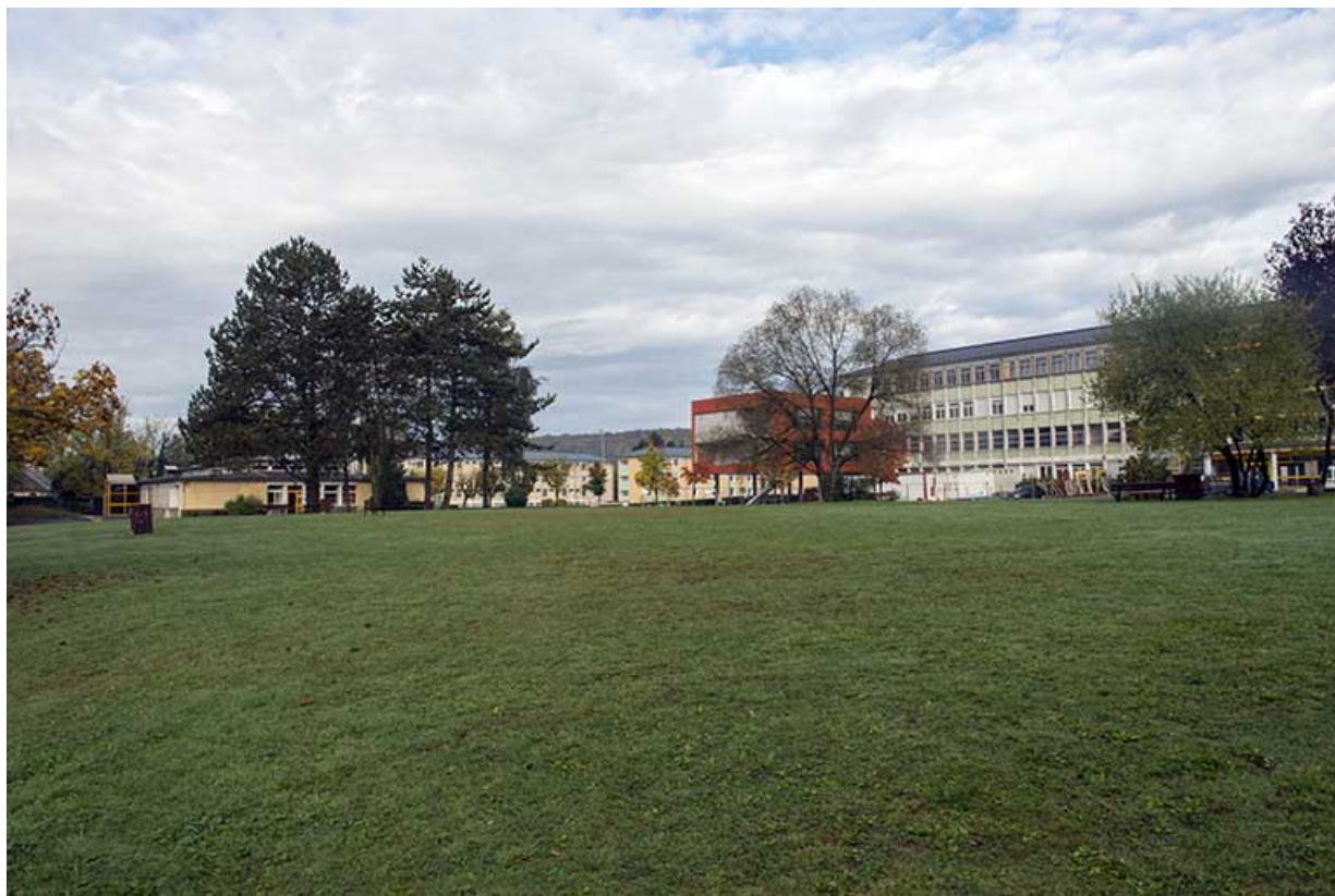
Grande cour centrale engazonnée face à la cantine et part ouest de l'externat des cours généraux et du centre de documentation et d'information et pignon sud du pôle scientifique.
