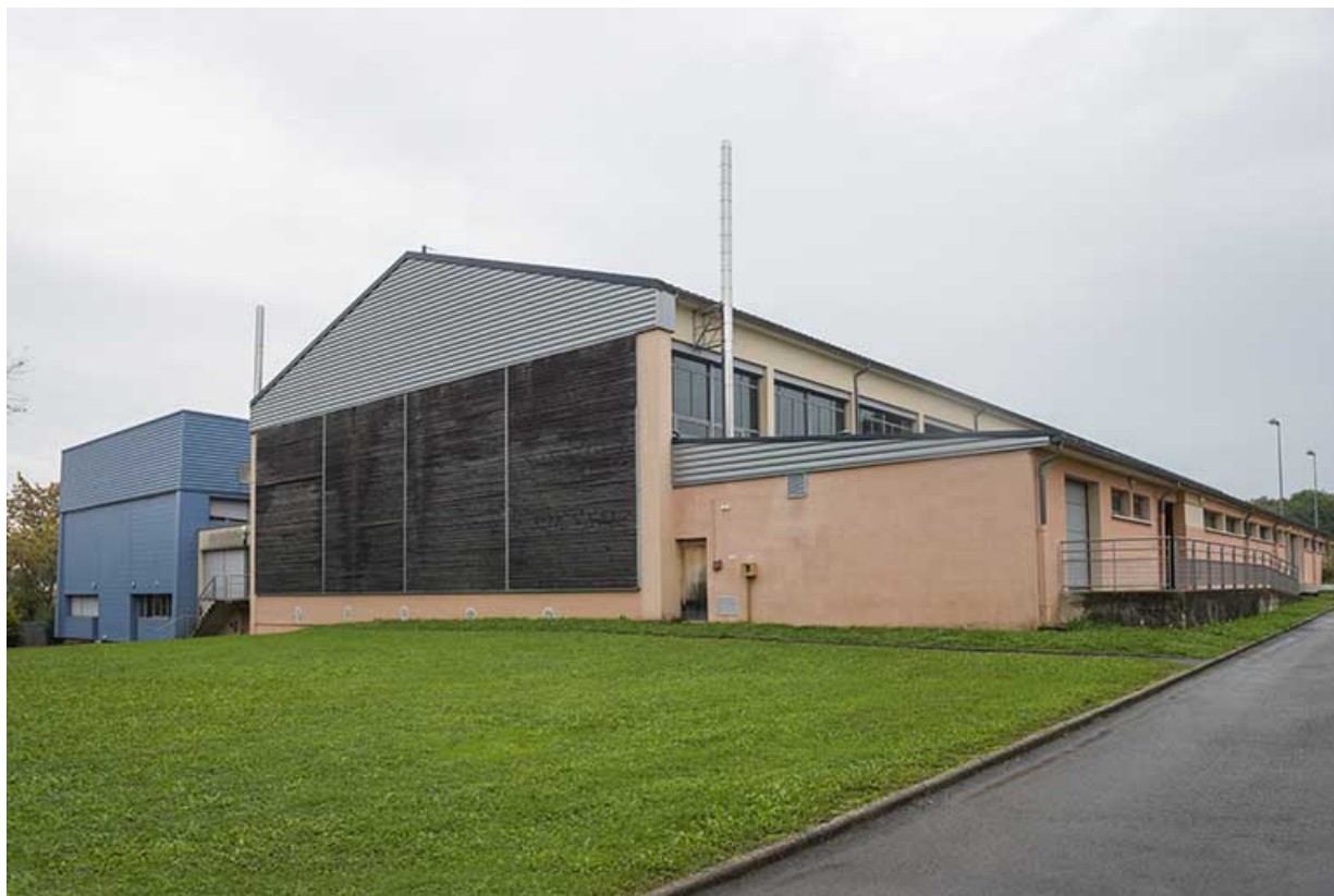
Angles sud-ouest du gymase et de l'atelier de logisitique.
