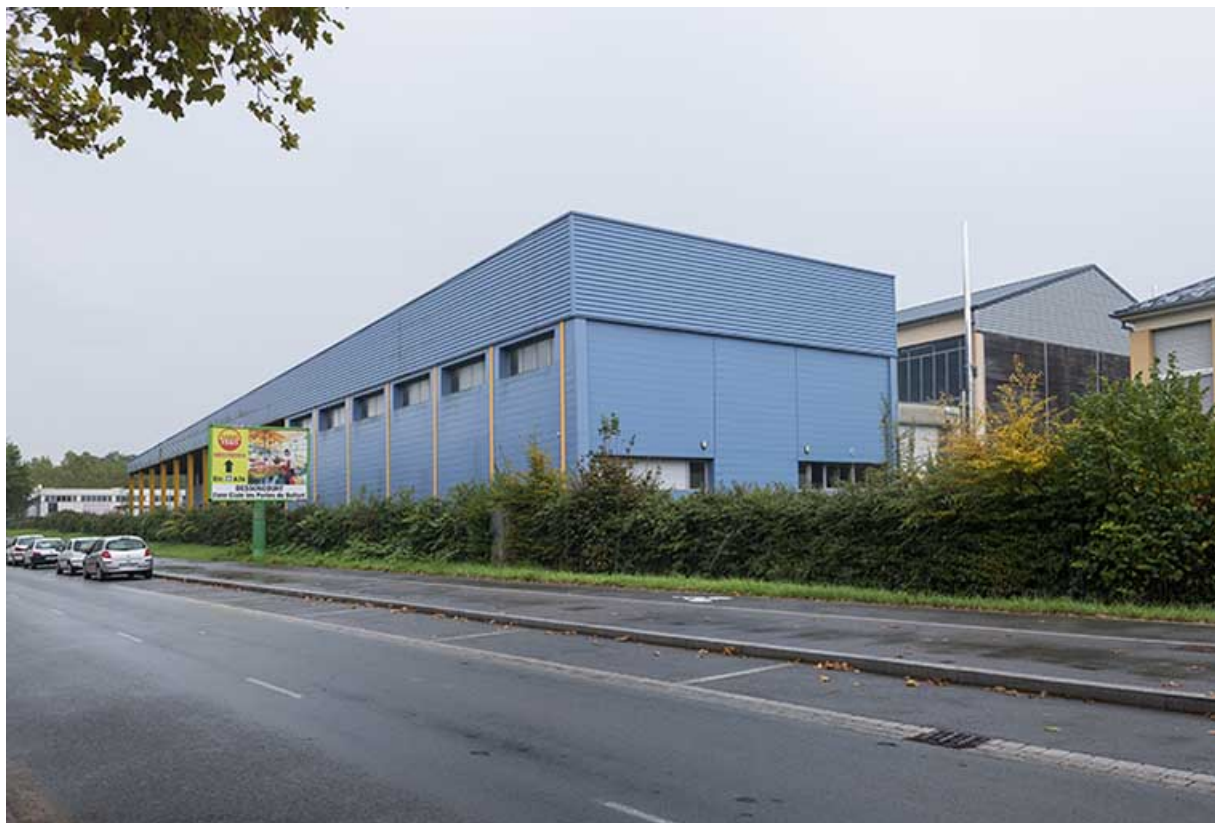
Façade nord et angle nord-ouest du pôle logistique et pignon ouest du gymnase. 90, Belfort, 3 rue Louis Marchal
