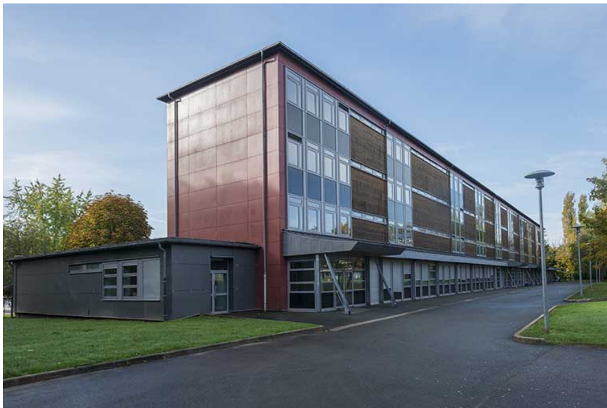
Façade nord et angle nord-est de l'externat de cours généraux et du pôle sanitaire. 90, Belfort, 3 rue Louis Marchal
