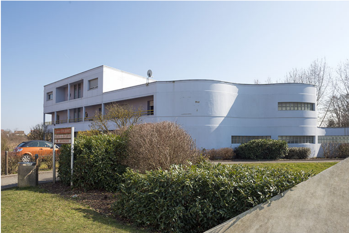
Façade antérieure nord sur rue des logements nord-est.
