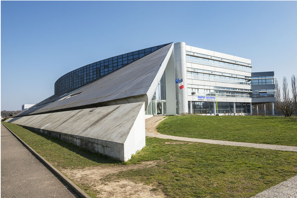
Lycée Gustave Courbet : façade d'entrée et angle nord-ouest du bâtiment socio-éducatif. 90, Belfort avenue du Général Gambiez
