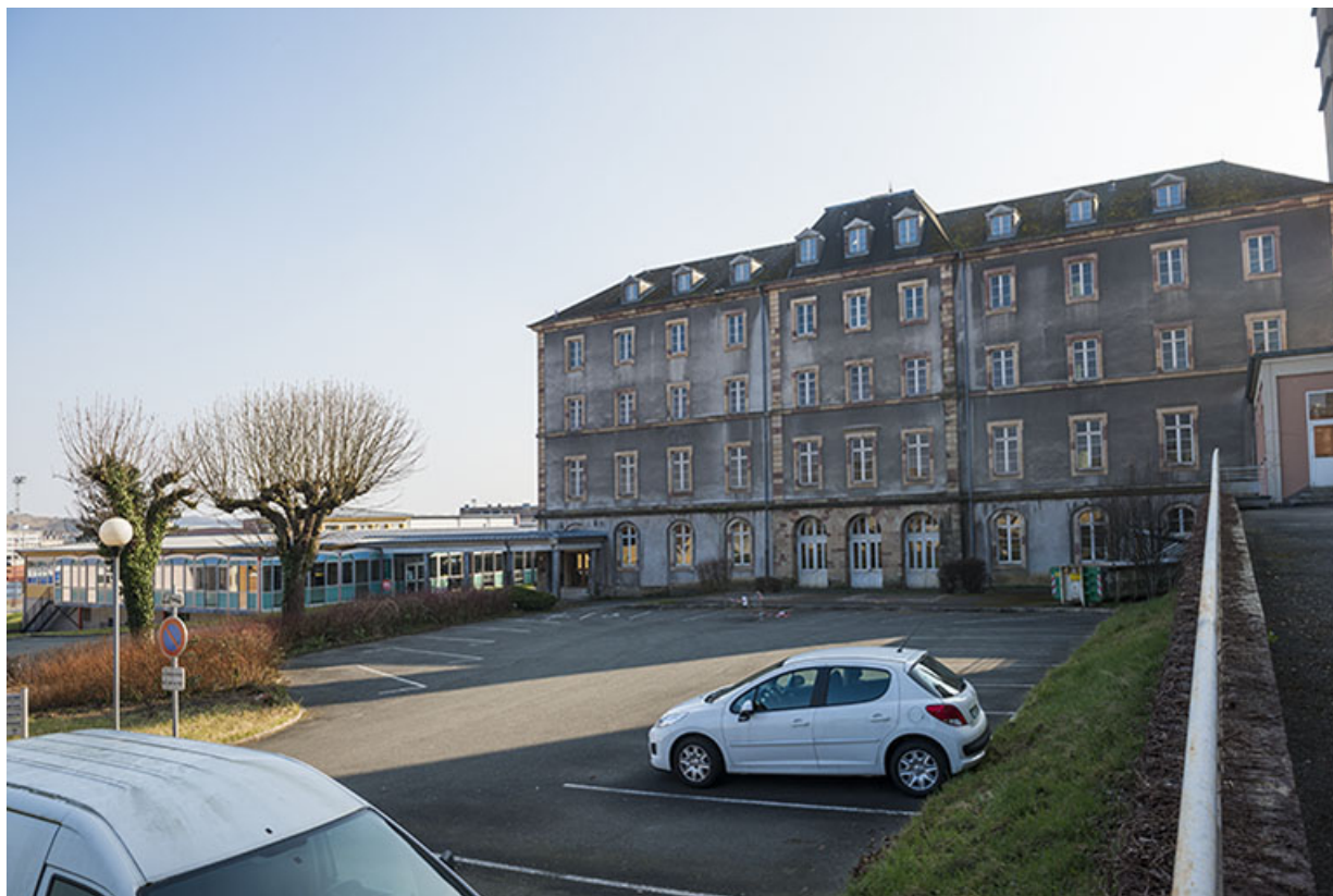
Cour du petit lycée, sa façade nord, trappes de livraison de bois, restauration. 90, Belfort, 13 rue du président Roosevelt
