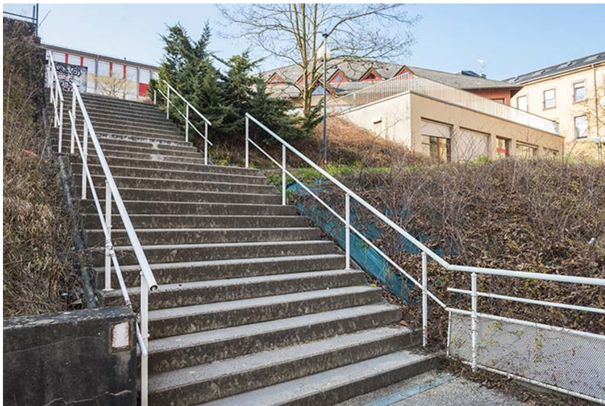
Escalier indépendant reliant la cour du collège et le niveau de l'internat.
