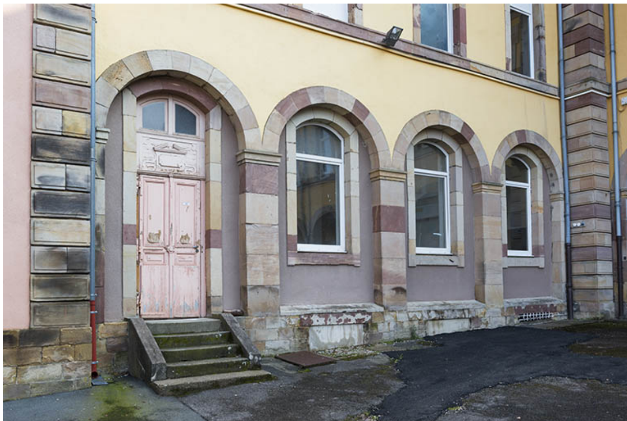
Détail de porte sur la façade antérieure de l'aile est du corps central du grand lycée. 90, Belfort, 13 rue du président Roosevelt
