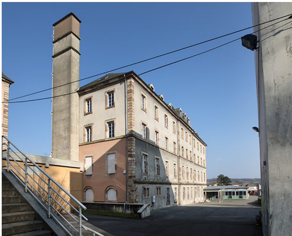
Angle sud-ouest et façade sud du petit lycée. Au second plan la restauration. 90, Belfort, 13 rue du président Roosevelt
