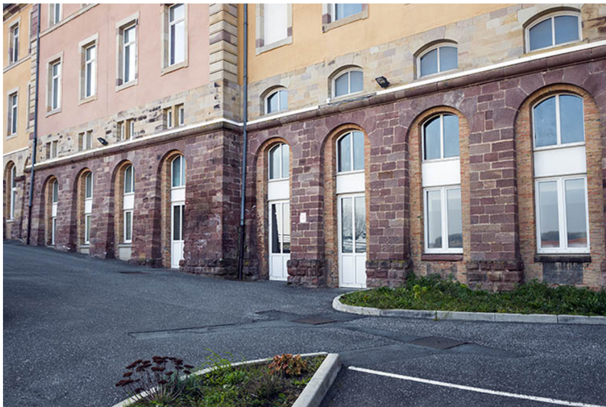
Détail de la façade orientale de l'aile est du grand lycée.
