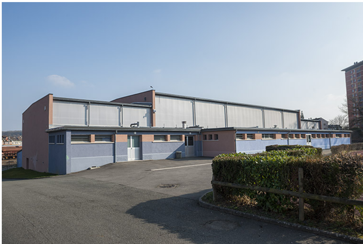
Angle nord-ouest du gymnase, façade antérieure.
