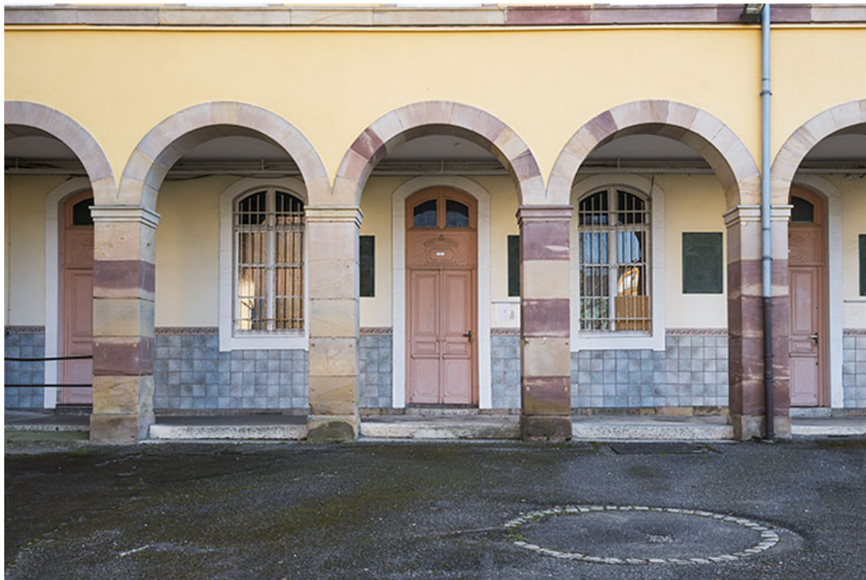
Détail des arcades de la façade antérieure du corps central du grand lycée.
