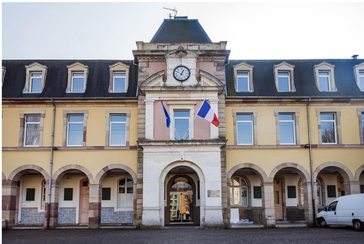
Façade antérieure du grand lycée et sa cour d'honneur : détail.
