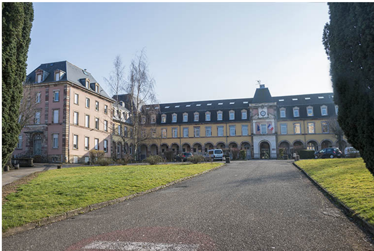
Façade antérieure du grand lycée, aile est, et sa cour d'honneur.
