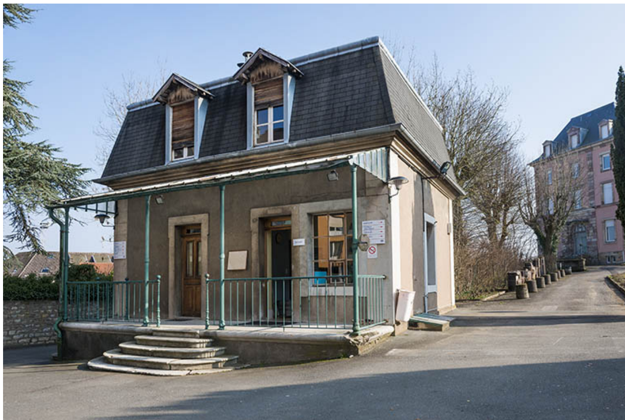
Façade antérieure (nord) de la conciergerie.
