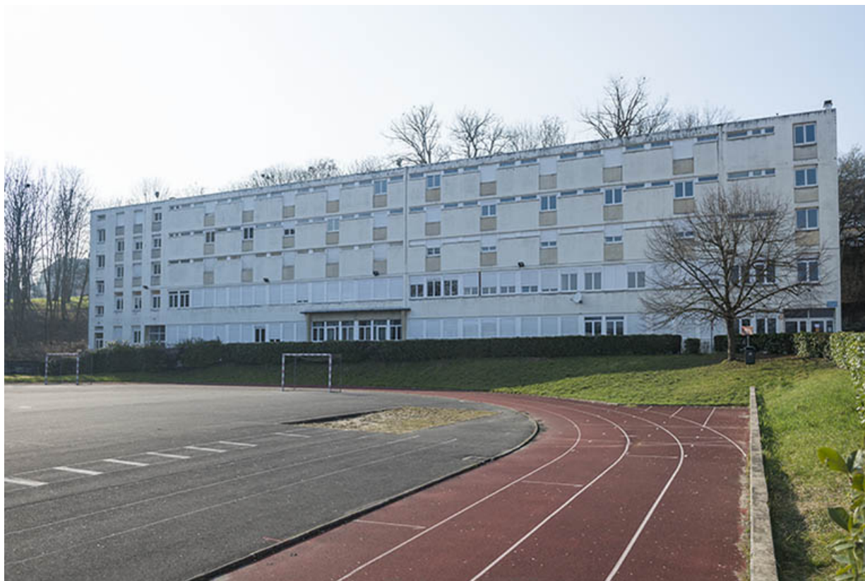
Stade, façade antérieure (est) de l'internat.
