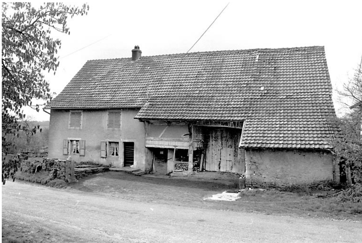
Façade antérieure sur rue. 90, Saint-Dizier-l'Évêque
