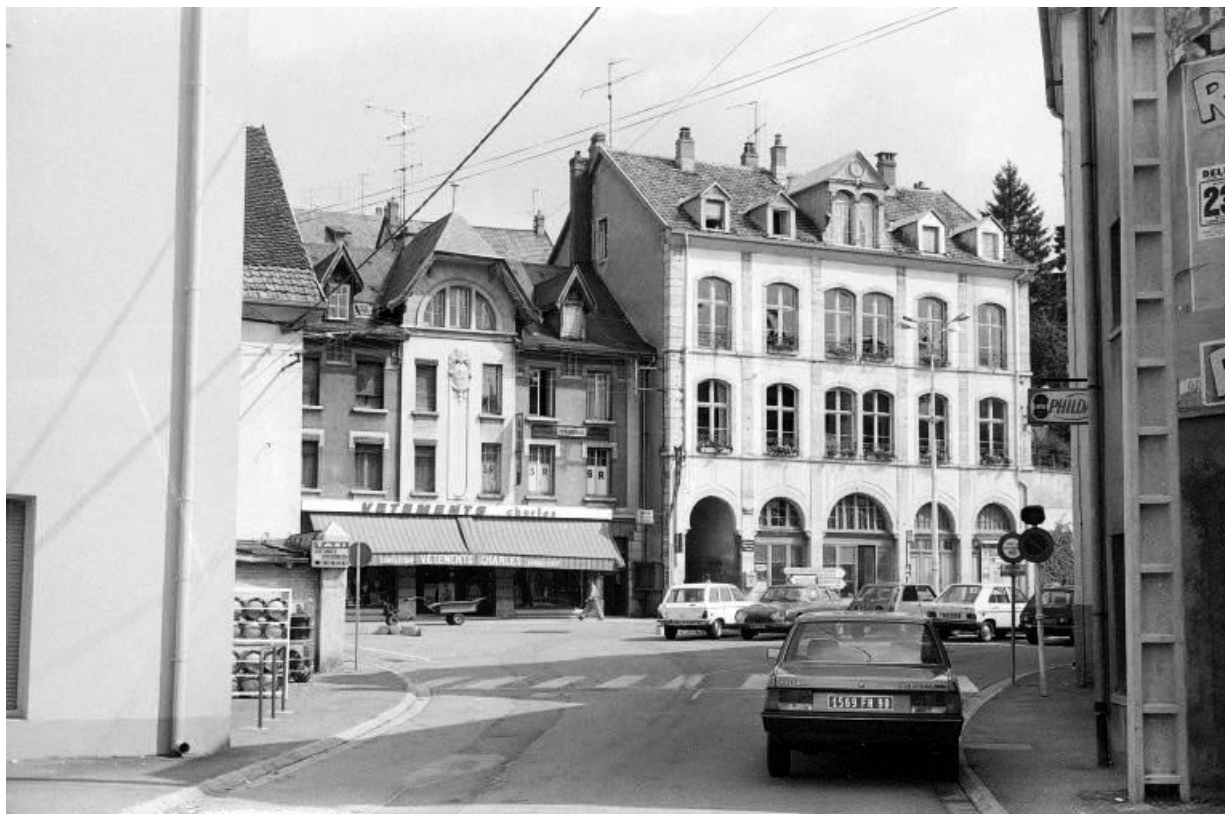
Ecole : façades antérieure et latérale droite.
