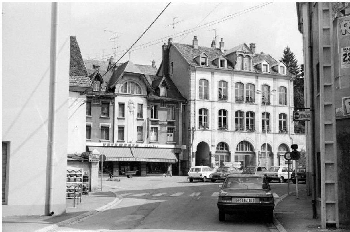
Ecole : façades antérieure et latérale droite.
