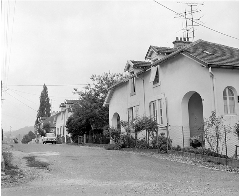
Vue de la rue des Fondateurs. SRI. Enquête régionale sur les bâtiments industriels (1979-1981). 90, Beaucourt, lieudit : cité Adolphe Japy
