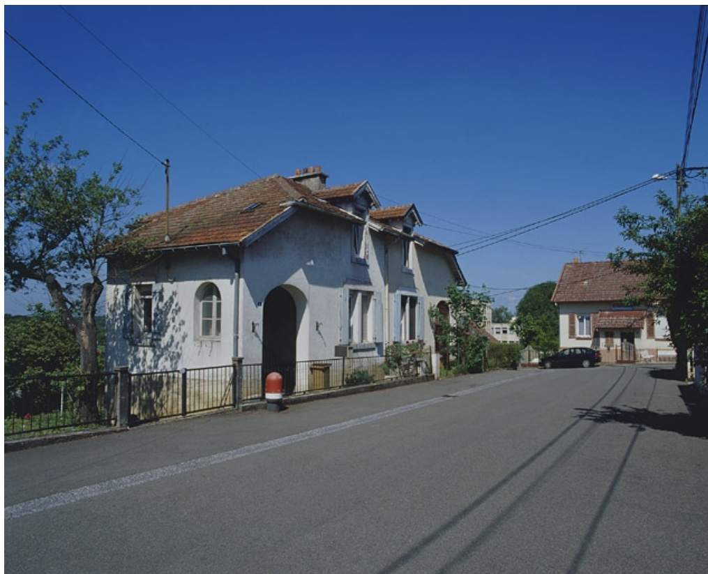
Maison jumelée rue des Fondeurs : vue de trois quarts.
