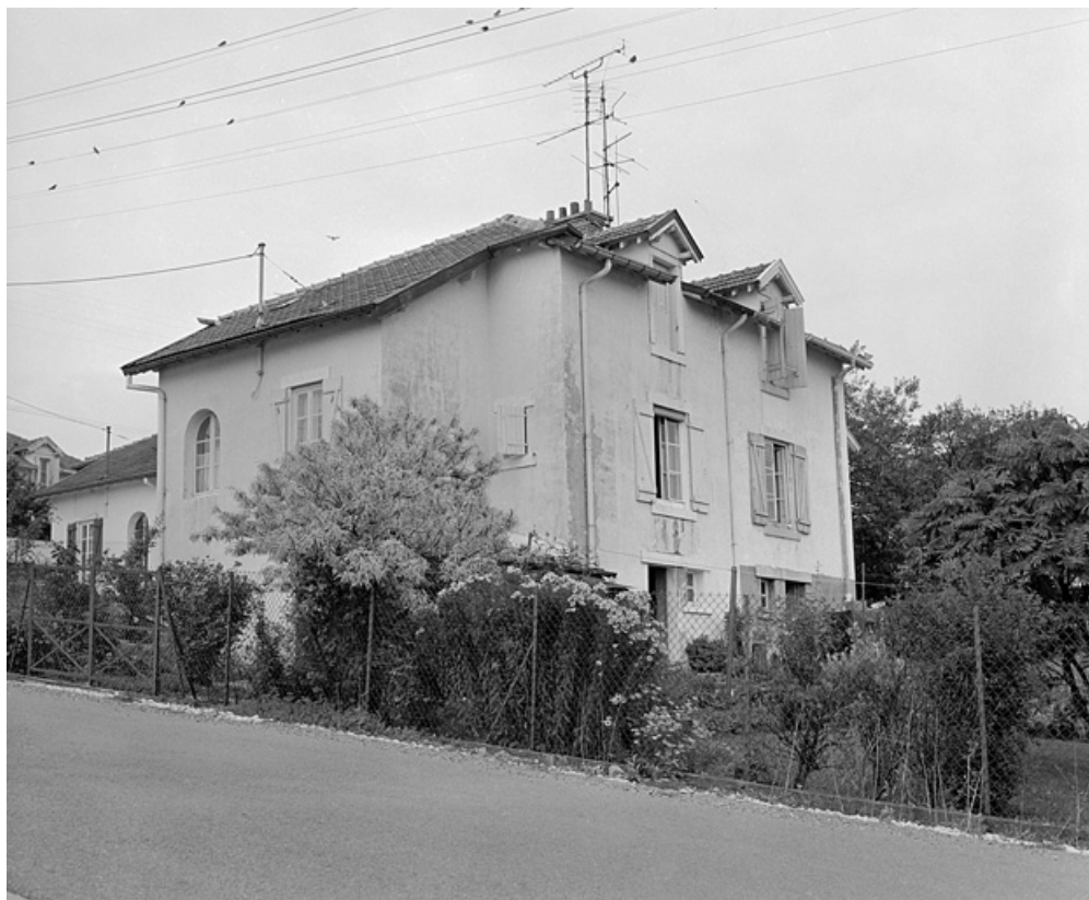
Maison jumelée rue des Fondateurs : façade postérieure. SRI. Enquête régionale sur les bâtiments industriels (1979-1981). 90, Beaucourt, lieudit : cité Adolphe Japy
