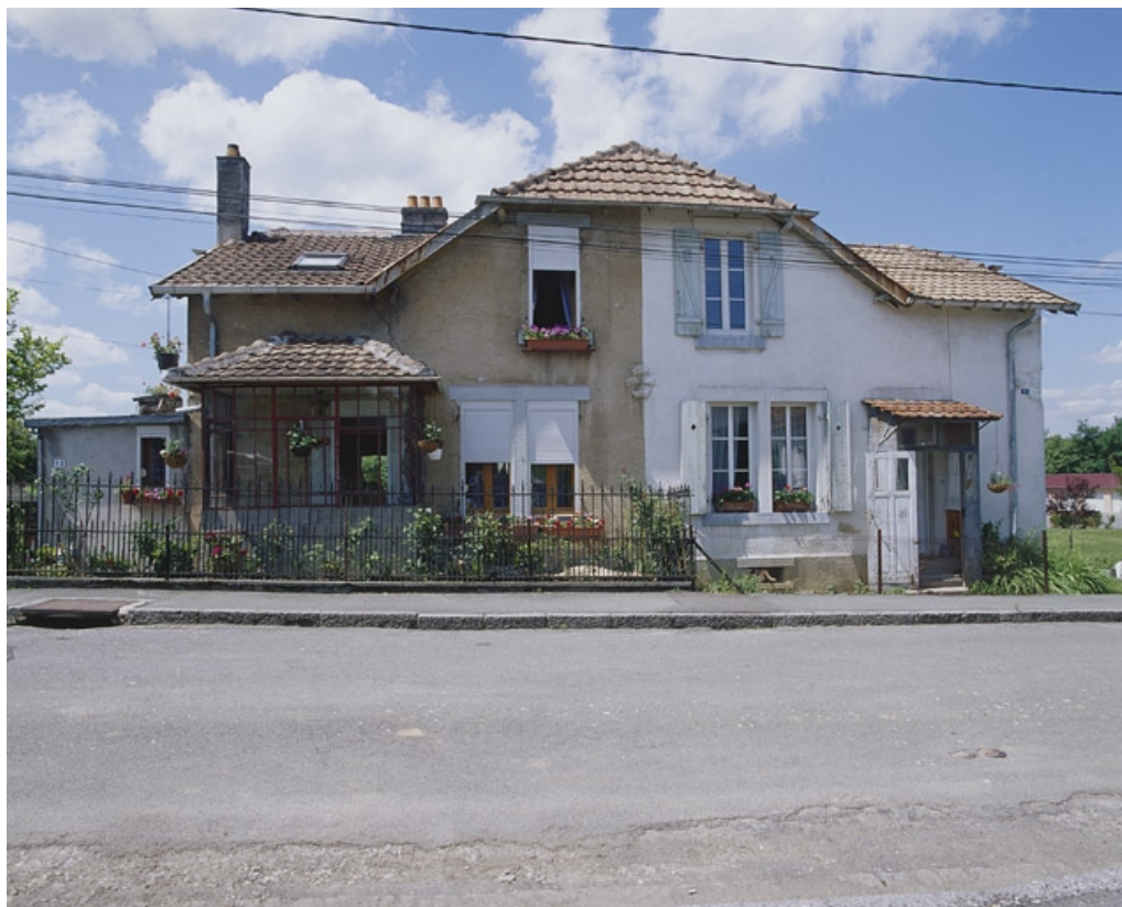
Maison jumelée rue de Normandie : vue de face.
