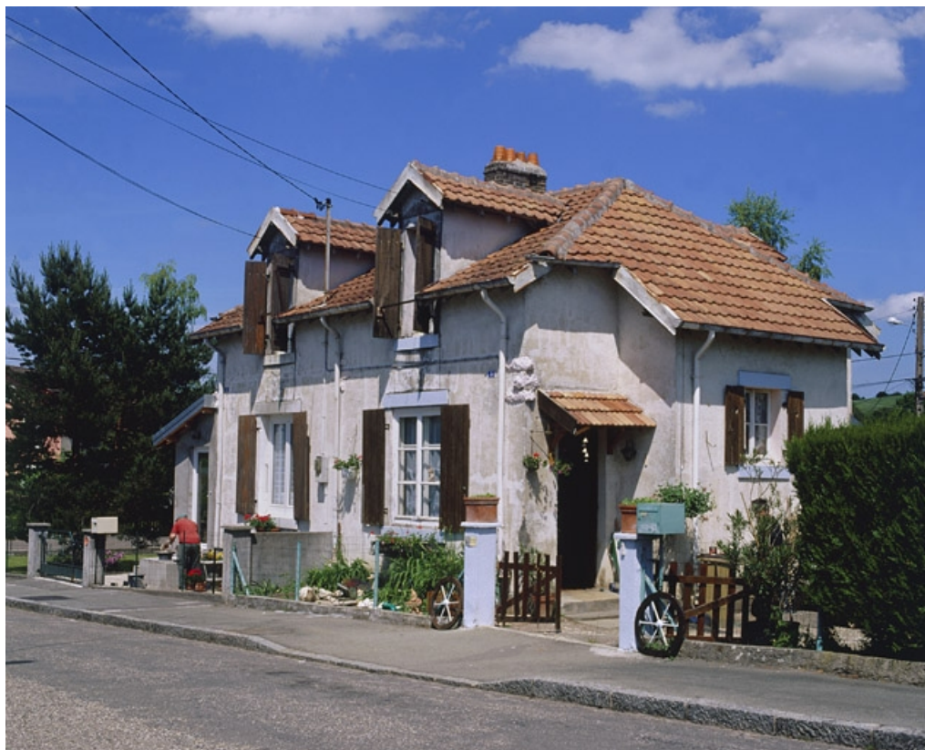
Maison jumelée à 2 travées : vue de trois quarts droite.
