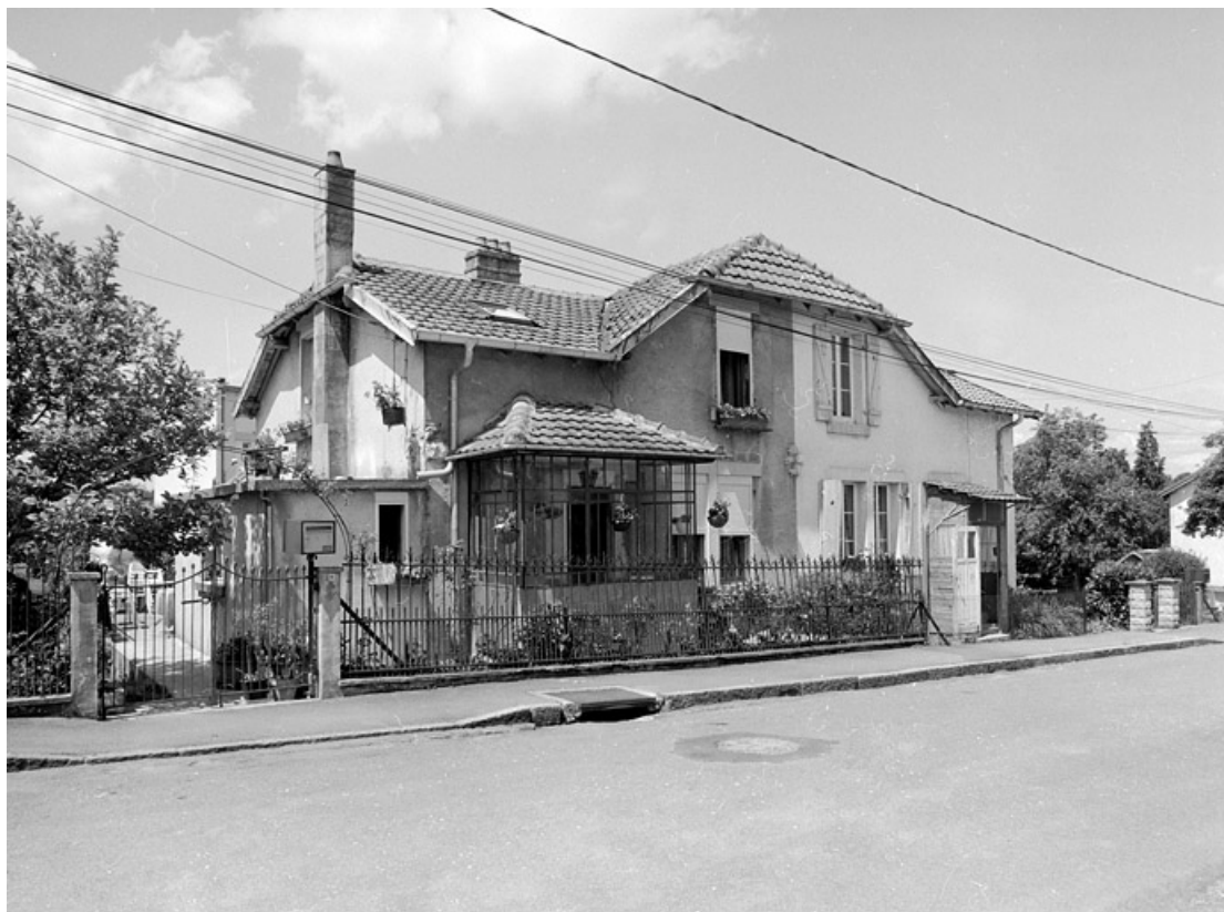
Maison jumelée rue de Normandie : vue de trois quarts.
