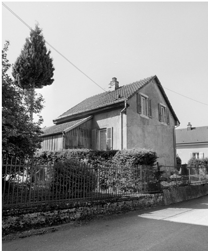
Maison au n° 12 de la rue : vue de trois quarts.
