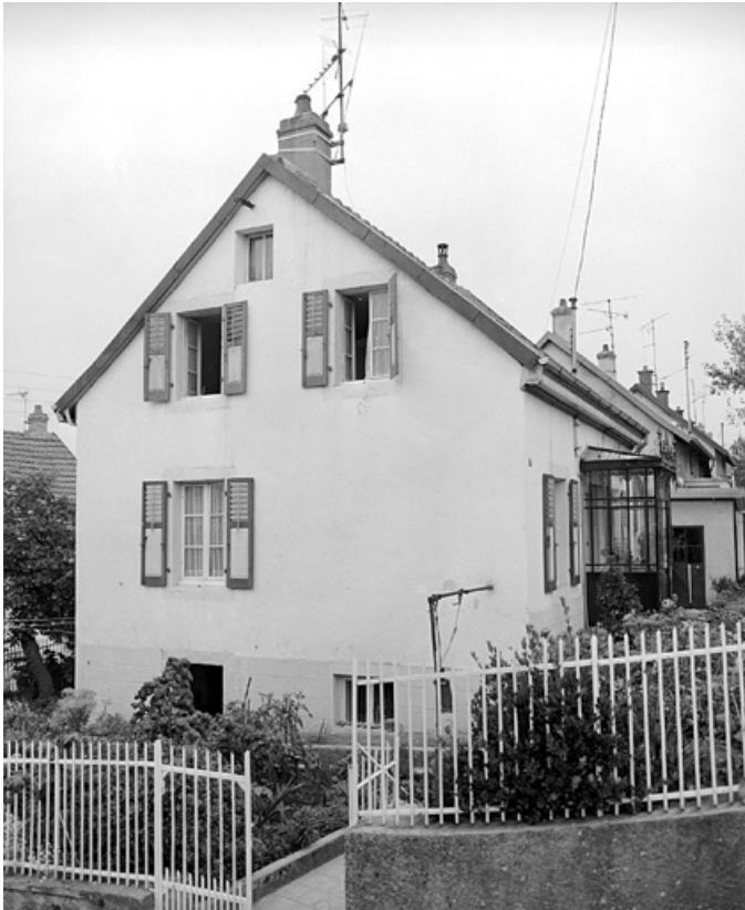
Maison individuelle rue du Réveille-matin : vue de face. SRI. Enquête régionale sur les bâtiments industriels (1979-1981). 90, Beaucourt, lieudit : cité du Chatelot
