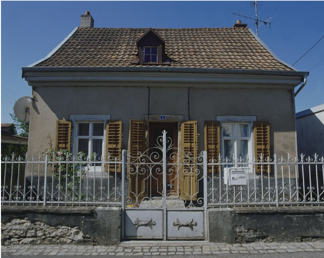
Maison individuelle au n° 4 rue de la Montre : vue de face.
