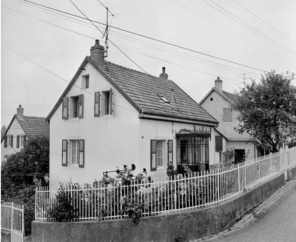
Maison individuelle rue du Réveille-matin : vue de trois quarts. SRI. Enquête régionale sur les bâtiments industriels (1979-1981). 90, Beaucourt, lieudit : cité du Chatelot
