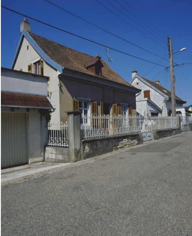
Maison individuelle au n° 4 rue de la Montre : vue de trois quarts. 90, Beaucourt, lieu-dit : cité du Chatelot
