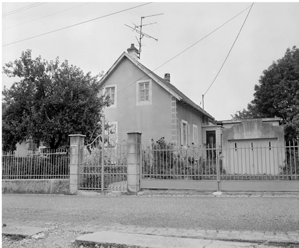
Maison individuelle au n° 6 de la rue du Réveille-matin. SRI. Enquête régionale sur les bâtiments industriels (1979-1981). 90, Beaucourt, lieudit : cité du Chatelot
