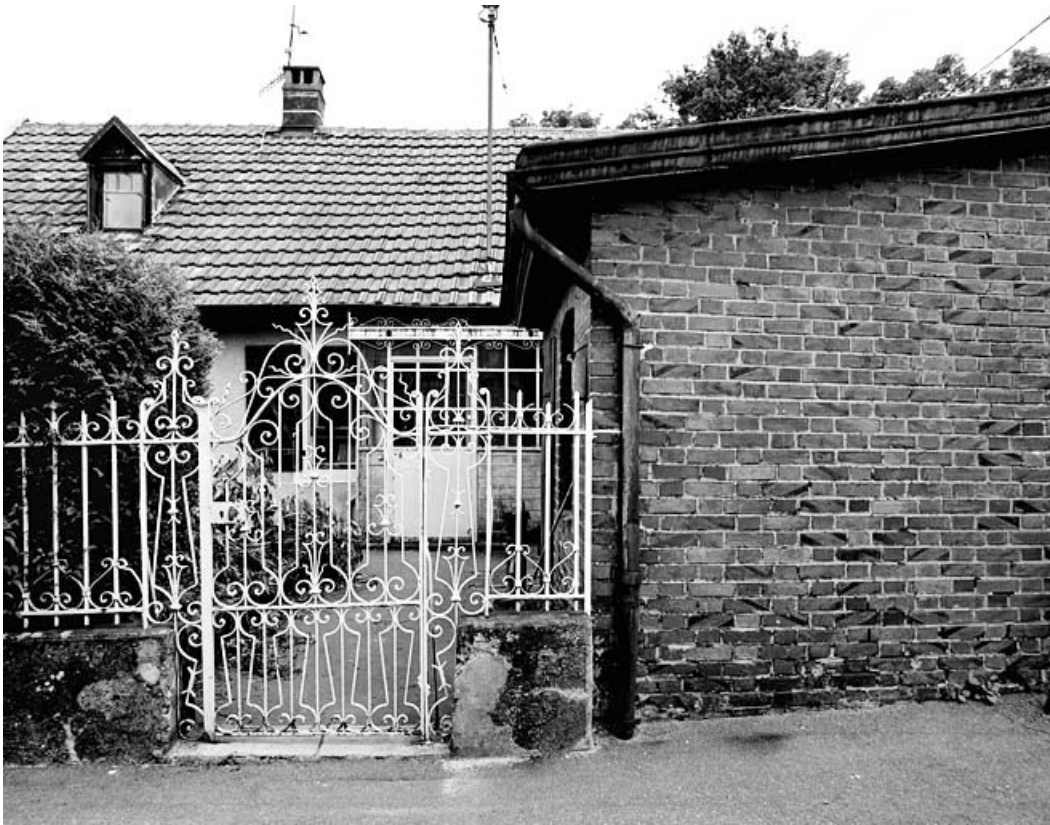
Maison individuelle n° 9 rue du Temple : détail de la grille.
