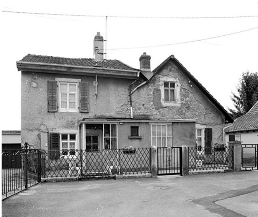
Maison individuelle n° 13 rue du Temple : vue de face.
