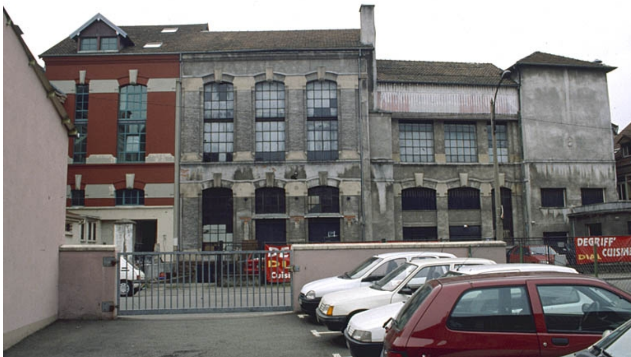
Façade antérieure de l'atelier de fabrication.
