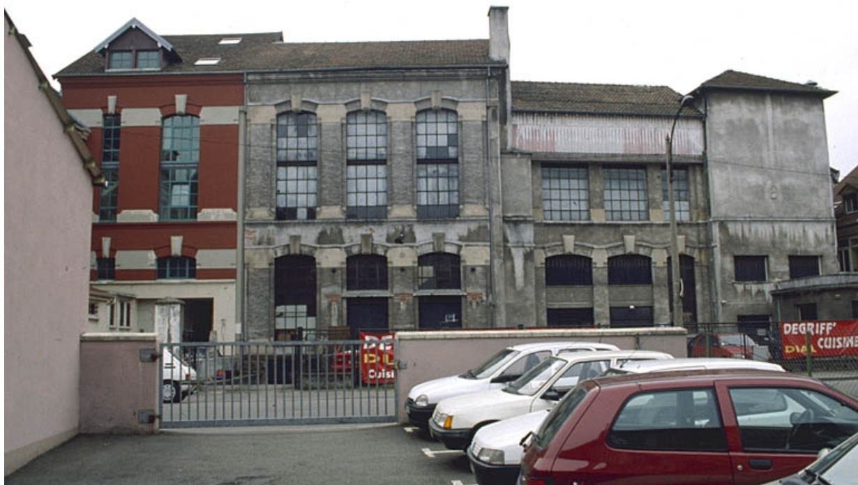
Façade antérieure de l'atelier de fabrication.
