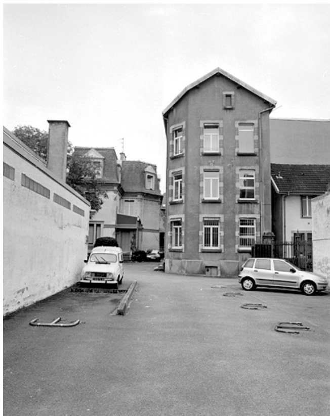
Logement patronal situé à l'arrière du n° 25.
