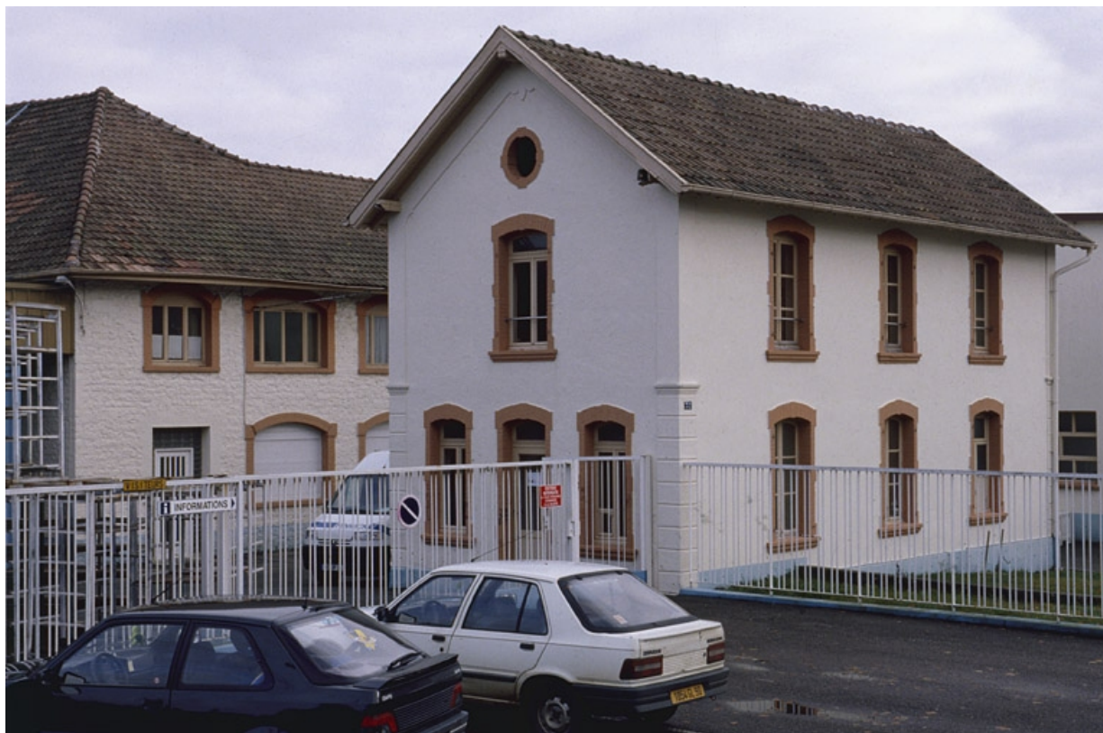
Anciens bureaux (?) de l'usine de teinturerie.
