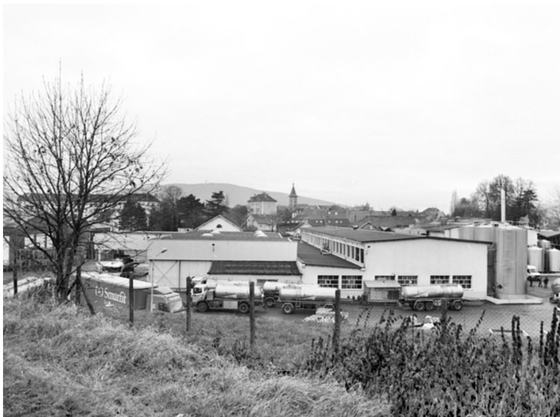
Vue plongeante sur les ateliers depuis l'est.
