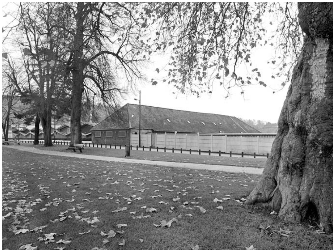
Pignons des nouveaux ateliers de la laiterie et de l'ancien atelier de l'usine de teinturerie.
