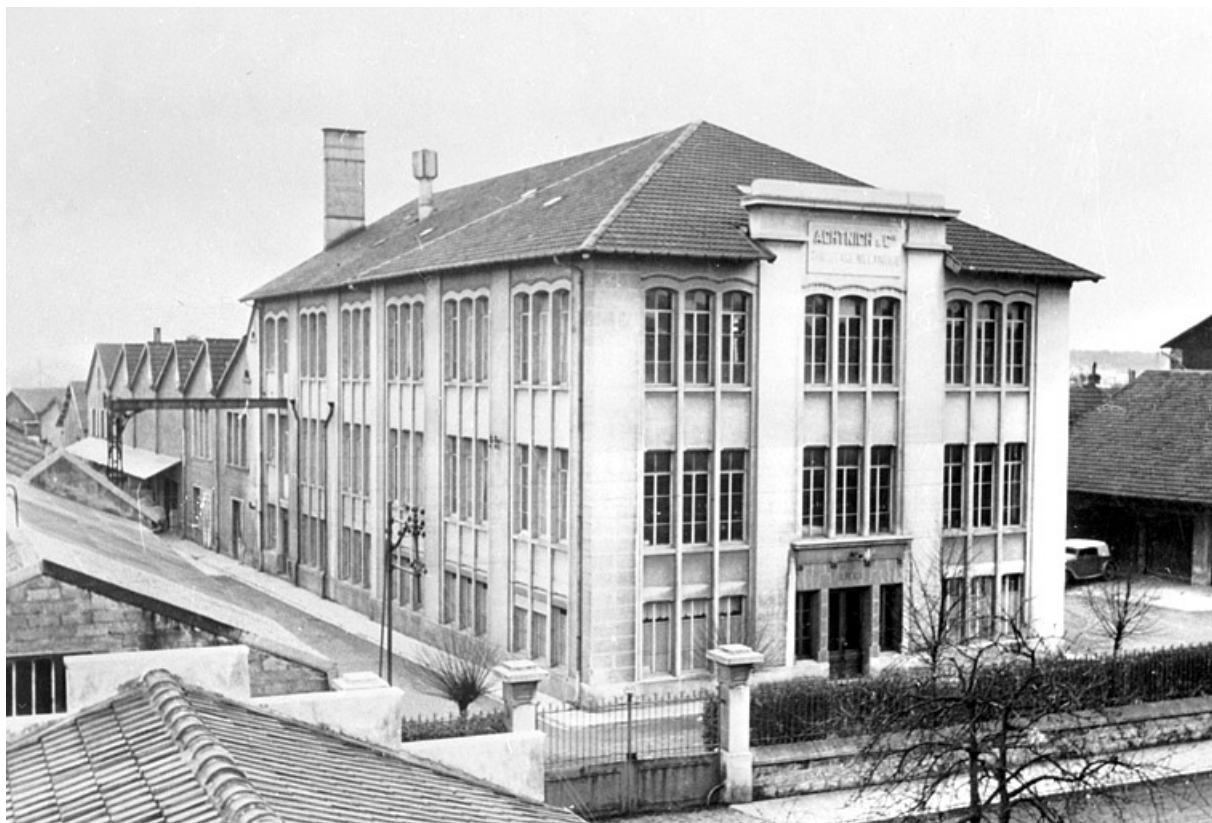
Vue de trois quarts depuis le nord.
