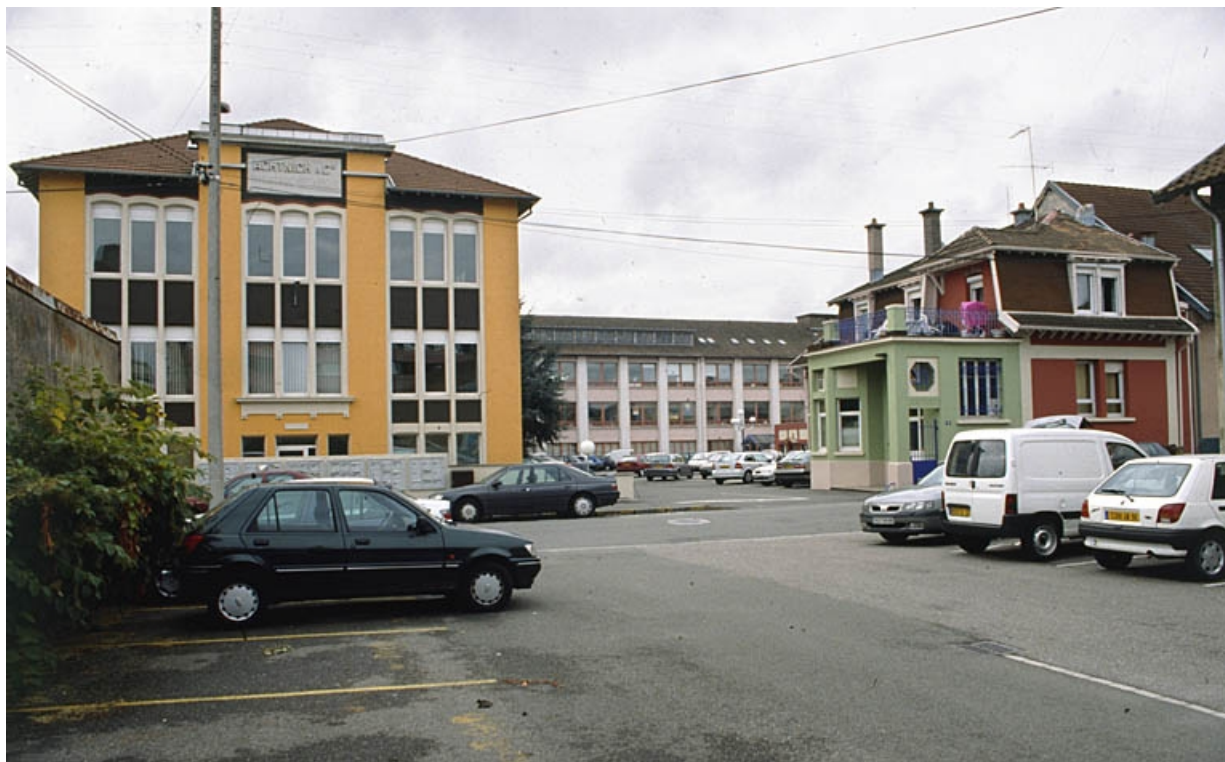
Vue de l'entrée depuis le nord.
