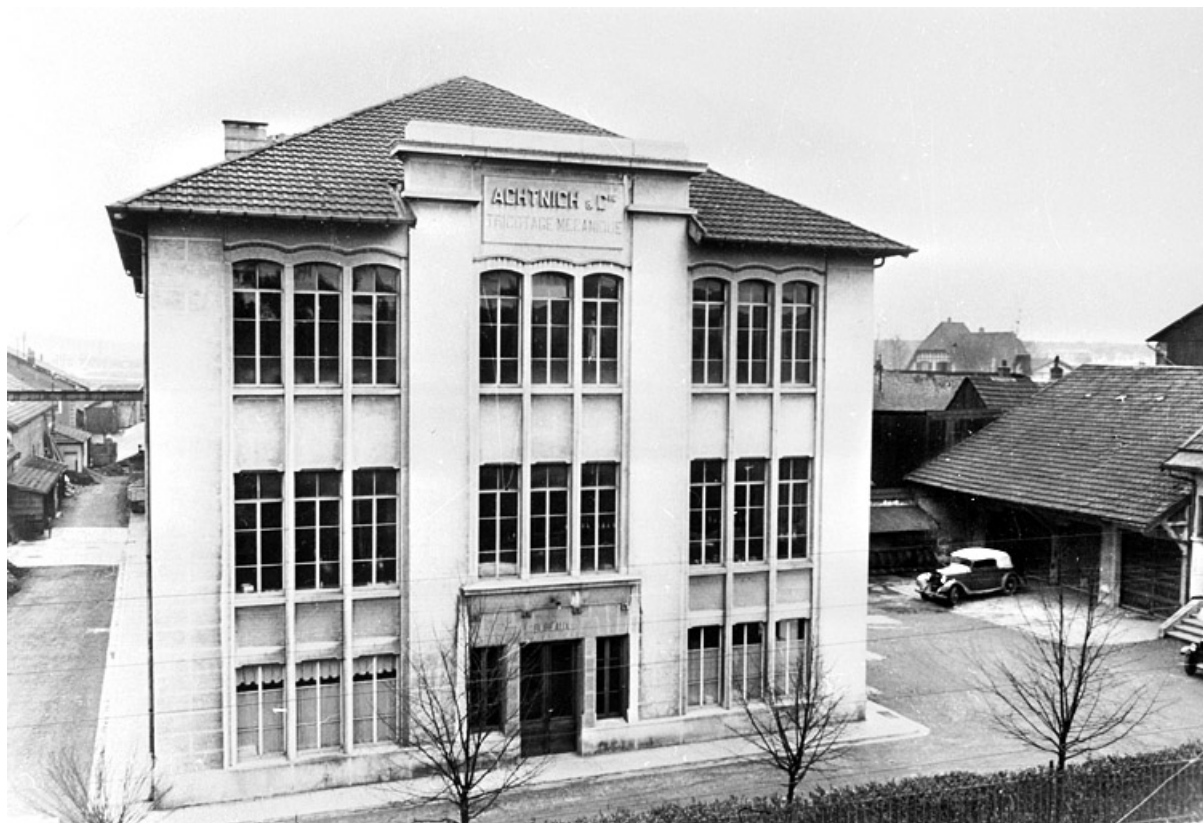
Façade nord de l'usine.
