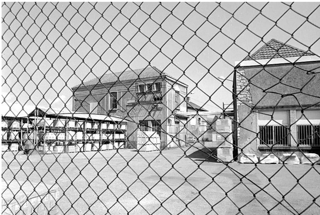
Transformateur électrique (?) vu au travers du grillage depuis la rue du Salbert. 90, Belfort, 223 bis avenue Jean Jaurès
