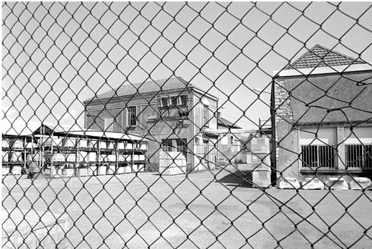
Transformateur électrique (?) vu au travers du grillage depuis la rue du Salbert.
