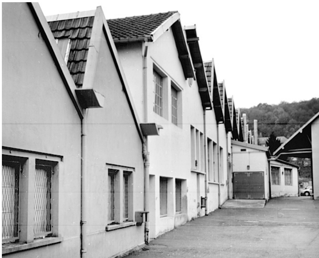
Alignement nord de l'ancien atelier de fabrication.
