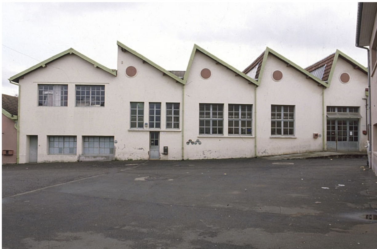
Pignons nord de l'ancien atelier de fabrication.
