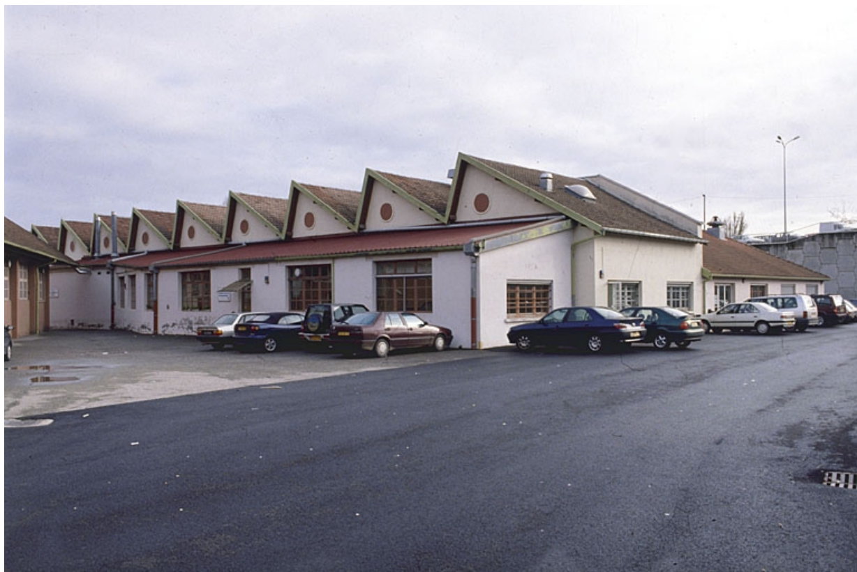
Vue de trois quarts de l'ancien atelier de fabrication.
