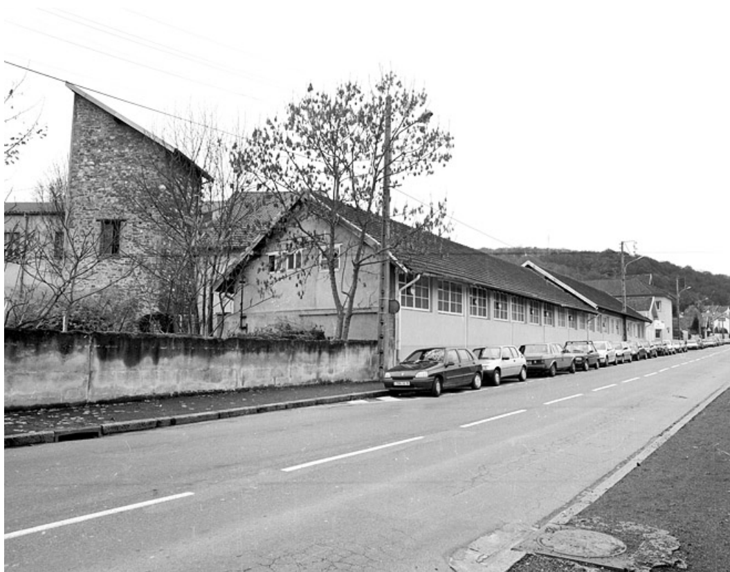
Vue d'ensemble depuis le bas de la rue de Soissons.
