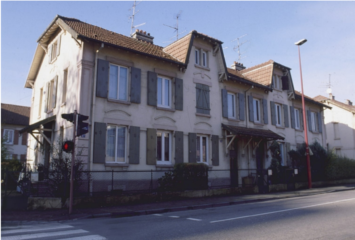
Façade antérieure d'un logement ouvrier rue Voltaire.
