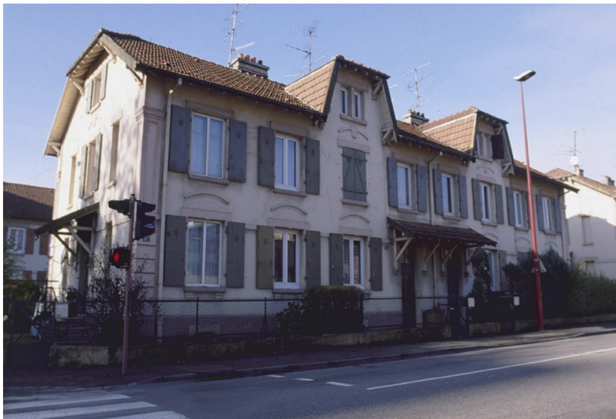
Façade antérieure d'un logement ouvrier rue Voltaire.
