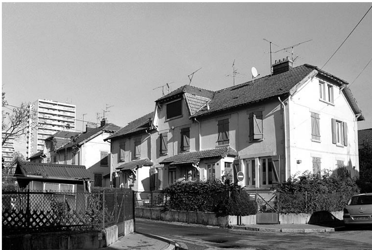
Vue de trois quarts d'un logement ouvrier.
