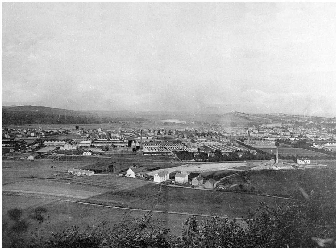
Vue générale de l'usine de Belfort.
