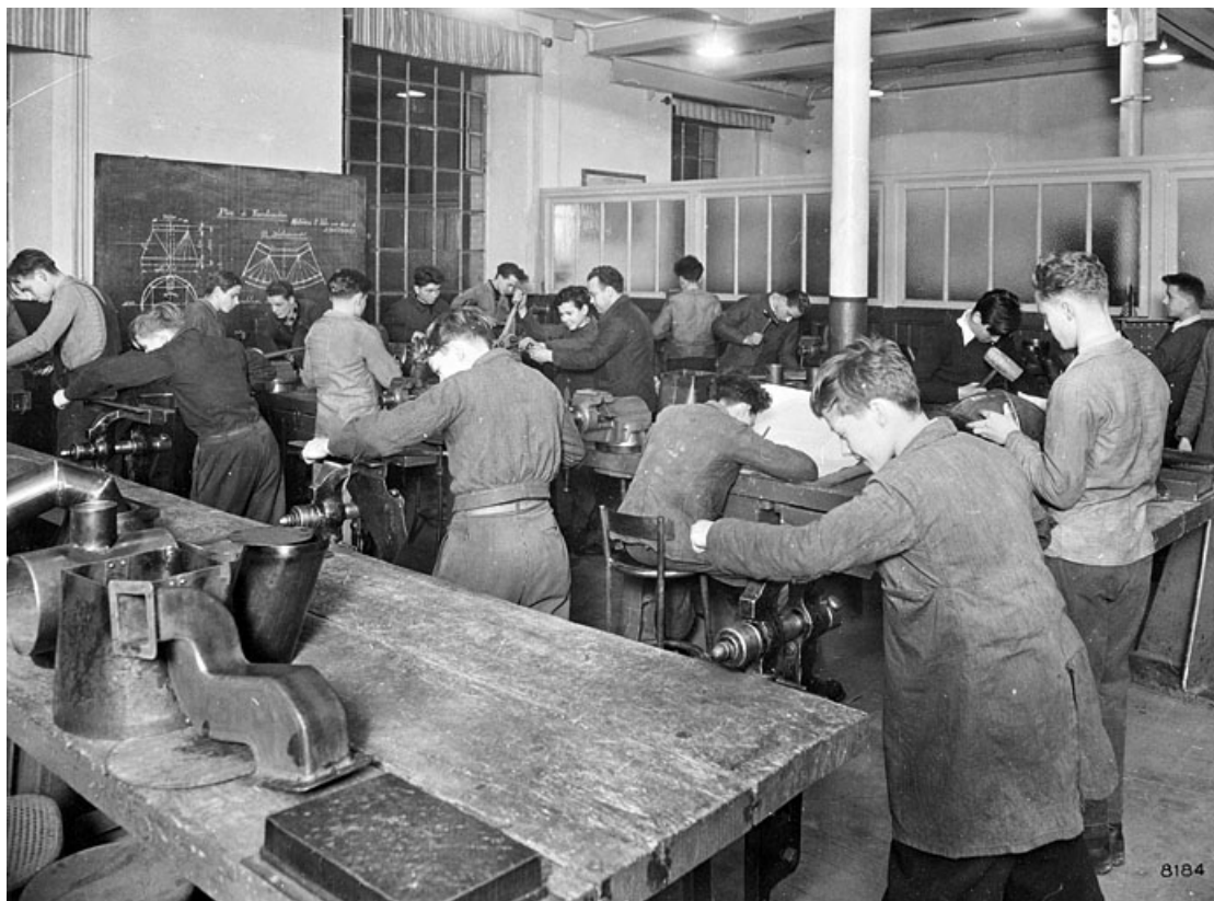
Centre d'apprentissage : atelier d'usinage. 90, Belfort
