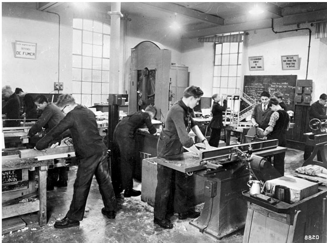
Centre d'apprentissage : atelier de menuiserie. 90, Belfort
