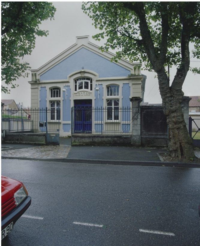
Façade de l'ancienne salle de répétition de l'harmonie. 90, Belfort
