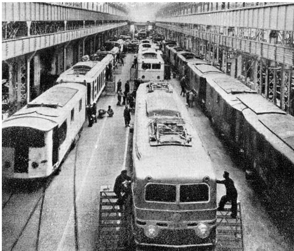
Hall de montage des locomotives électriques.
