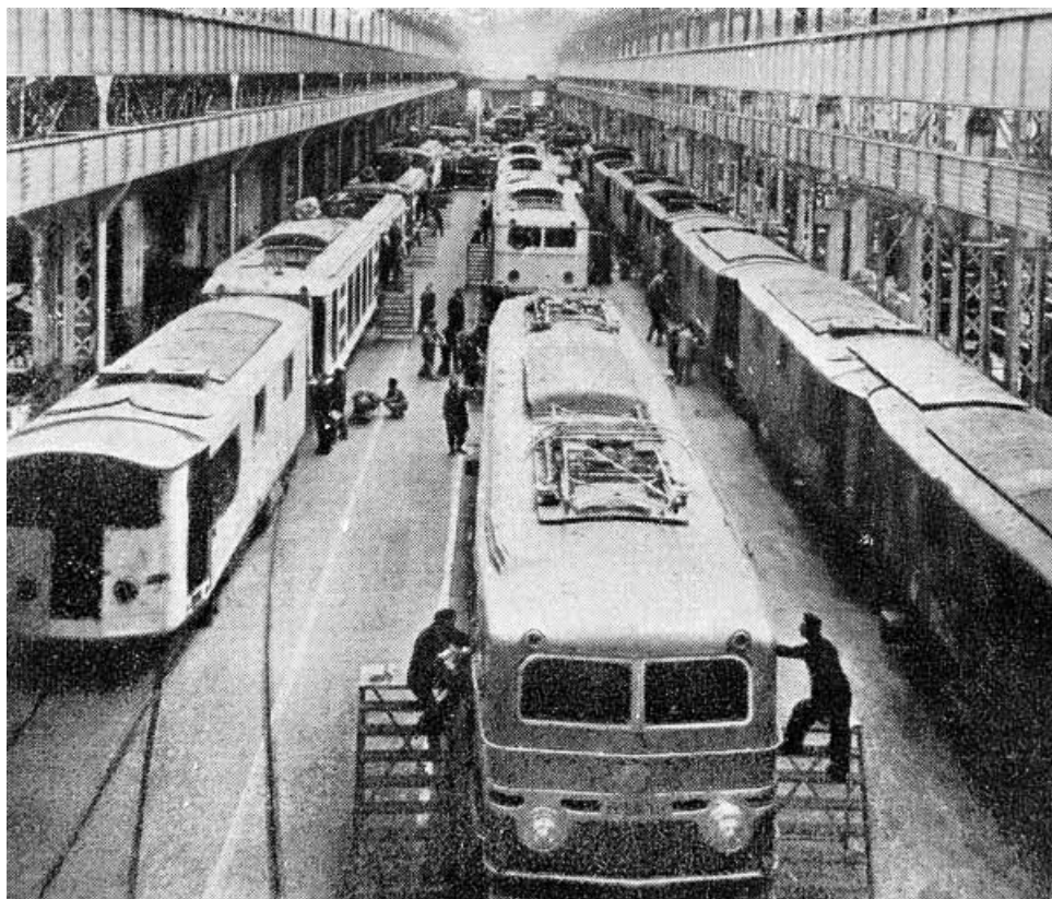
Hall de montage des locomotives électriques.
