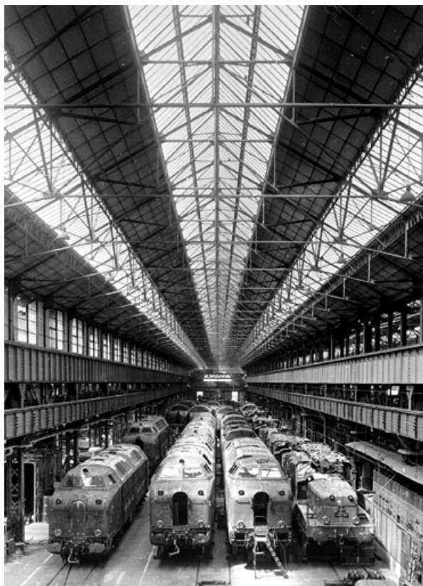
Hall de montage des locomotives diesel-électriques. 90, Belfort
