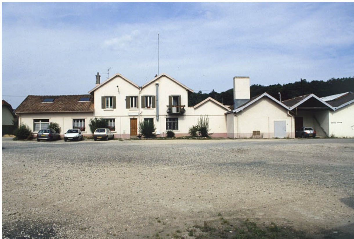
Façade postérieure des bâtiments sur rue.
