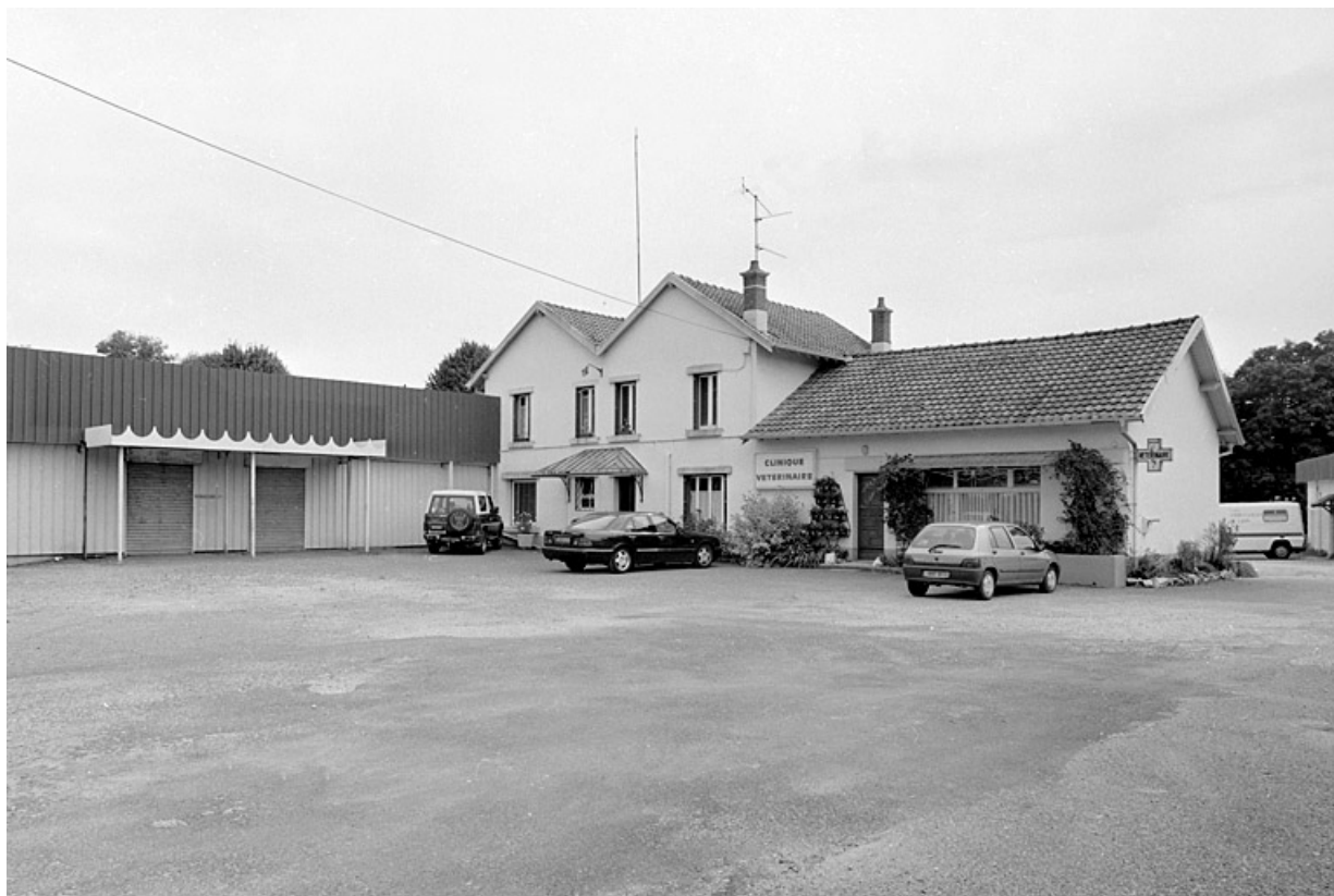
Façade des bureaux (?).
