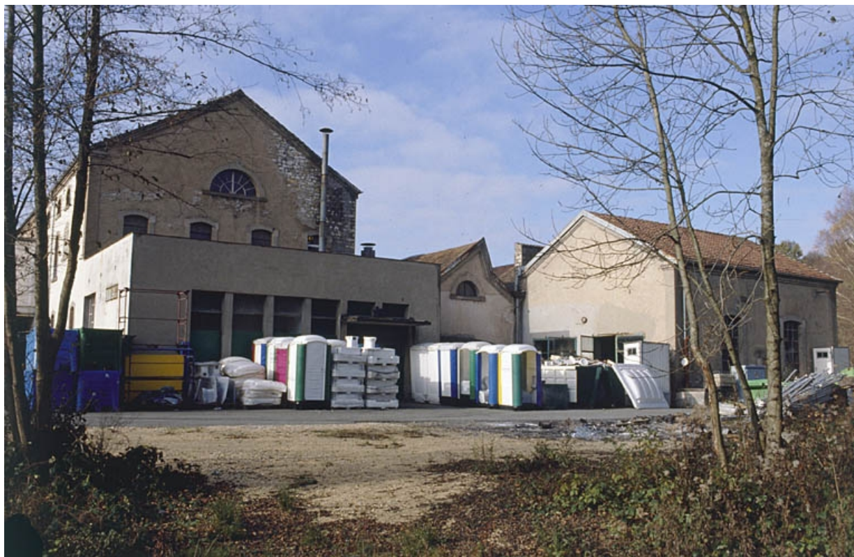
Façades postérieures : atelier de fabrication et salle des machines.
