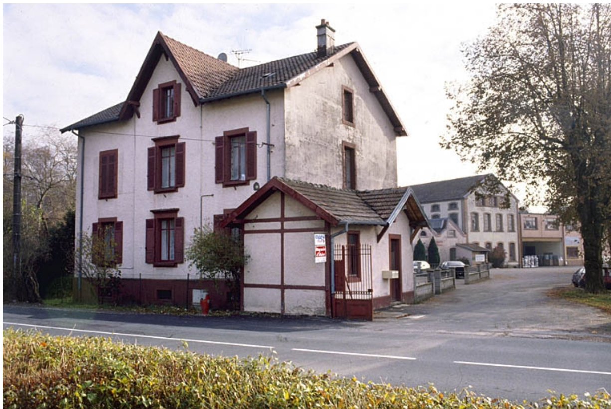
Vue d'ensemble depuis l'entrée.
