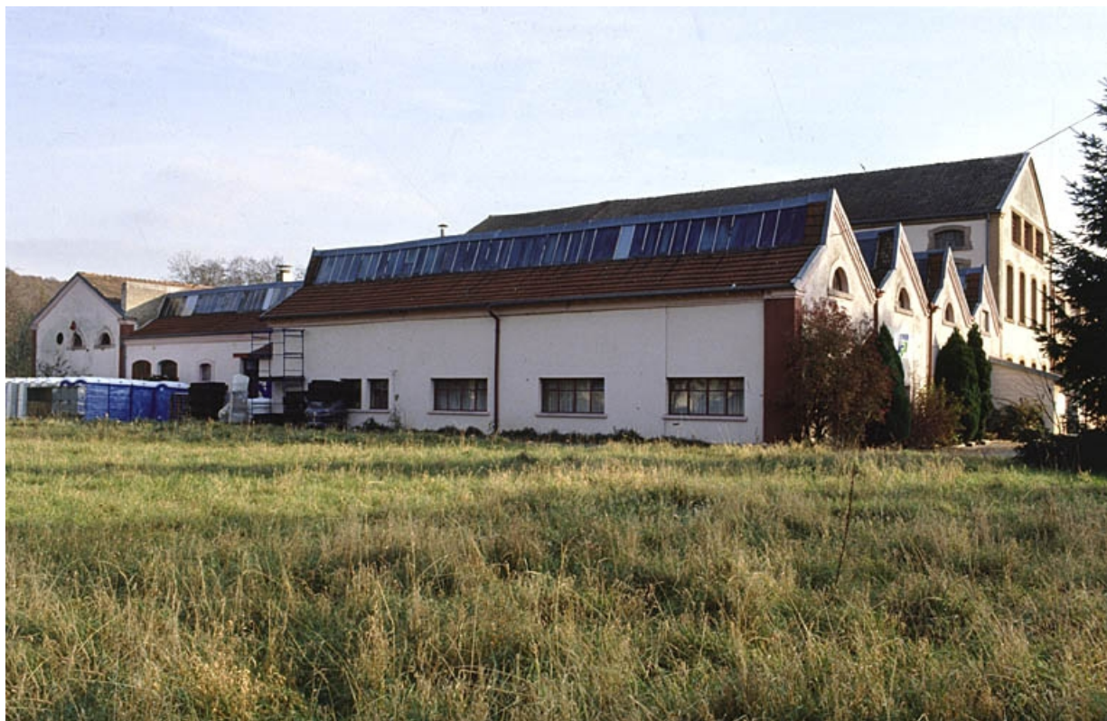
Vue de trois quarts depuis l'ouest.
