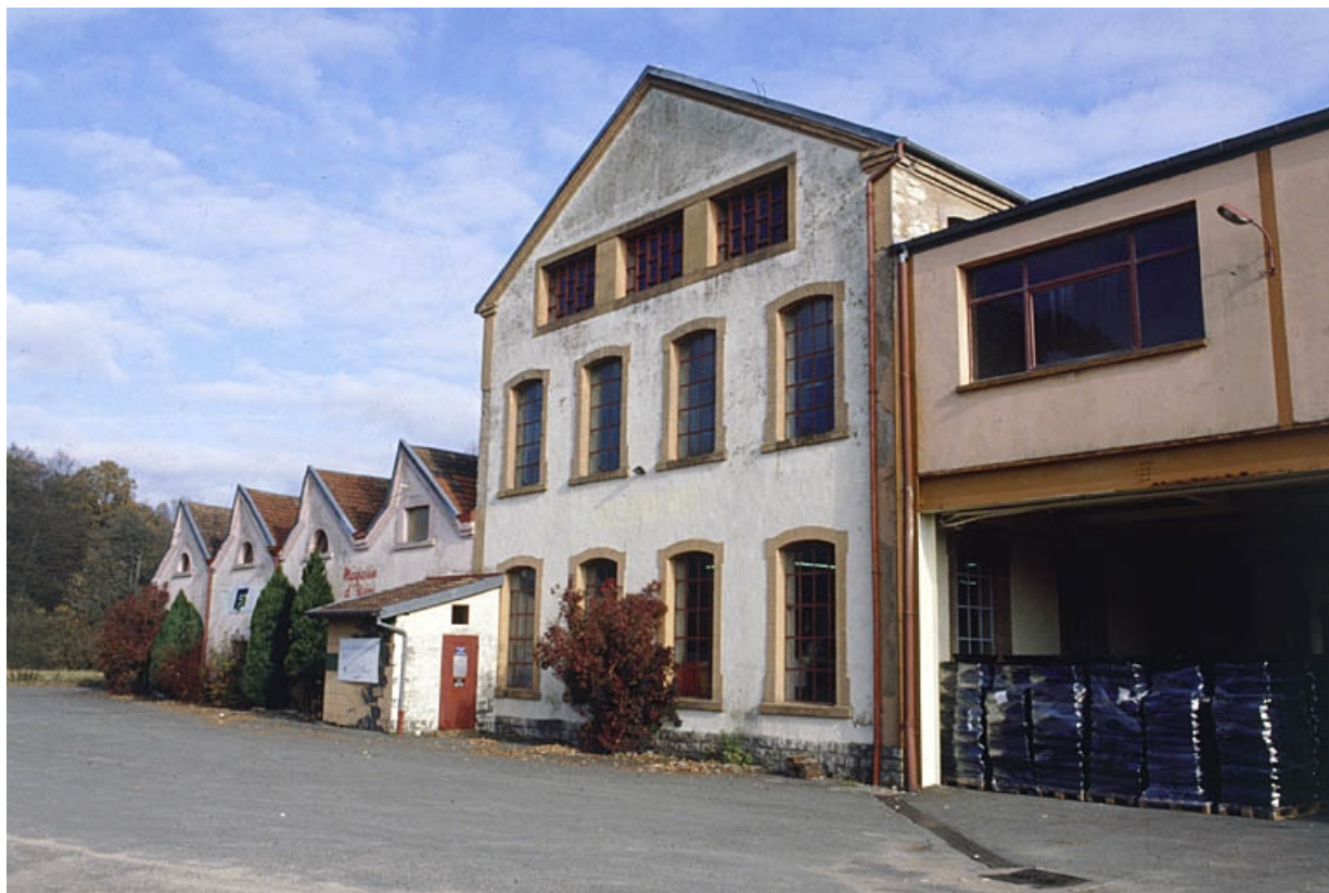
Façades antérieures depuis le sud.
