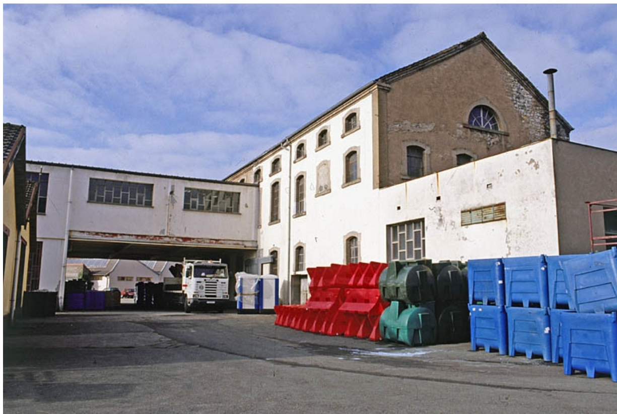
Façade postérieure des ateliers de fabrication.
