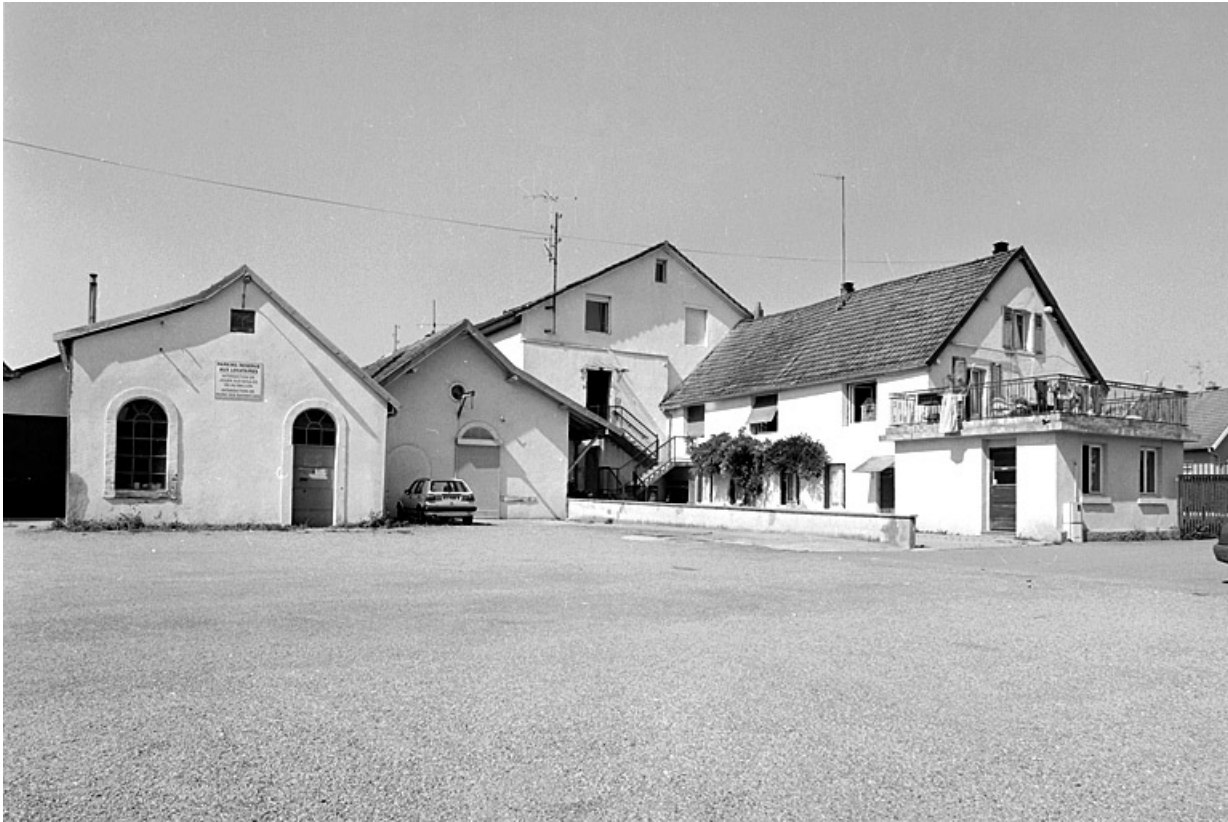
Pignons des ateliers depuis la cour.
