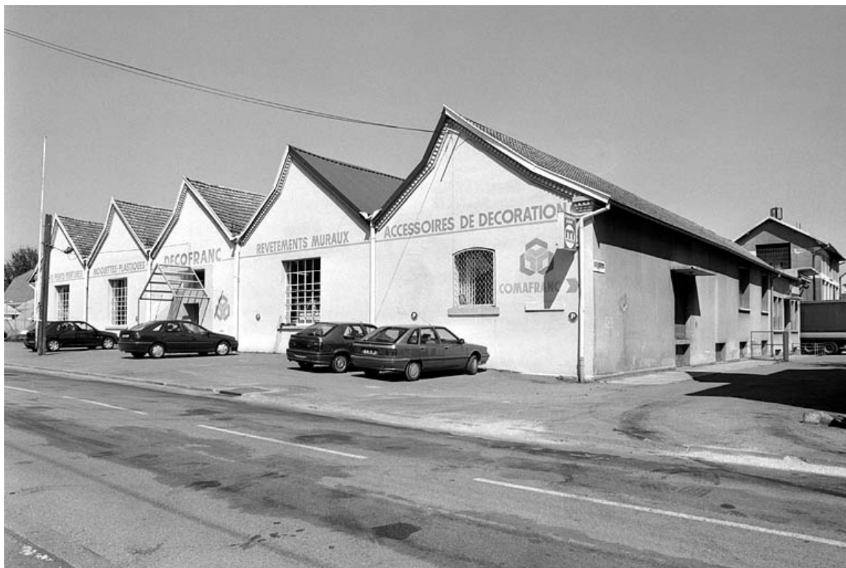
Atelier de fabrication vu depuis le sud.
