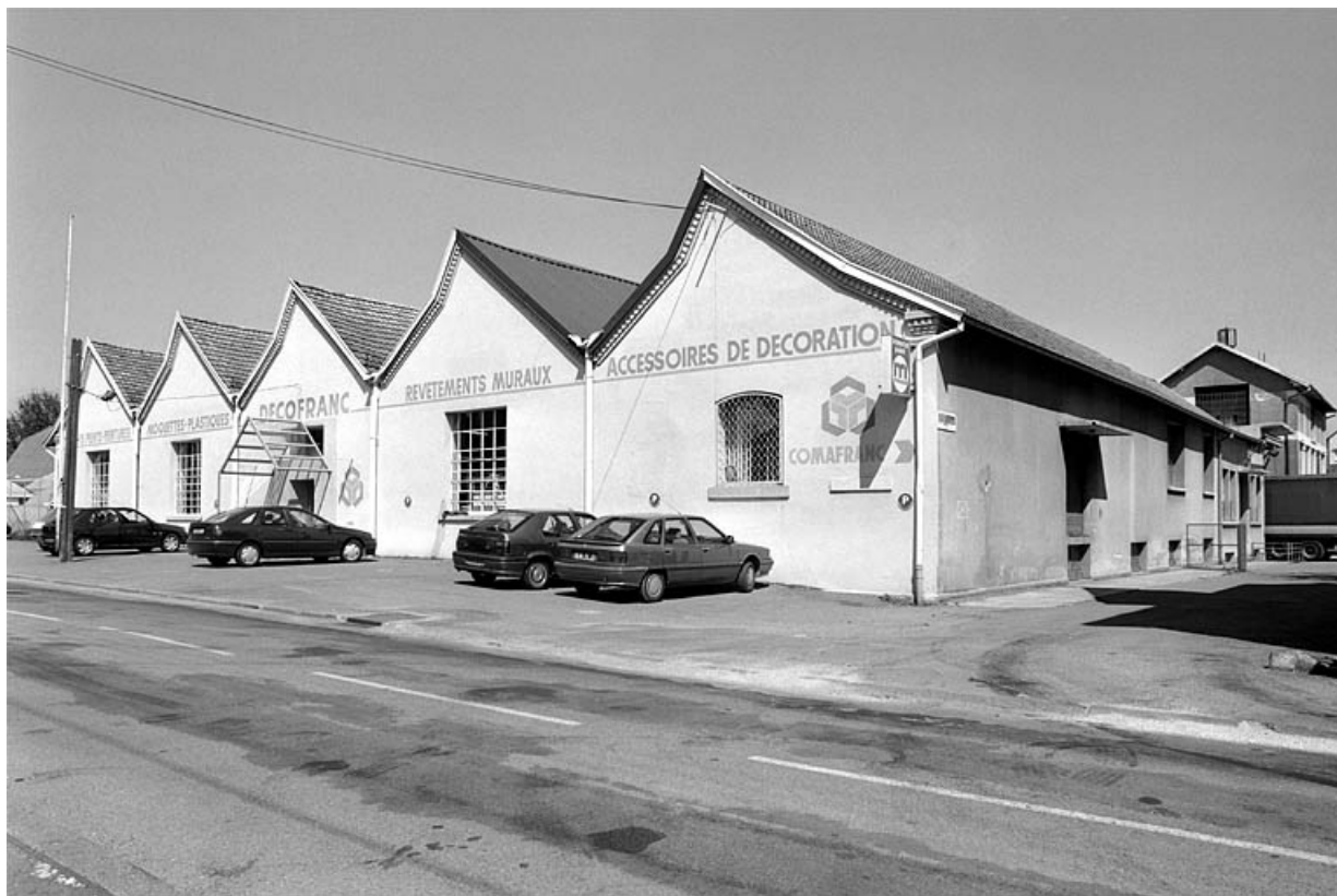
Atelier de fabrication vu depuis le sud.
