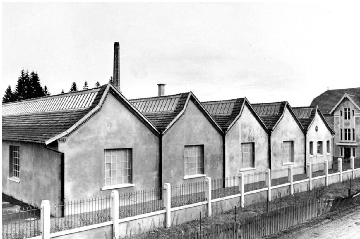
Vue des pignons sur rue vers 1945.
