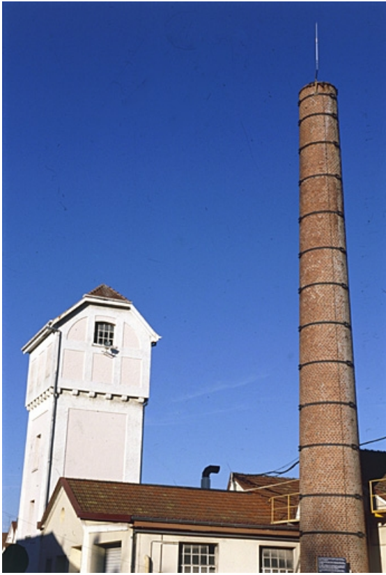
Réservoir industriel et cheminée depuis le sud-ouest.
