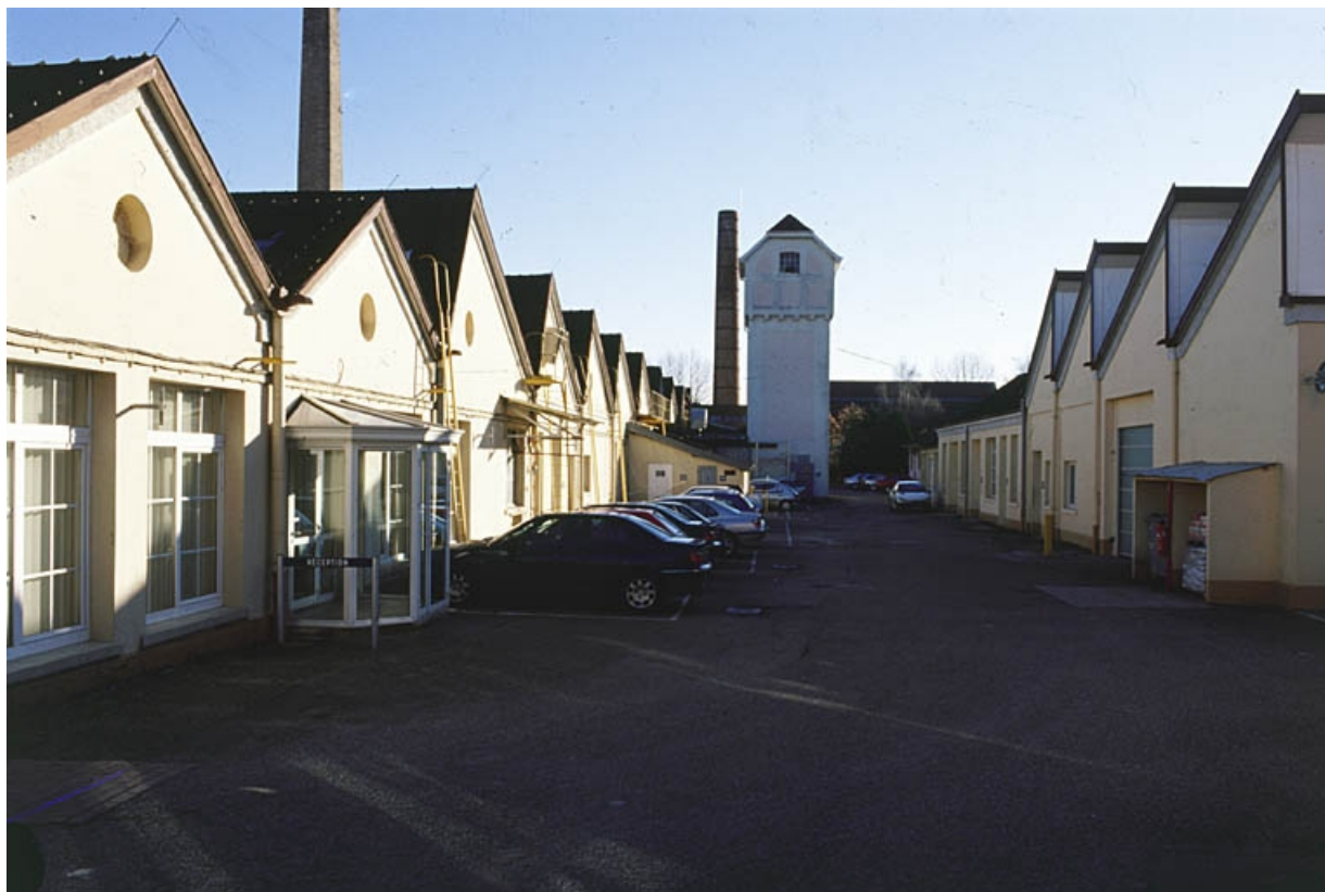
Ateliers de fabrication, cheminée, réservoir industriel et magasins industriels depuis le nord.
