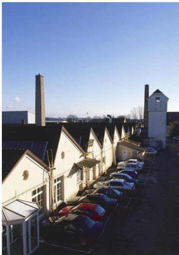
Vue plongeante sur les pignons ouest de l'atelier de fabrication.
