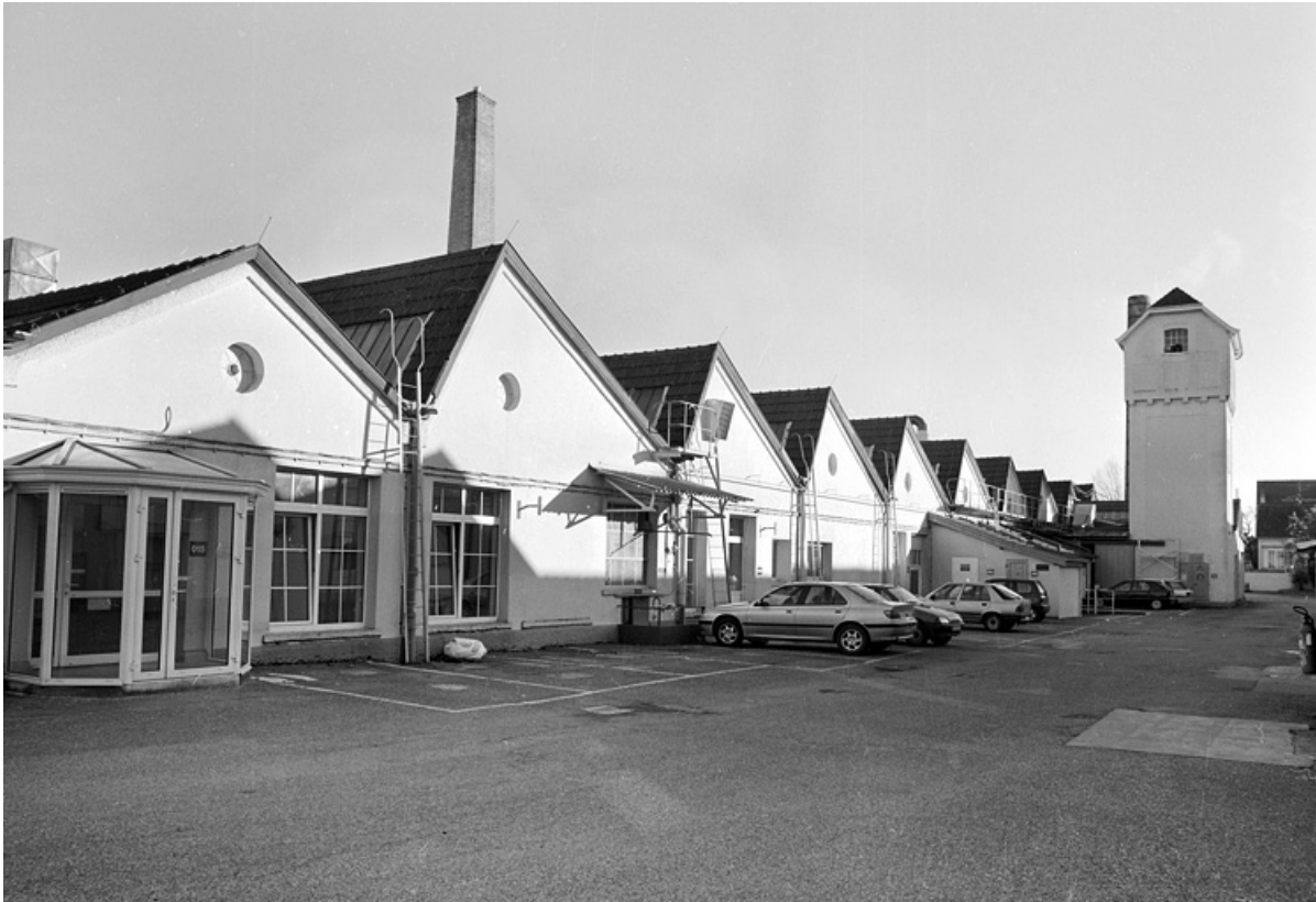
Pignons ouest de l'atelier de fabrication.
