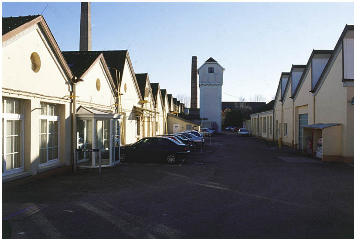
Ateliers de fabrication, cheminée, réservoir industriel et magasins industriels depuis le nord. 90, Valdoie, 2 rue Jean Jaurès
