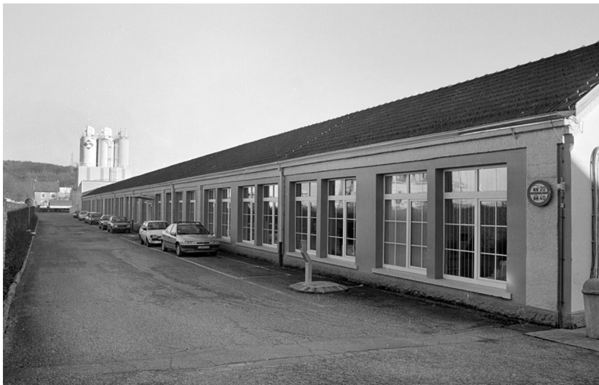
Façade nord de l'atelier de fabrication.
