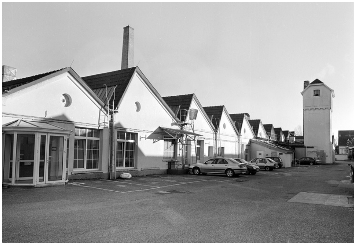
Pignons ouest de l'atelier de fabrication.
