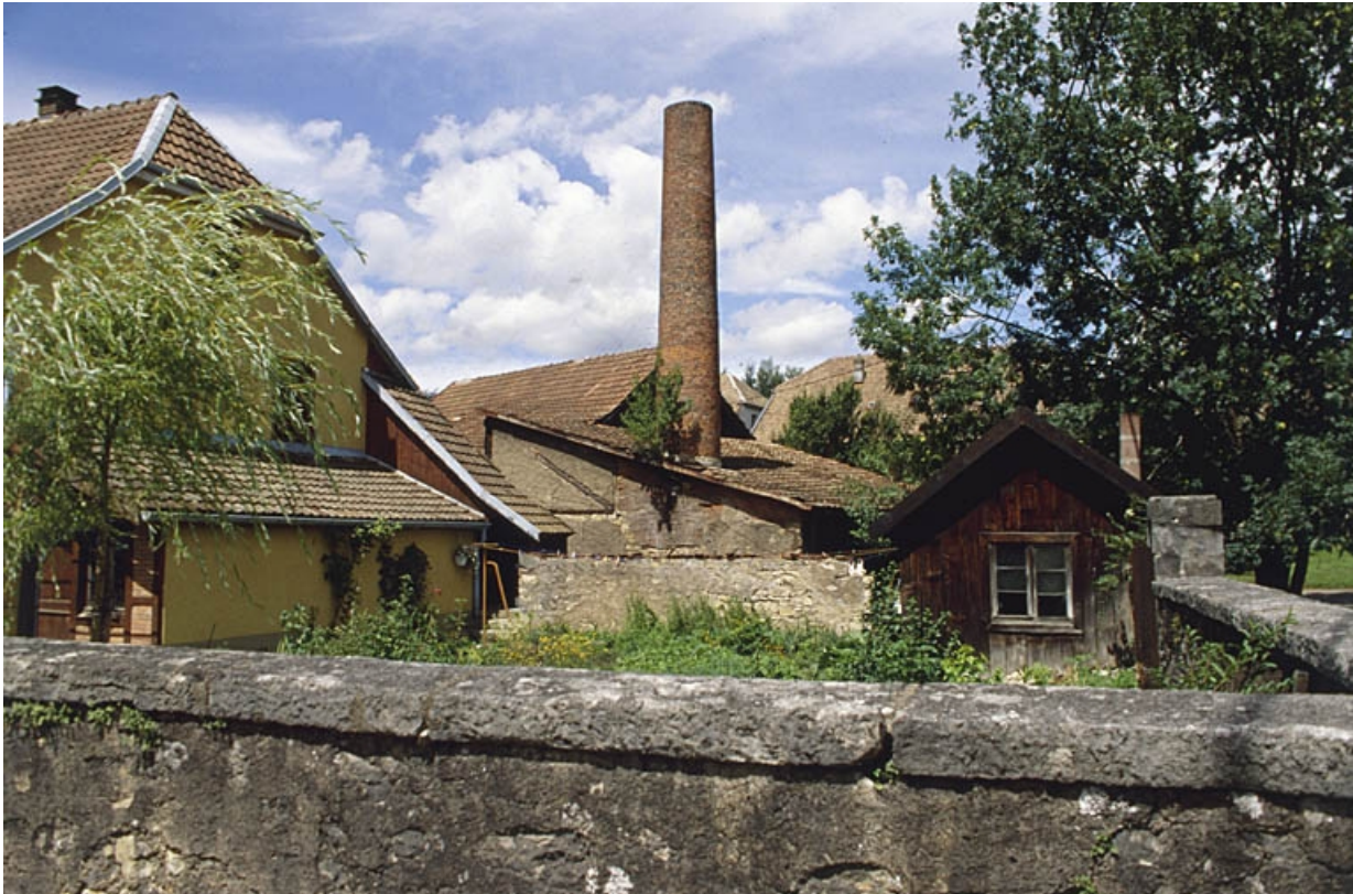
Vue en amont de la Batte.
