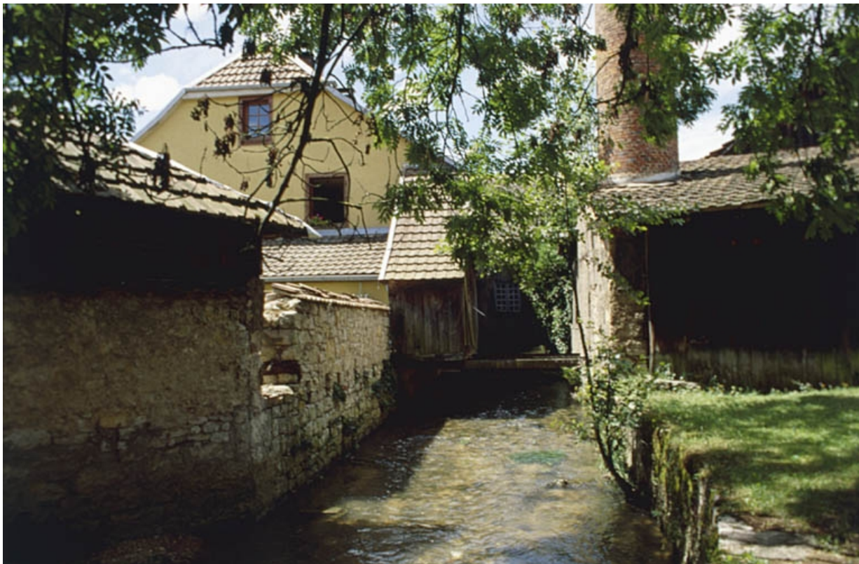
Vue en aval de la Batte.
