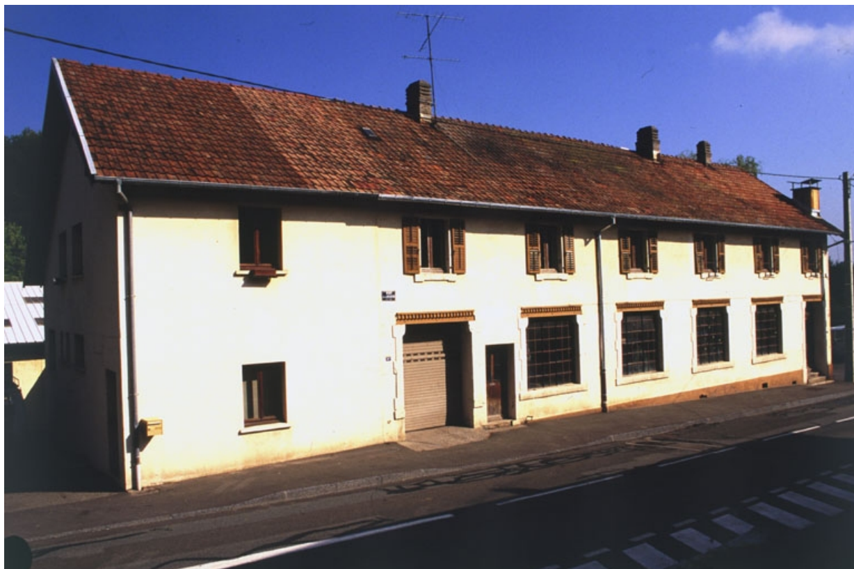
Façade sur rue de l'atelier de fabrication.
