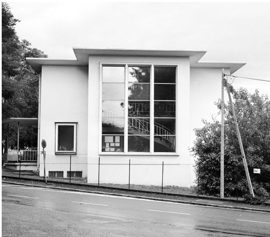
Façade nord du bâtiment administratif d'entreprise.
