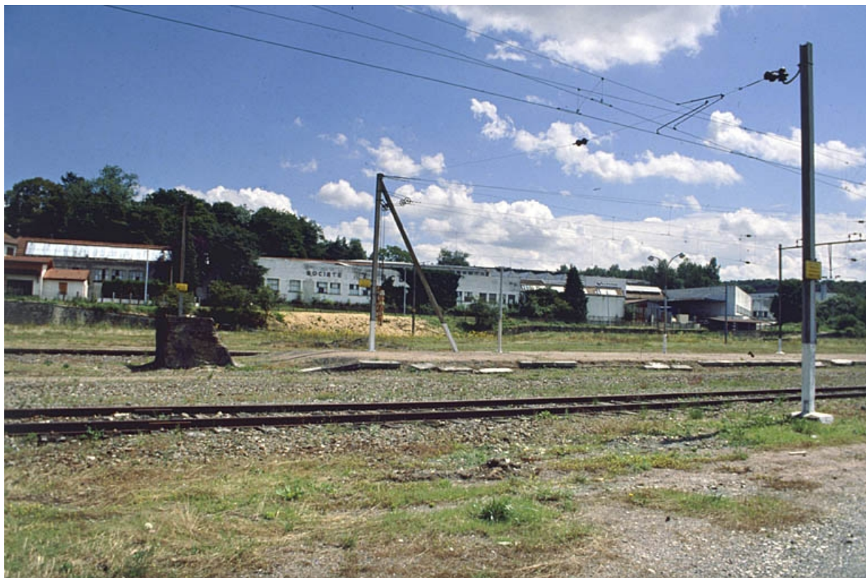
Vue d'ensemble depuis l'ouest.
