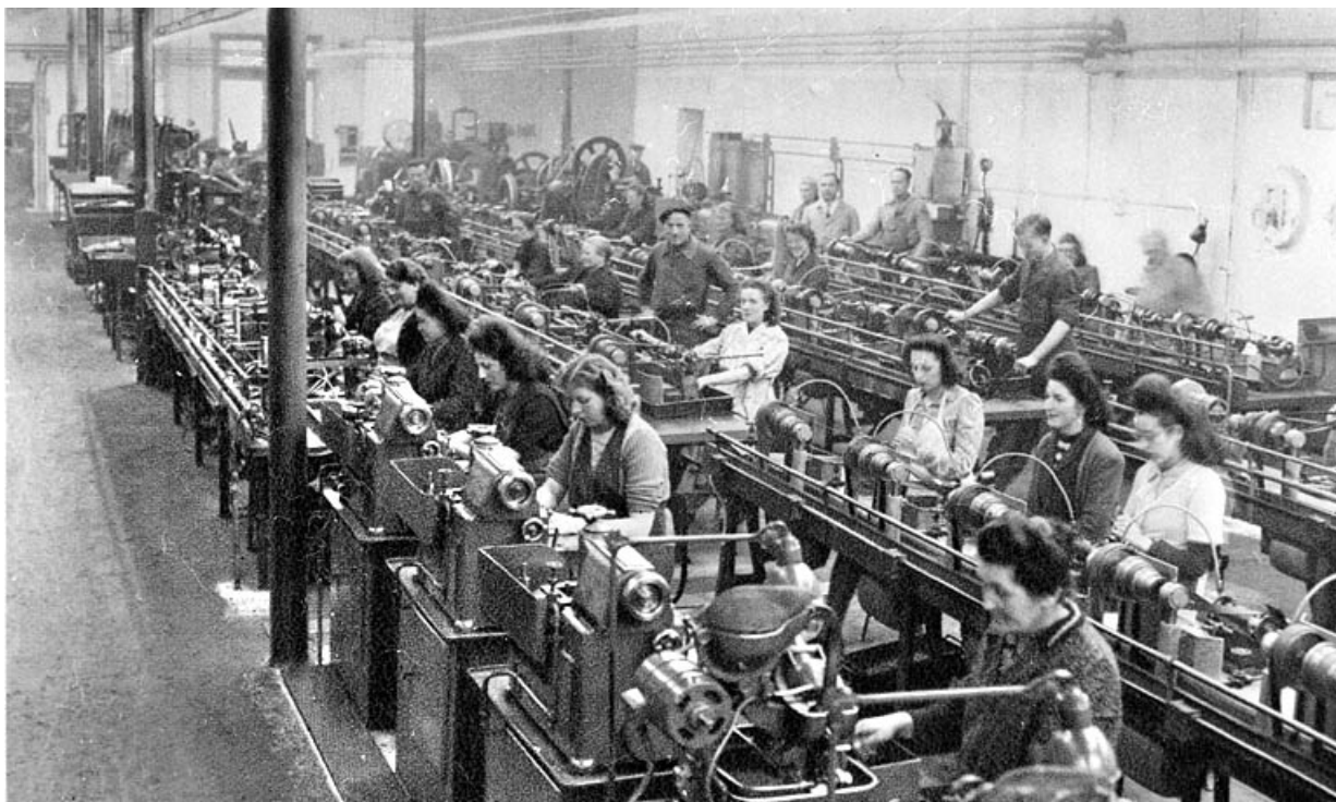
Atelier de reprises : batteries de petites machines.
