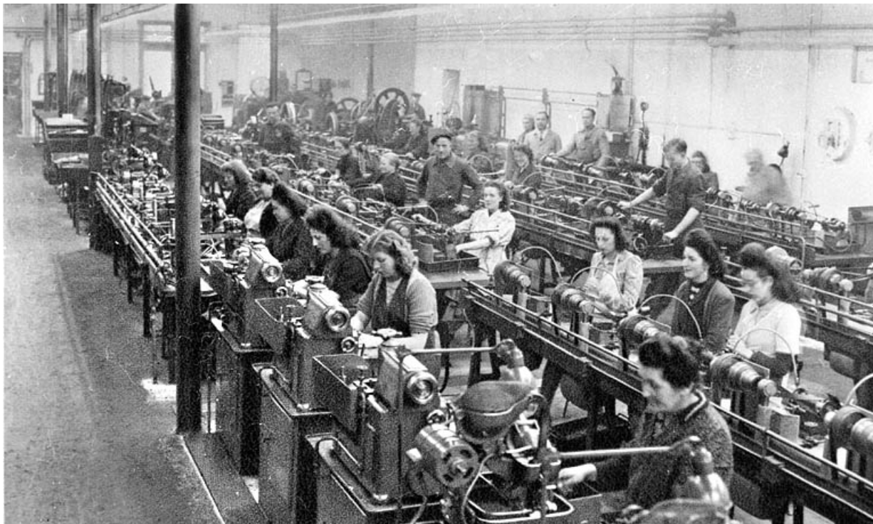
Atelier de reprises : batteries de petites machines.
