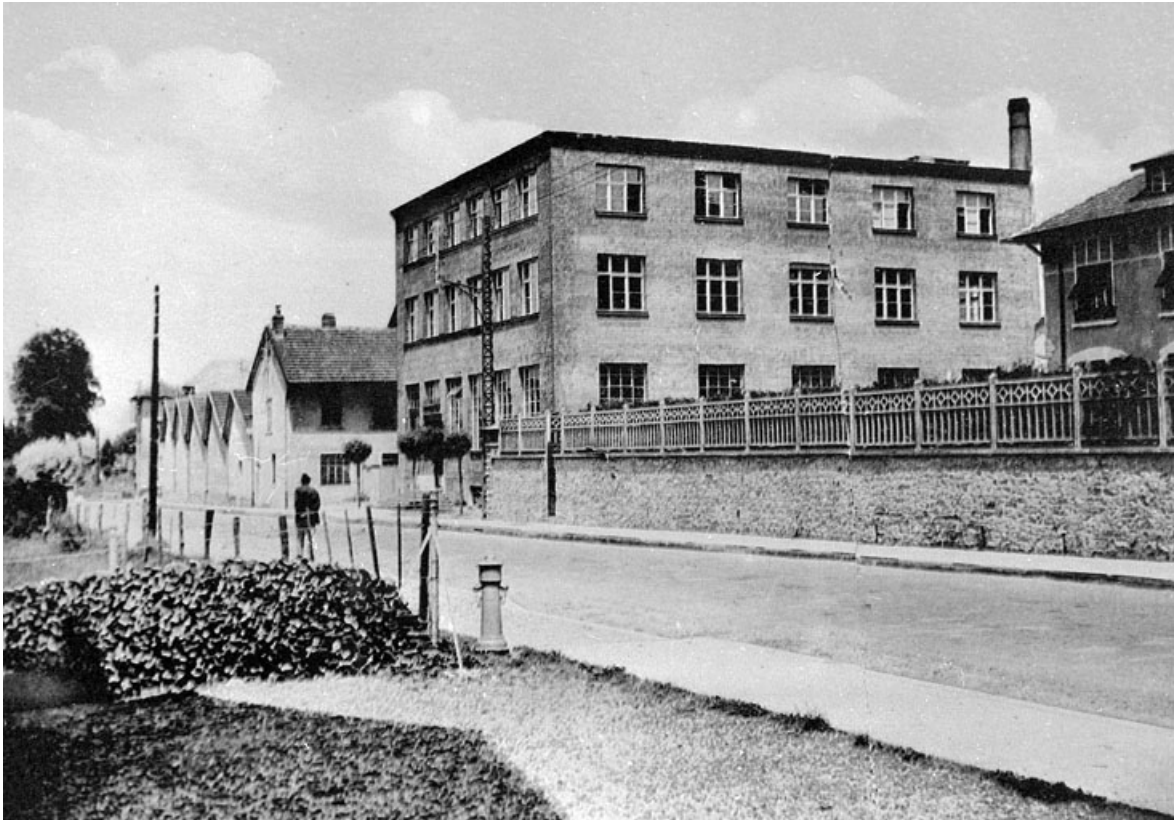
Delle. - Usine Société Industrielle. 90, Delle, 28 faubourg de Belfort
