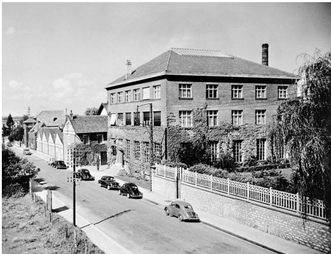
Atelier de traitement de surface des métaux et bâtiment administratif sur le faubourg de Belfort. 90, Delle, 28 faubourg de Belfort
