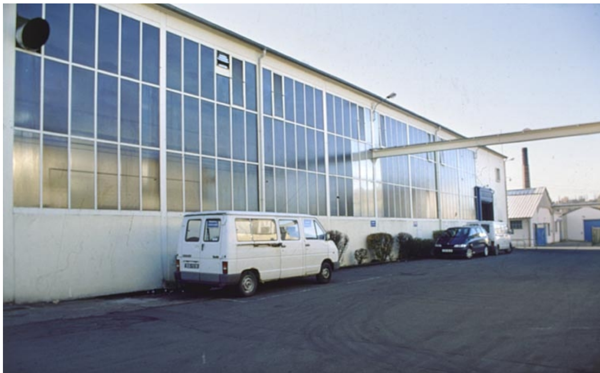
Façade vitrée de l'atelier de traitement de surface.
