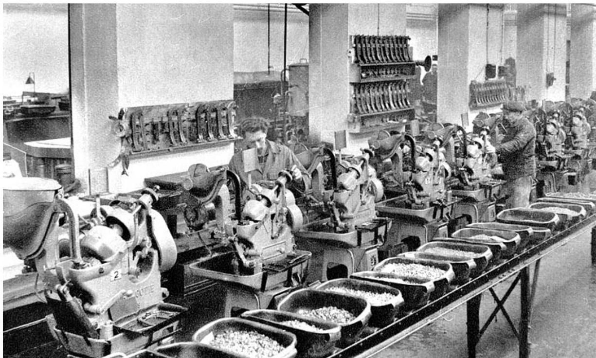
Machines automatiques à tarauder les écrous.
