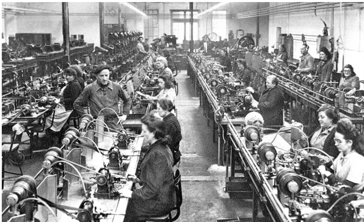
Partie de l'atelier de reprises. 90, Delle, 28 faubourg de Belfort
