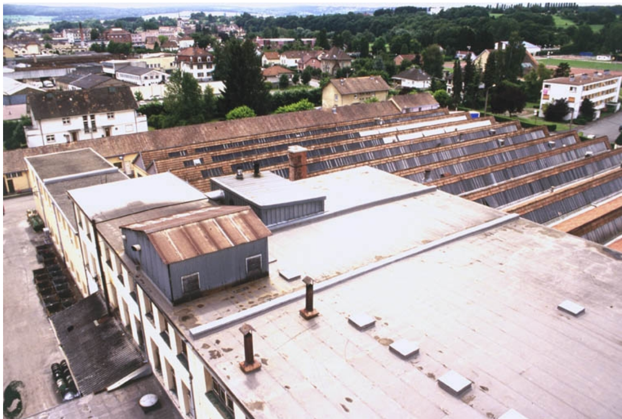
Terrasse de l'atelier d'émaillage et sheds des ateliers de fabrication en rez-de-chaussée. 90, Delle, 48 faubourg de Belfort
