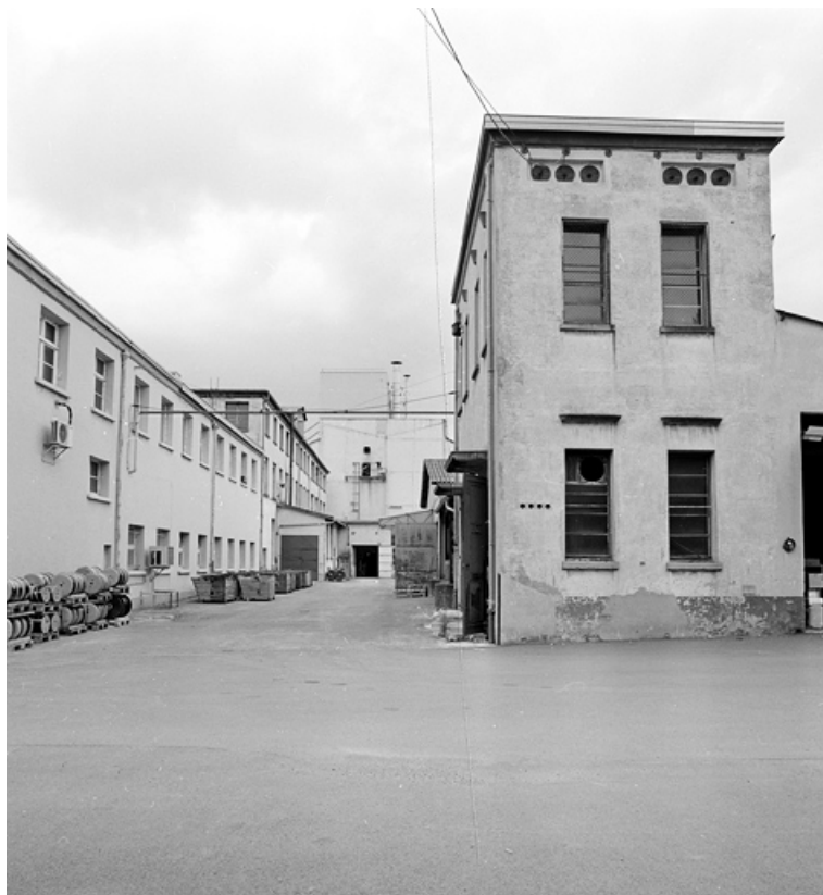
Bureau d'études (à gauche) et transformateur.
