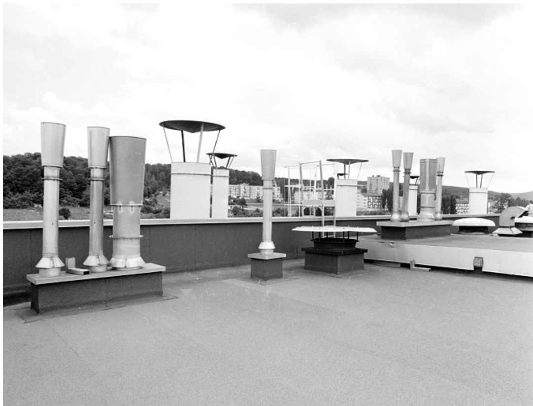
Cheminées sur la terrasse supérieure de l'atelier d'émaillage.
