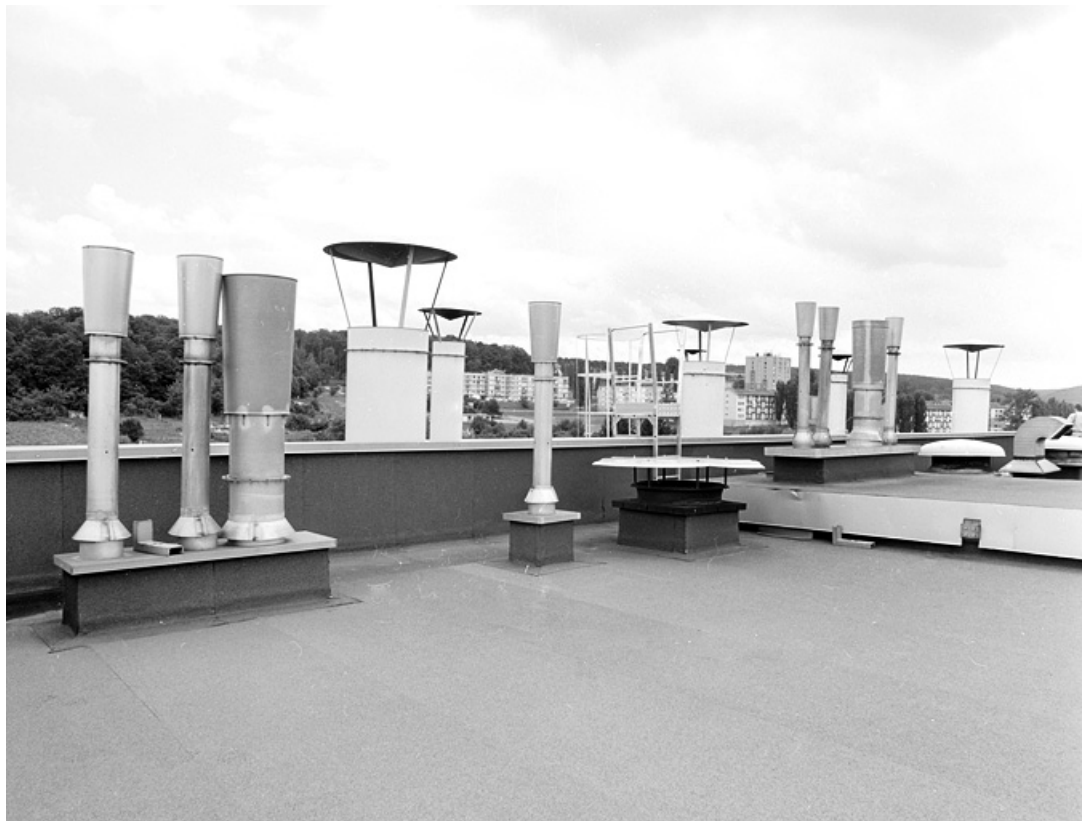
Cheminées sur la terrasse supérieure de l'atelier d'émaillage.
