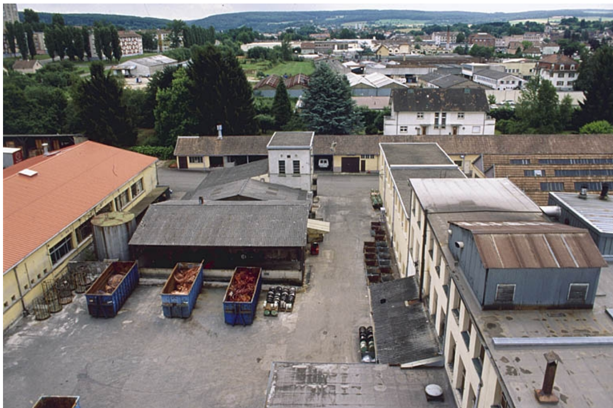
Bâtiments sud : entrepôt industriel, transformateur, ateliers de fabrication et bureau d'études. 90, Delle, 48 faubourg de Belfort
