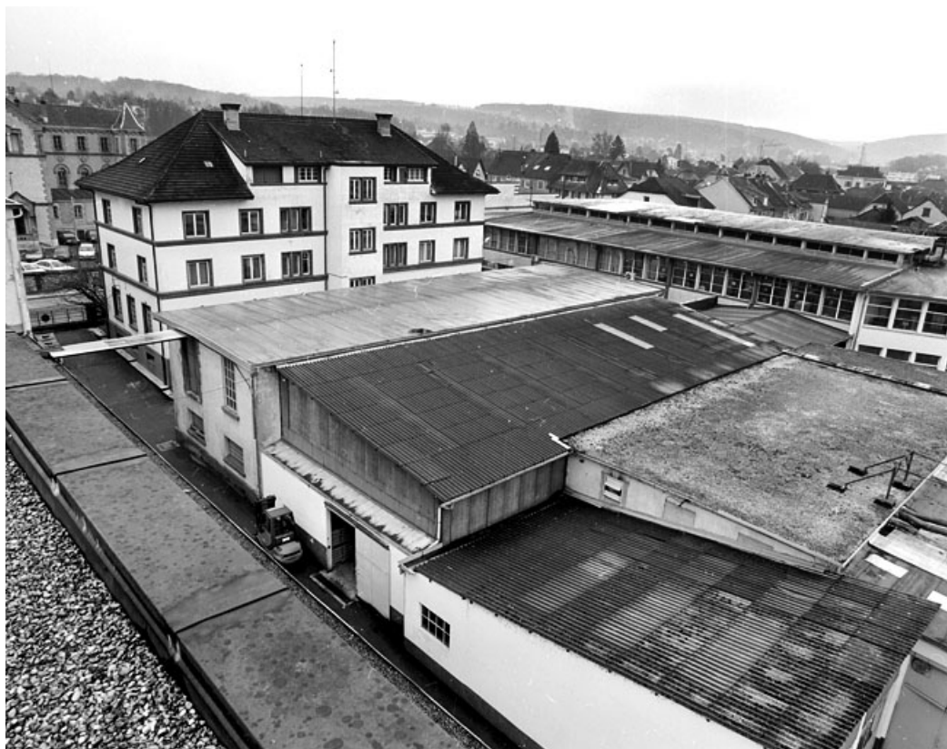
Vue plongeante sur les bureaux, le magasin d'expédition et l'ancienne chaufferie.
