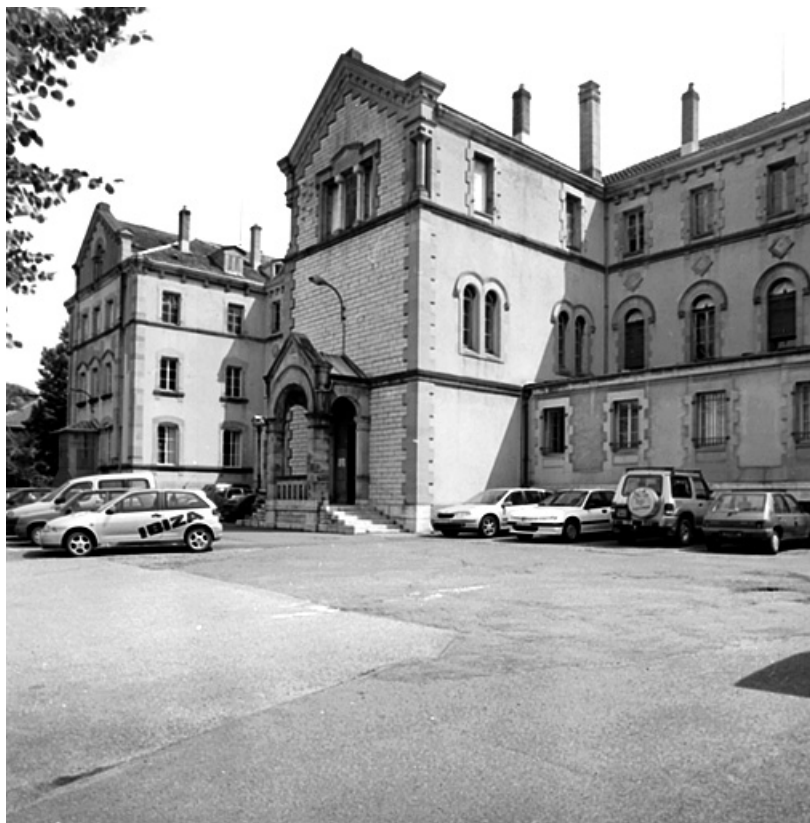
Façade antérieure de l'ancien couvent (actuellement bureaux).
