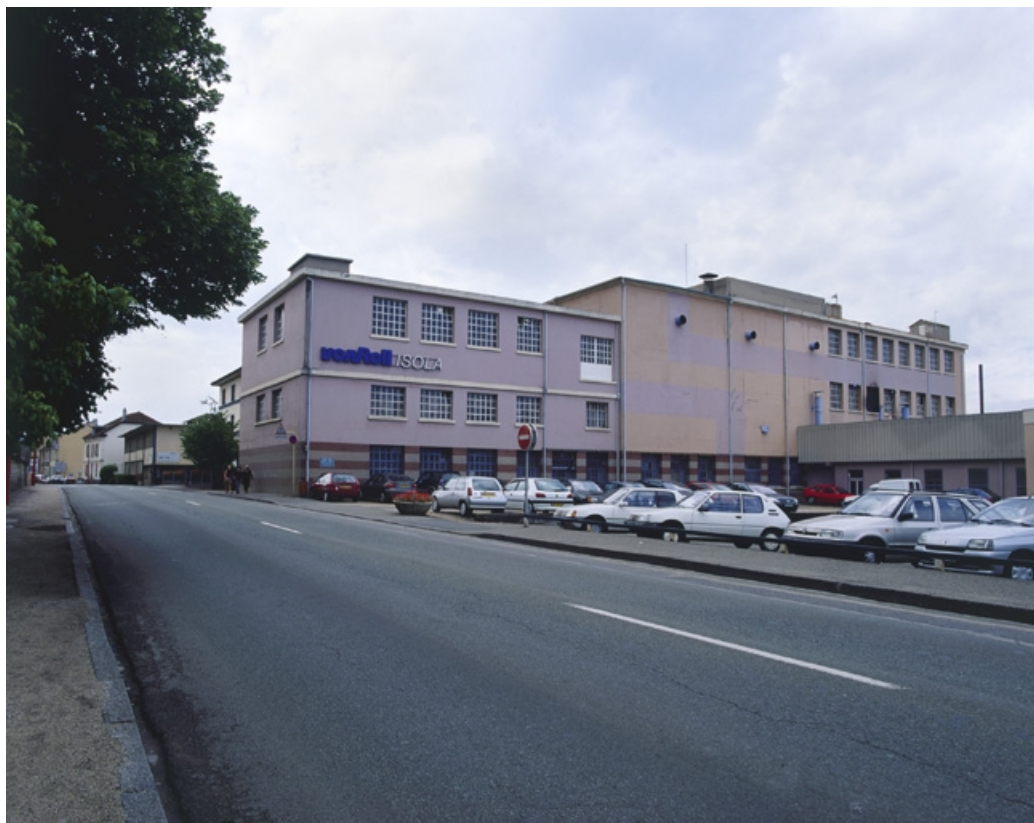
Atelier d'enduction verticale depuis le nord.
