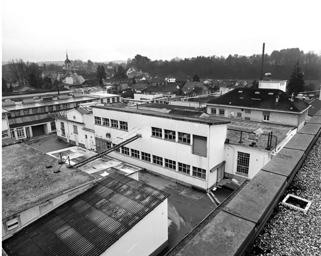
Vue plongeante vers le sud-ouest.
