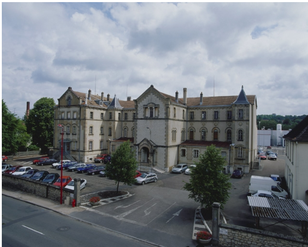
Vue d'ensemble de l'ancien couvent (actuellement bureaux).
