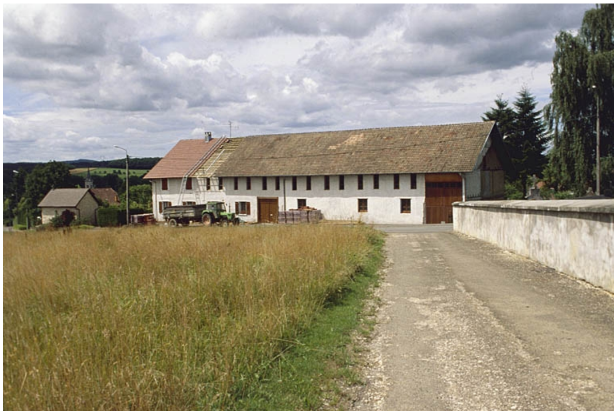
Façade est de l'atelier de fabrication.
