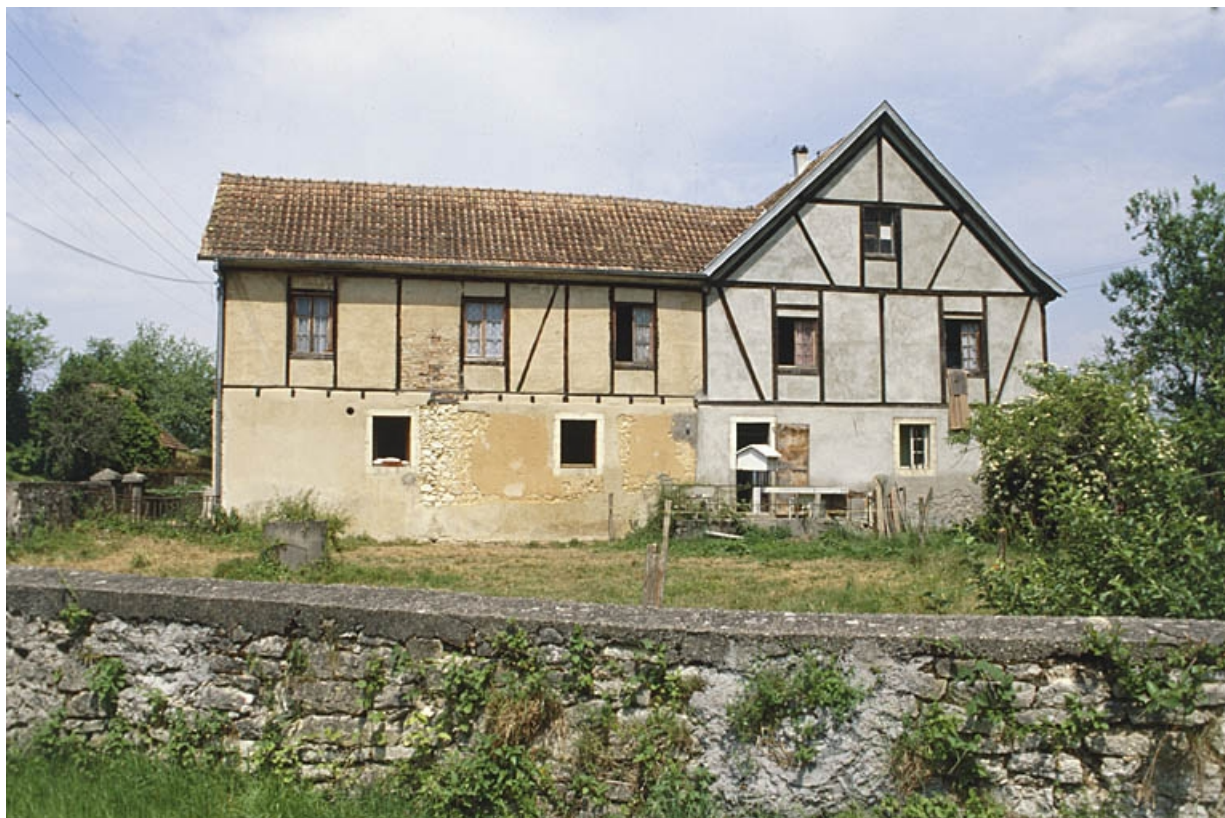
Façade est du logement et pignon de l'atelier de fabrication.
