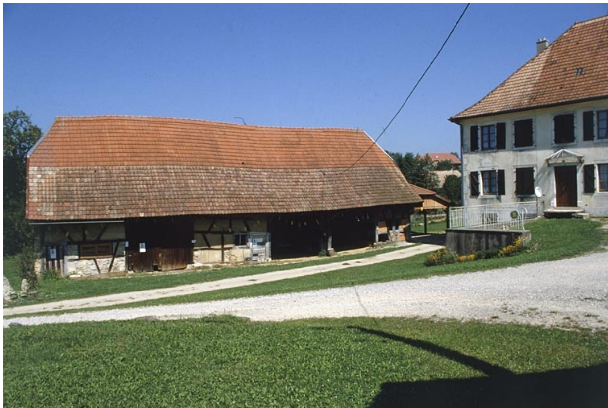
Remise, grange et écurie depuis le sud.
