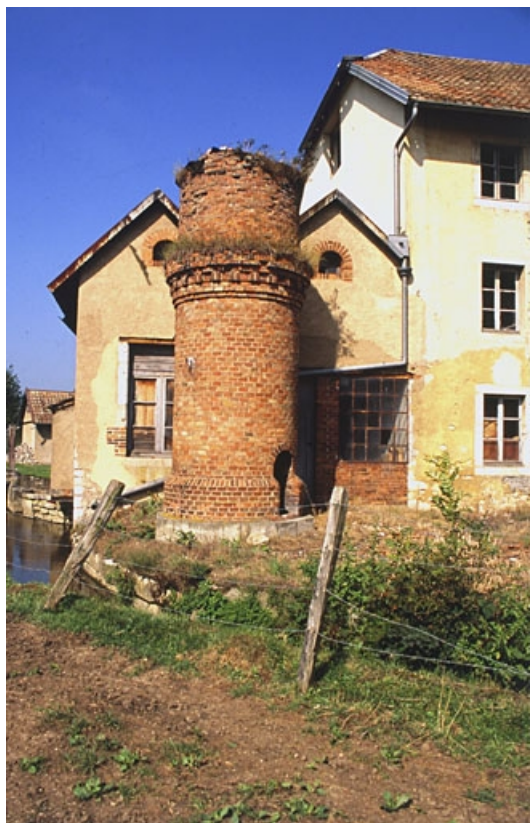
Salle des machines dissimulée par les vestiges de la cheminée.
