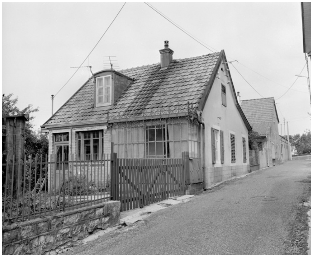
Maison au n° 6, rue des Mélèzes : vue de trois quarts gauche en 1981. SRI. Enquête régionale sur les bâtiments industriels (1979-1981).
