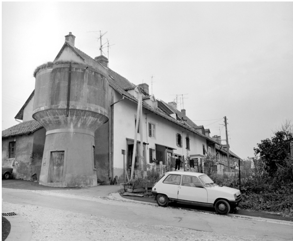
"Caserna" rue des Bouleaux : vue depuis le nord en 1981. SRI. Enquête régionale sur les bâtiments industriels (1979-1981). 90, Beaucourt, lieudit : cité Pierre Japy
