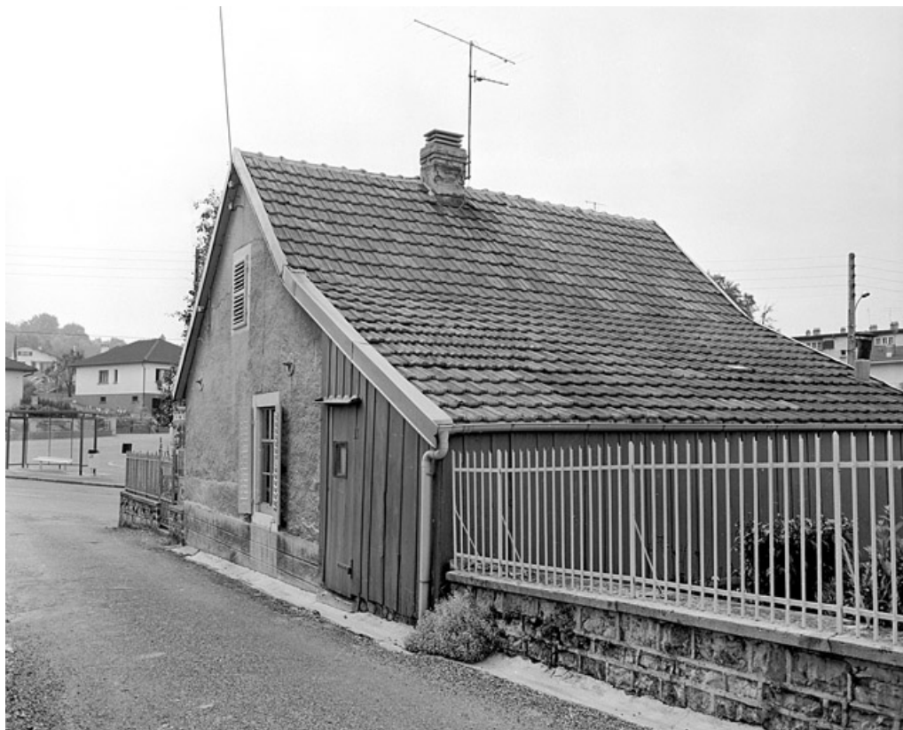
Maison au n° 12, rue des Mélèzes : vue de trois quarts droite en 1981. SRI. Enquête régionale sur les bâtiments industriels (1979-1981).
