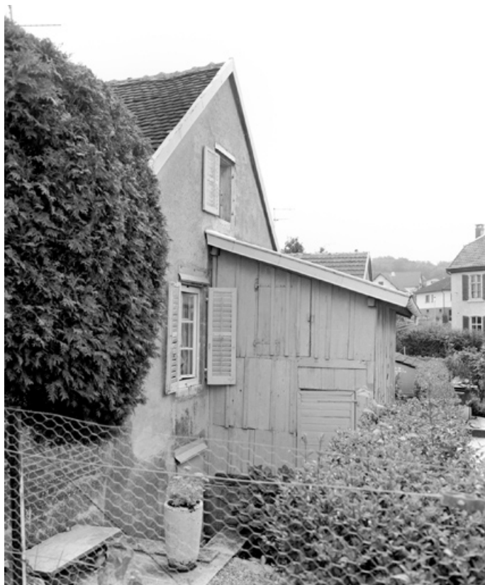
Maison au n° 10, rue des Mélèzes : façade postérieure en 1981. SRI. Enquête régionale sur les bâtiments industriels (1979-1981). 90, Beaucourt, lieudit : cité Pierre Japy
