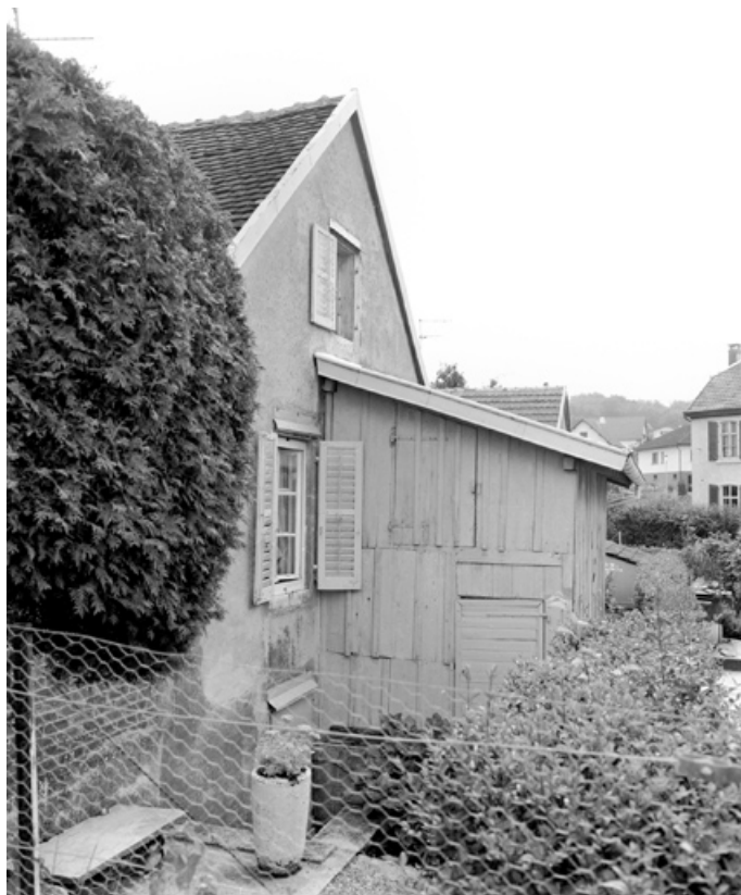
Maison au n° 10, rue des Mélèzes : façade postérieure en 1981. SRI. Enquête régionale sur les bâtiments industriels (1979-1981). 90, Beaucourt, lieudit : cité Pierre Japy
