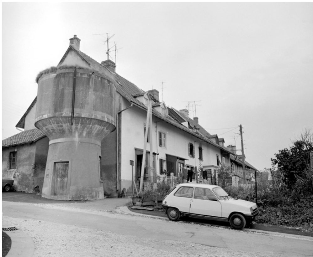
"Casernes" rue des Bouleaux : vue depuis le nord en 1981. SRI. Enquête régionale sur les bâtiments industriels (1979-1981). 90, Beaucourt, lieu-dit : cité Pierre Japy
