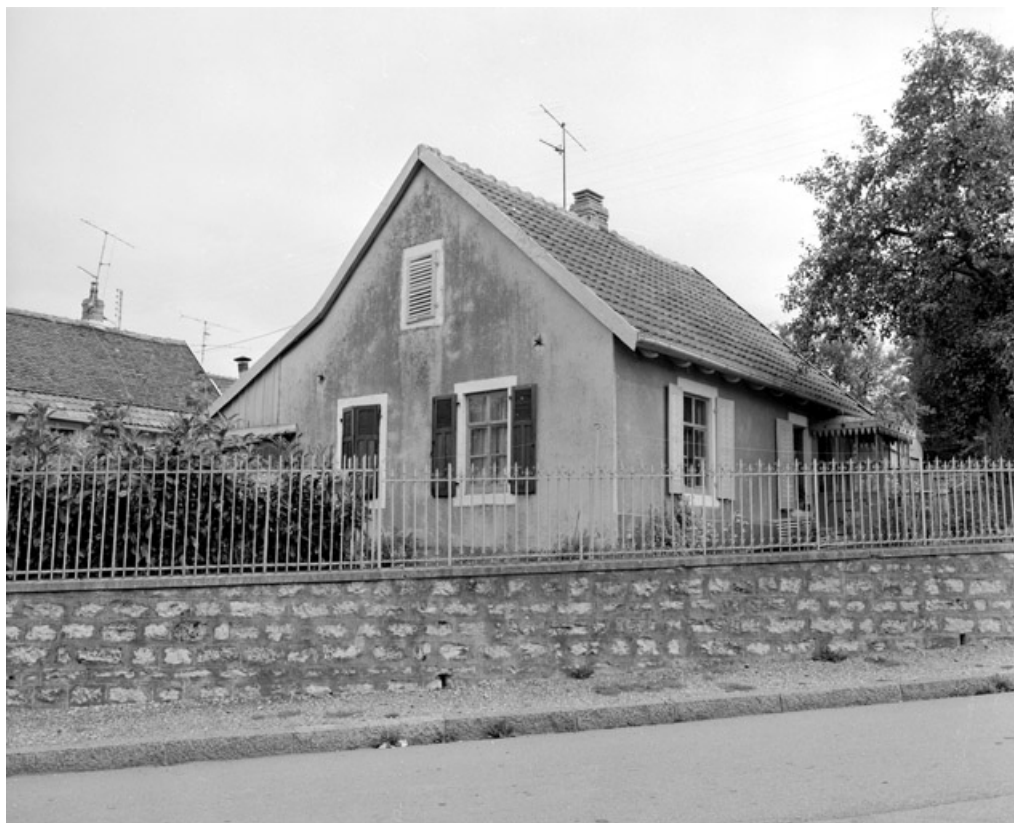
Maison au n° 12, rue des Mélèzes : façade sur jardin en 1981. SRI. Enquête régionale sur les bâtiments industriels (1979-1981). 90, Beaucourt, lieudit : cité Pierre Japy
