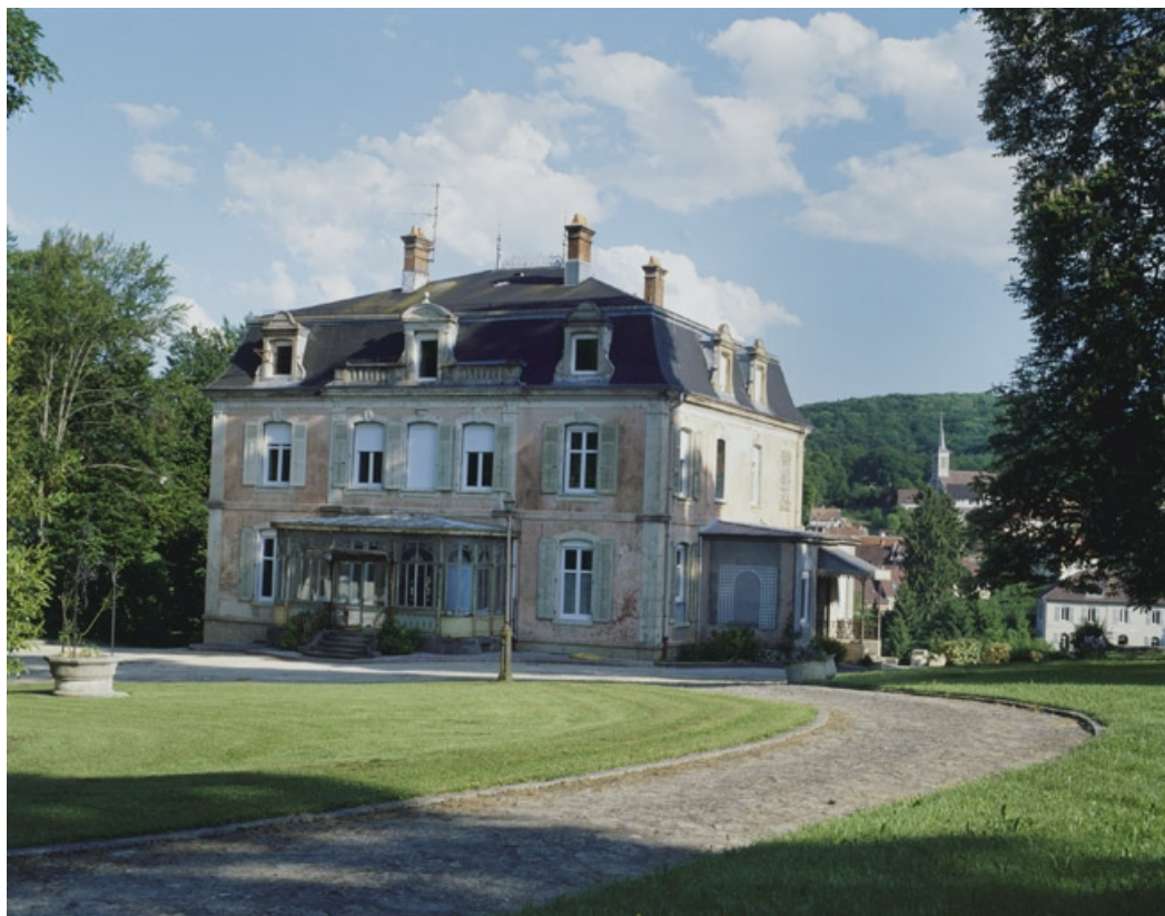
Façade nord vue de trois quarts.
