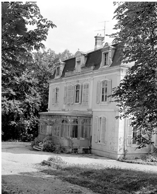
Façade nord vue de trois quarts droite en 1981. SRI. Enquête régionale sur les bâtiments industriels (1979-1981). 90, Beaucourt rue Sous les Vignes
