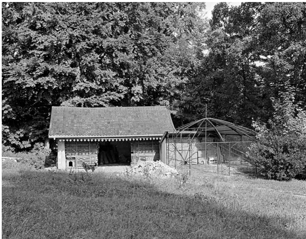
Bûcher et chenil en 1981. SRI. Enquête régionale sur les bâtiments industriels (1979-1981). 90, Beaucourt rue Sous les Vignes
