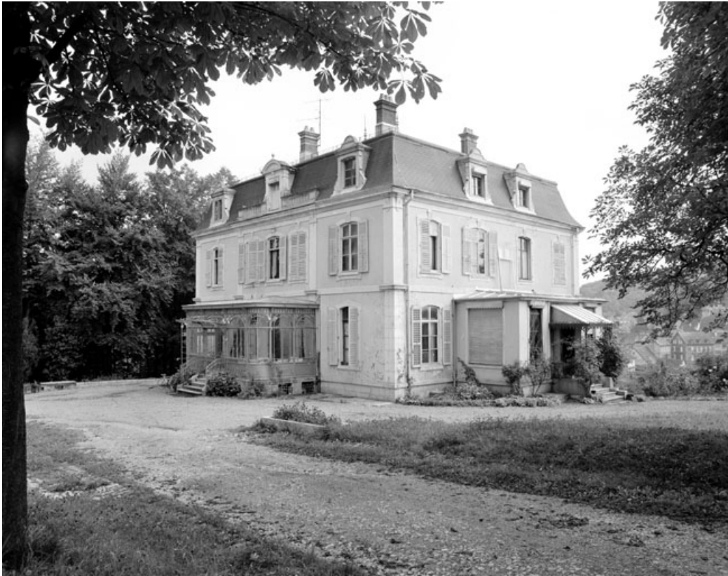
Vue de trois quarts depuis le nord-ouest en 1981. SRI. Enquête régionale sur les bâtiments industriels (1979-1981). 90, Beaucourt rue Sous les Vignes
