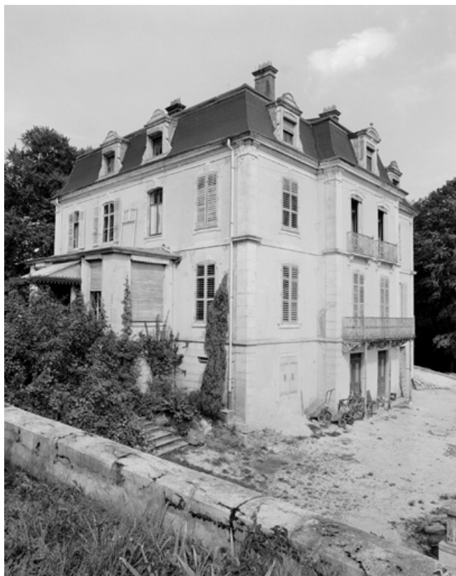
Façades ouest et sud en 1981. SRI. Enquête régionale sur les bâtiments industriels (1979-1981). 90, Beaucourt rue Sous les Vignes
