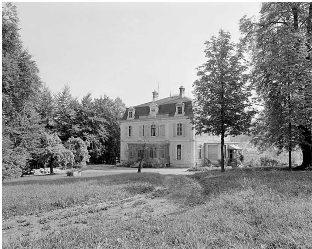
Vue d'ensemble depuis le nord-ouest en 1981. SRI. Enquête régionale sur les bâtiments industriels (1979-1981). 90, Beaucourt rue Sous les Vignes
