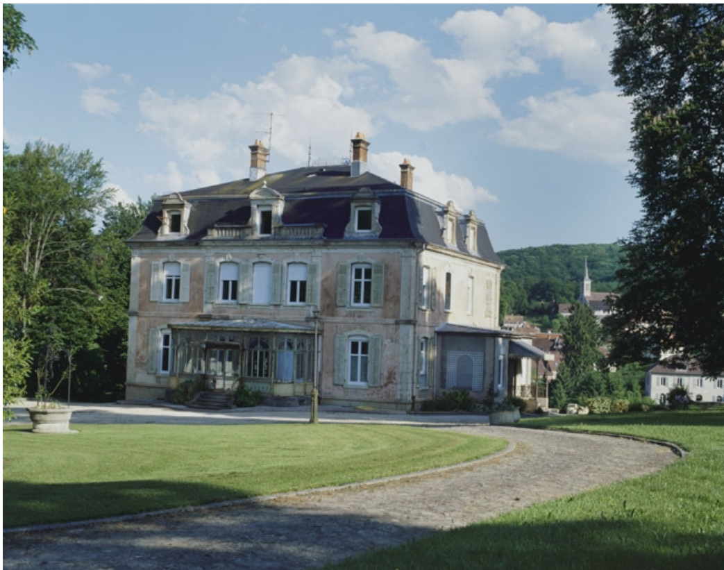
Façade nord vue de trois quarts.
