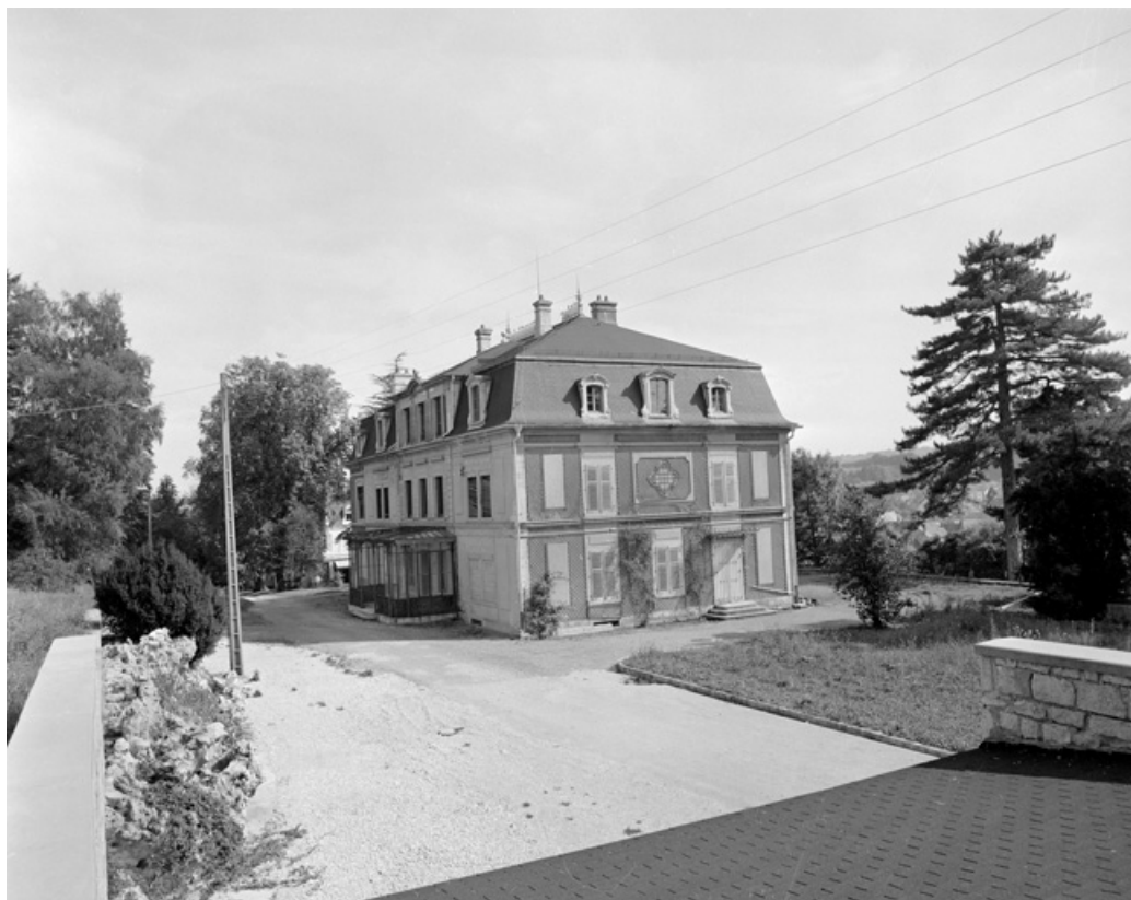
Vue de trois quarts arrière en 1981. SRI. Enquête régionale sur les bâtiments industriels (1979-1981). 90, Beaucourt rue Sous les Vignes
