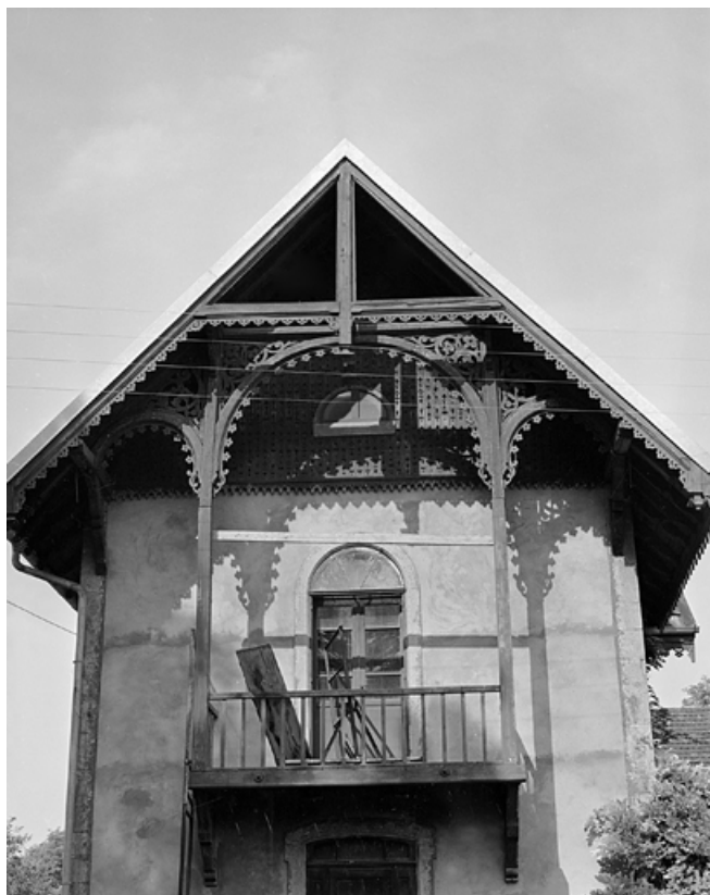
Détail du pignon de la conciergerie en 1981. SRI. Enquête régionale sur les bâtiments industriels (1979-1981). 90, Beaucourt rue Sous les Vignes
