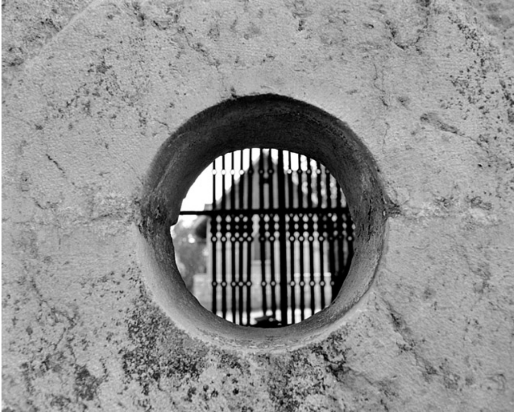
L'orangerie en 1981. Détail d'une baie d'aération. SRI. Enquête régionale sur les bâtiments industriels (1979-1981). 90, Beaucourt rue Sous les Vignes
