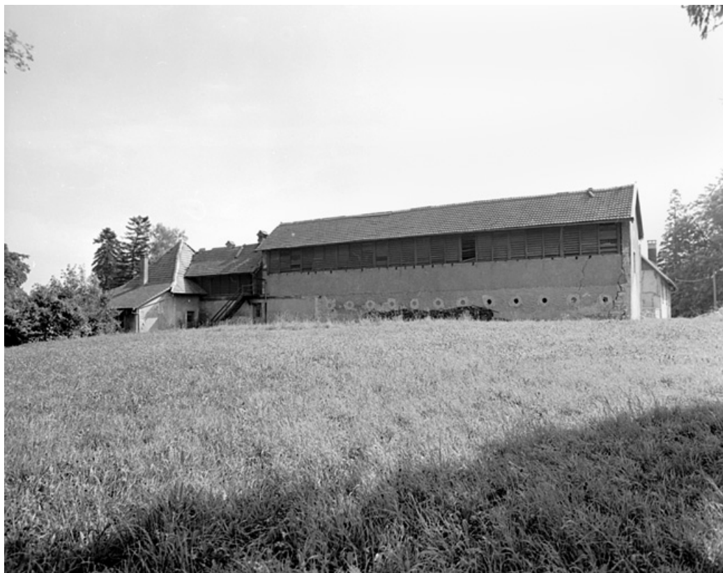
Façade nord de l'orangerie en 1981. SRI. Enquête régionale sur les bâtiments industriels (1979-1981). 90, Beaucourt rue Sous les Vignes
