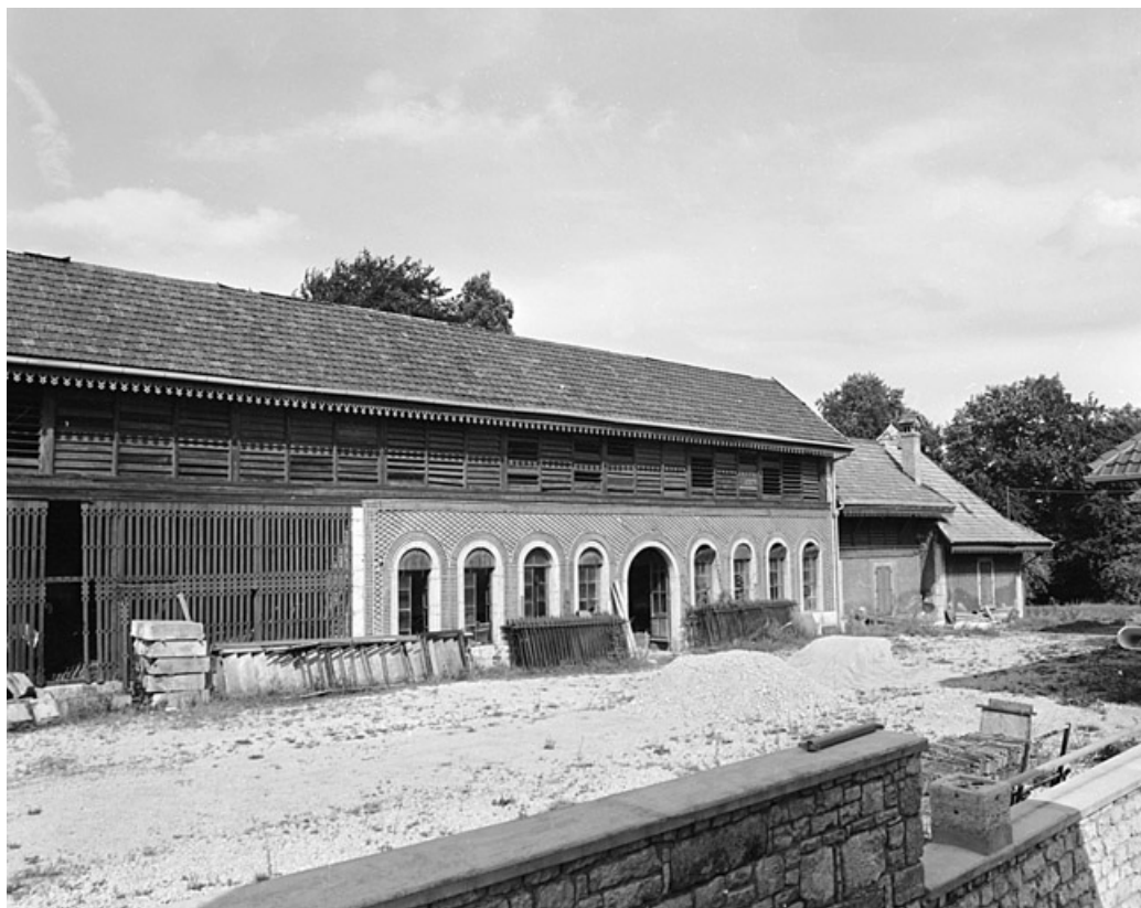
Façade sud de l'orangerie en 1981. SRI. Enquête régionale sur les bâtiments industriels (1979-1981). 90, Beaucourt rue Sous les Vignes
