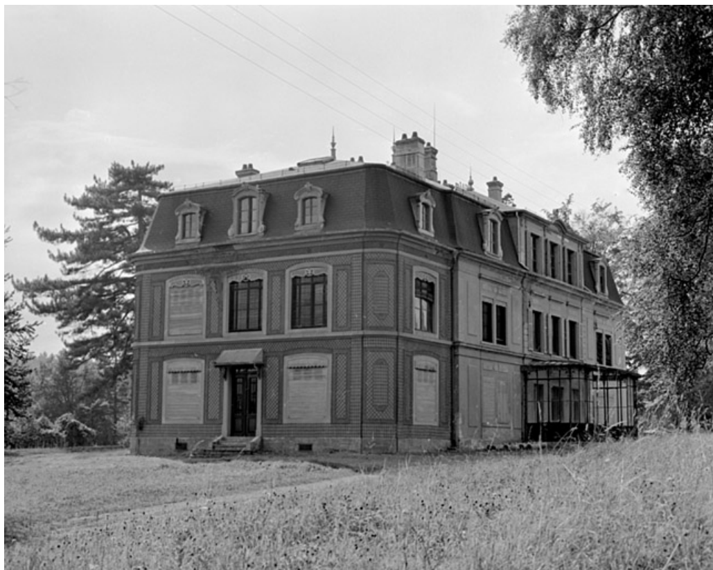
Façades est et nord vues de trois quarts en 1981. SRI. Enquête régionale sur les bâtiments industriels (1979-1981). 90, Beaucourt rue Sous les Vignes
