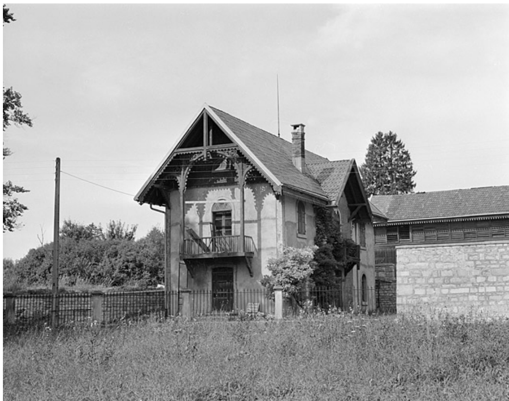
La conciergerie depuis le sud en 1981. SRI. Enquête régionale sur les bâtiments industriels (1979-1981). 90, Beaucourt rue Sous les Vignes
