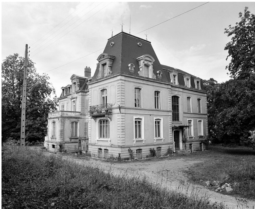
Vue de trois quarts en 1981. SRI. Enquête régionale sur les bâtiments industriels (1979-1981). 90, Beaucourt avenue des Vignes
