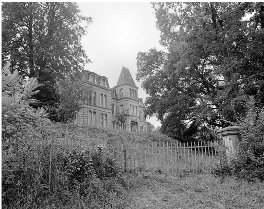
Façade postérieure en 1981. SRI. Enquête régionale sur les bâtiments industriels (1979-1981). 90, Beaucourt avenue des Vignes
