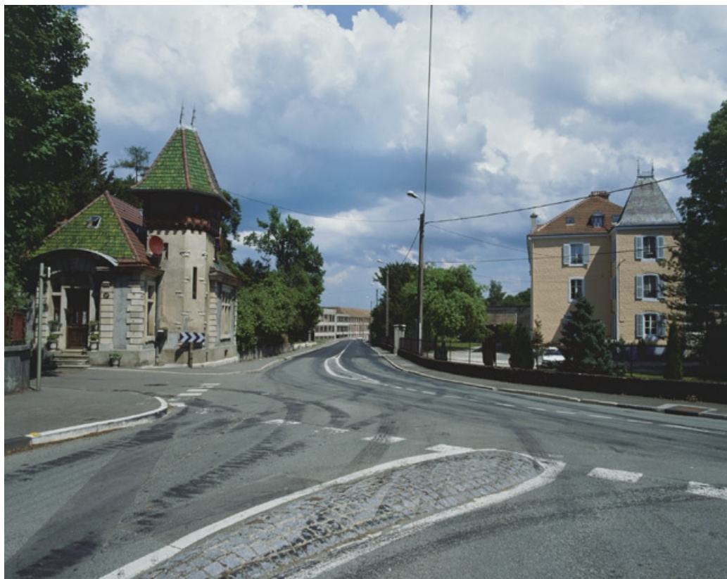
Vue d'ensemble de la conciergerie (à gauche).
