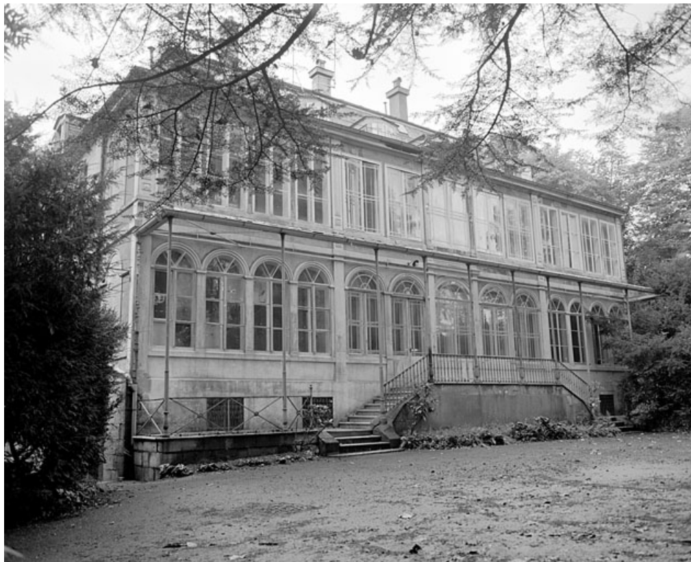
Façade nord en 1981. SRI. Enquête régionale sur les bâtiments industriels (1979-1981). 90, Beaucourt parc des Cèdres
