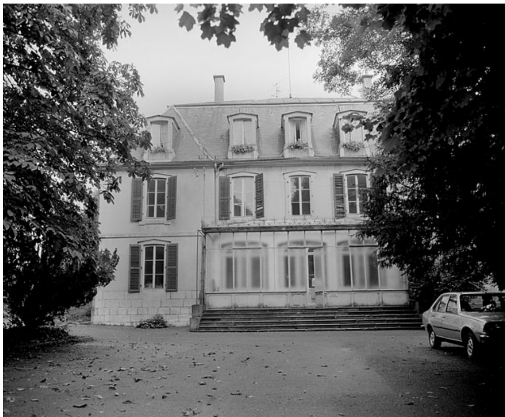
Façade sud en 1981. SRI. Enquête régionale sur les bâtiments industriels (1979-1981). 90, Beaucourt parc des Cèdres
