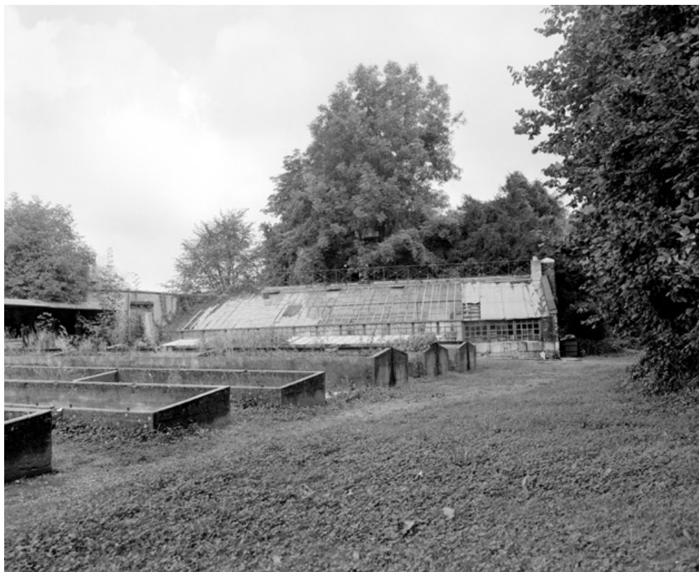
Serres situées dans les jardins du château en 1981. SRI. Enquête régionale sur les bâtiments industriels (1979-1981). 90, Beaucourt parc des Cèdres
