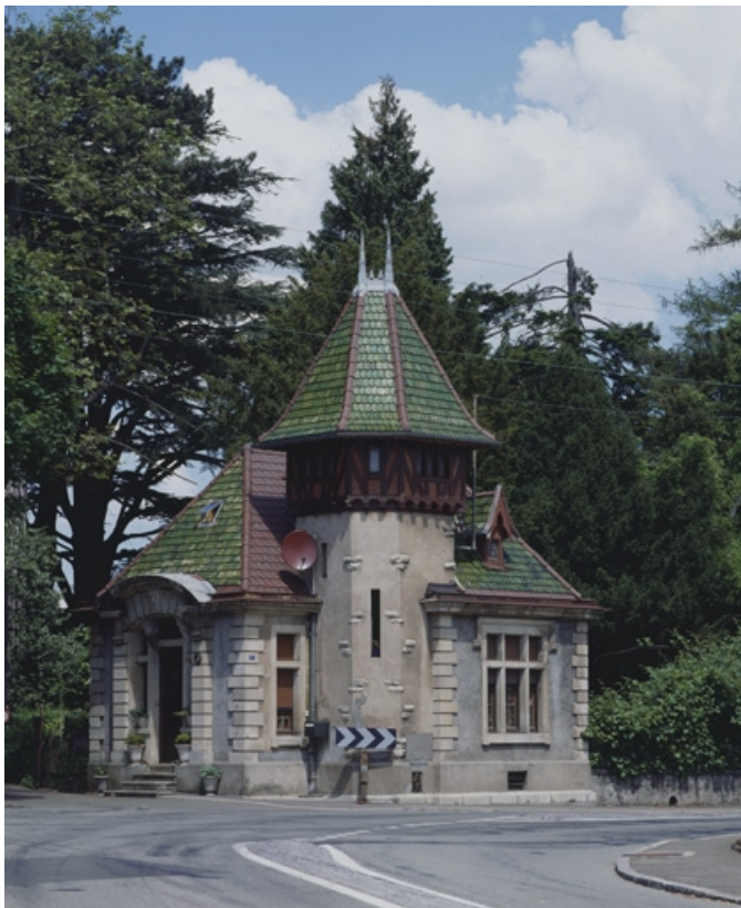
La conciergerie depuis le sud-ouest.
