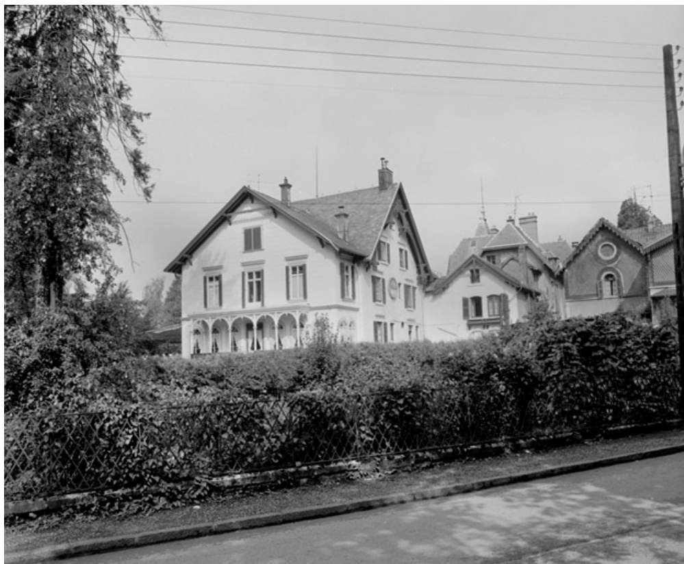
Vue depuis la rue Pierre Sellier en 1981. SRI. Enquête régionale sur les bâtiments industriels (1979-1981). 90, Beaucourt, 1, 3 rue du Mont de Dasle
