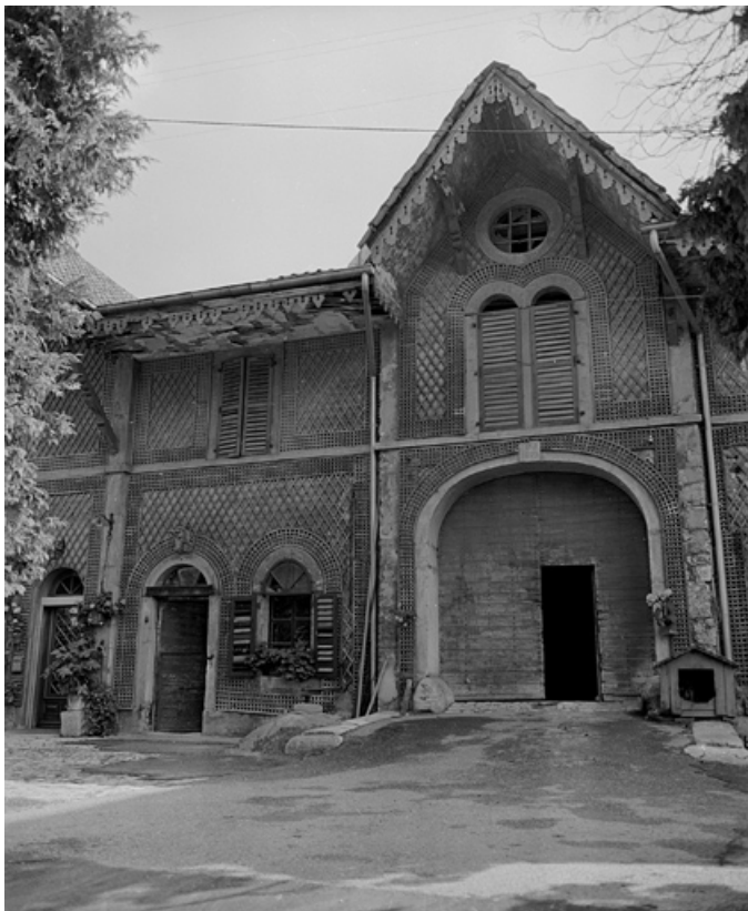
Façade antérieure de la ferme : entrée de grange et d'écurie en 1981. SRI. Enquête régionale sur les bâtiments industriels (1979-1981).
