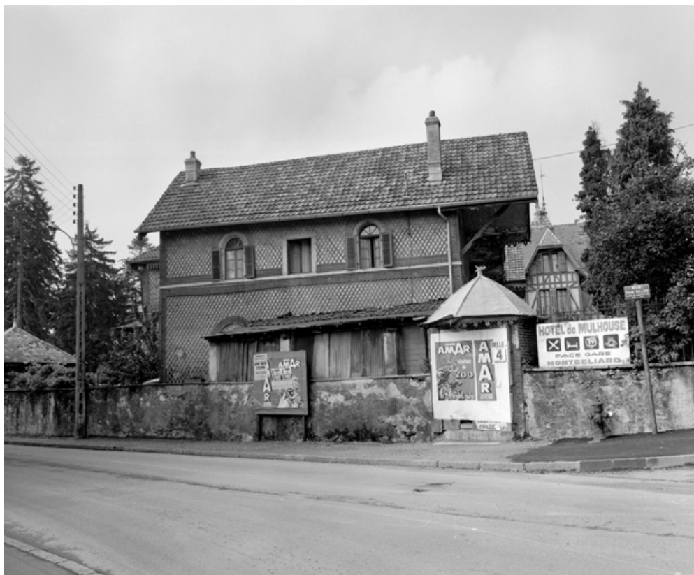
Façade est de la ferme en 1981. SRI. Enquête régionale sur les bâtiments industriels (1979-1981). 90, Beaucourt, 1, 3 rue du Mont de Dasle
