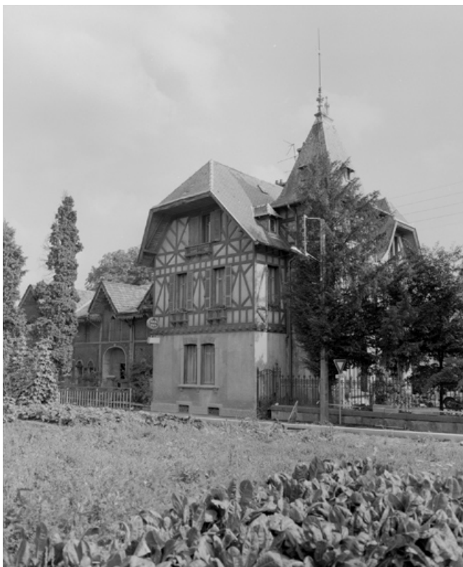
Vue de trois quarts de l'adjonction de la fin du 19e siècle (en 1981). SRI. Enquête régionale sur les bâtiments industriels (1979-1981).
