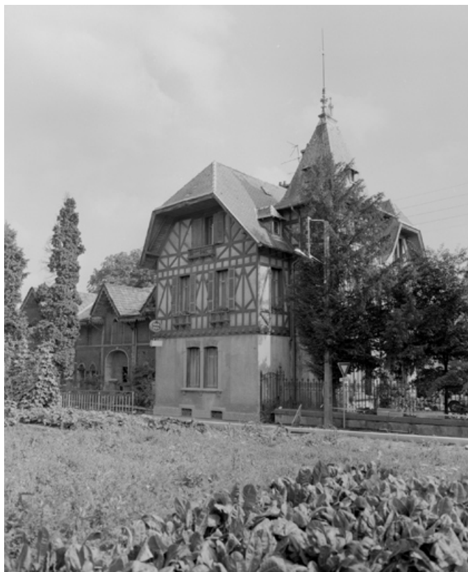
Vue de trois quarts de l'adjonction de la fin du 19e siècle (en 1981). SRI. Enquête régionale sur les bâtiments industriels (1979-1981).
