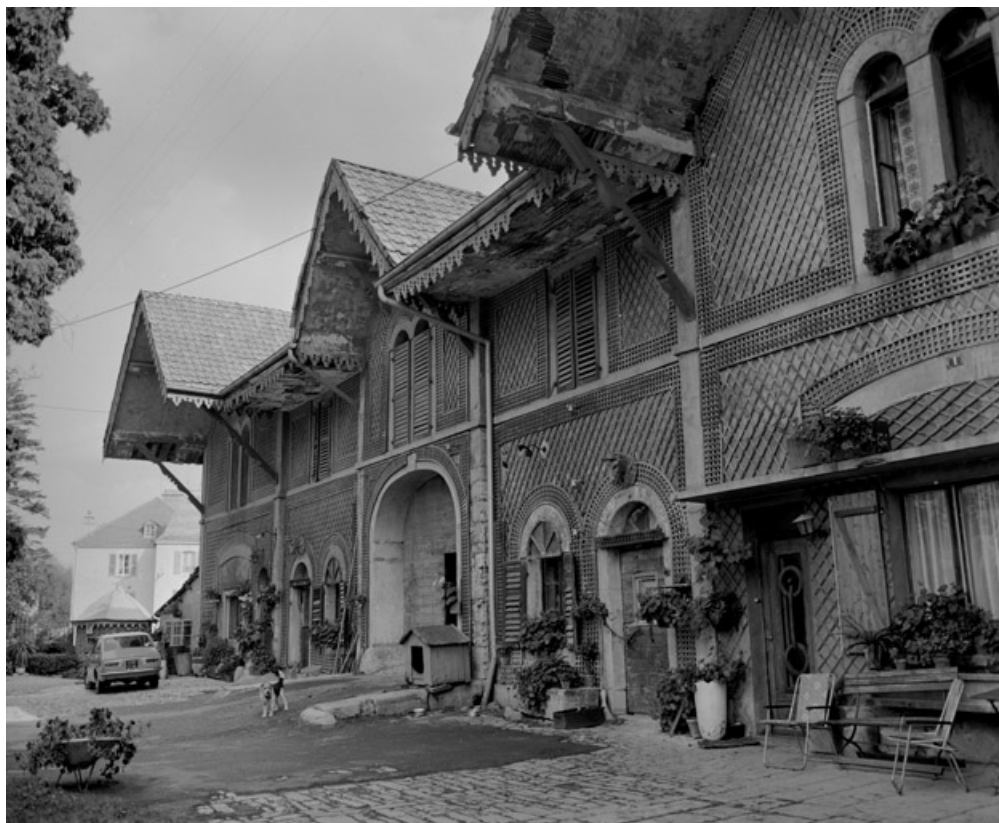
Vue de trois quarts de la façade de la ferme en 1981. SRI. Enquête régionale sur les bâtiments industriels (1979-1981). 90, Beaucourt, 1, 3 rue du Mont de Dasle
