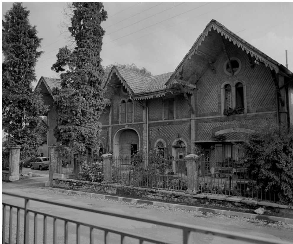
Façade sur rue de la ferme en 1981. SRI. Enquête régionale sur les bâtiments industriels (1979-1981). 90, Beaucourt, 1, 3 rue du Mont de Dasle
