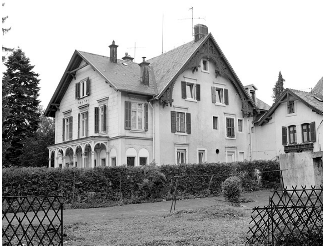
Façade orientale du logement principal.
