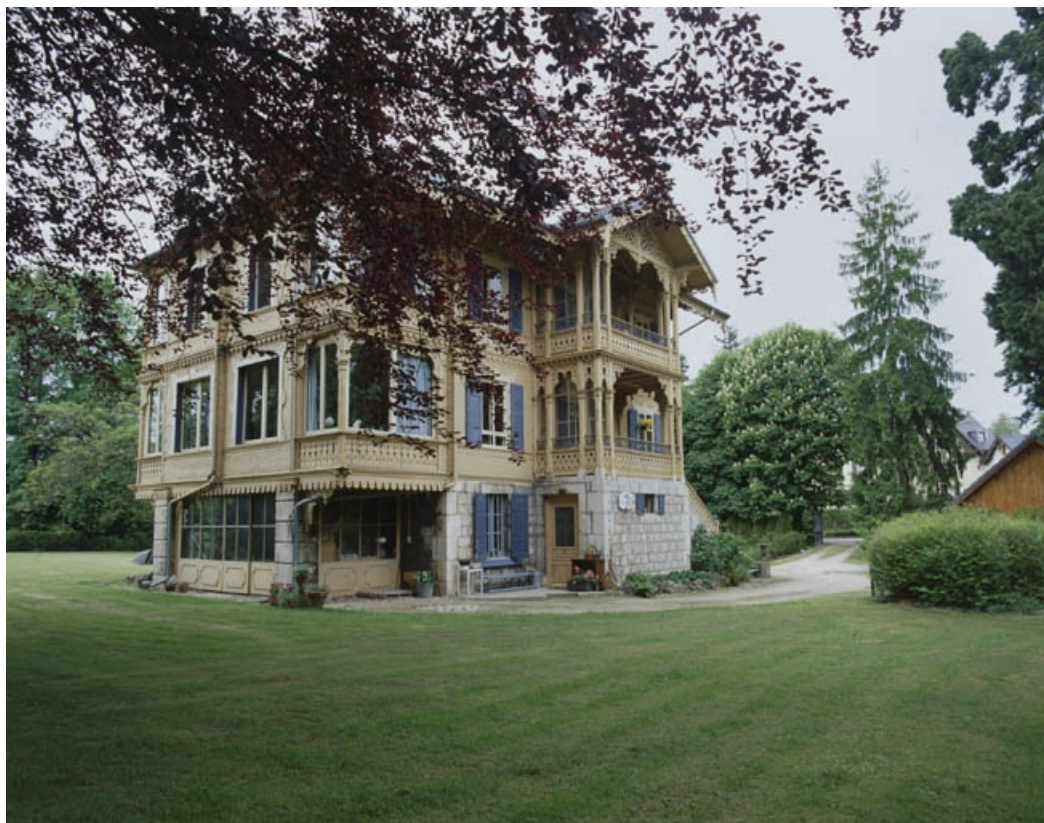
Chalet. Vue d'ensemble depuis le nord-est.
