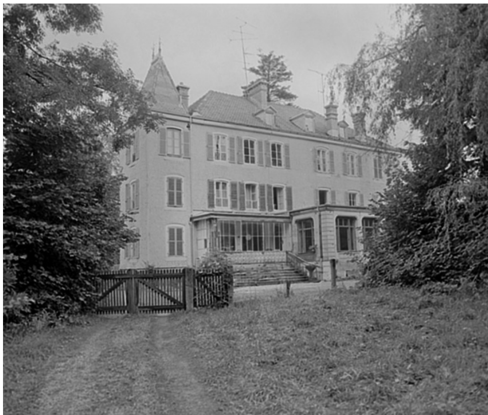
Façade sud en 1981. SRI. Enquête régionale sur les bâtiments industriels (1979-1981). 90, Beaucourt, 1 rue Pierre Sellier
