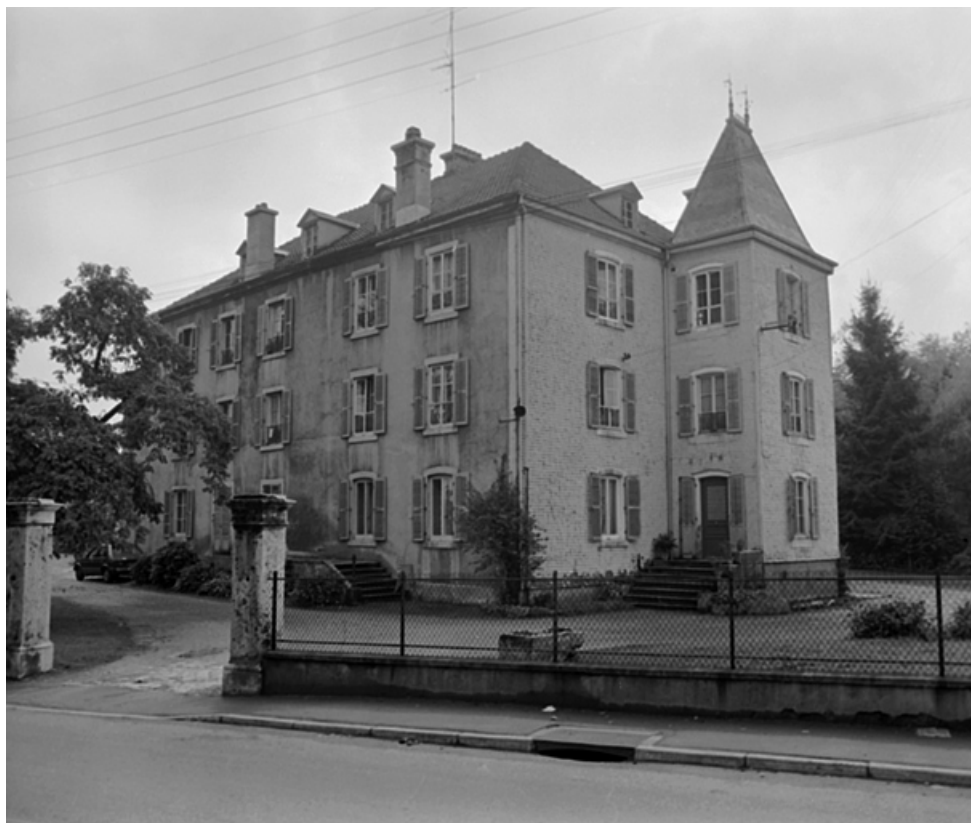
Vue de trois quarts droite en 1981. SRI. Enquête régionale sur les bâtiments industriels (1979-1981). 90, Beaucourt, 1 rue Pierre Sellier
