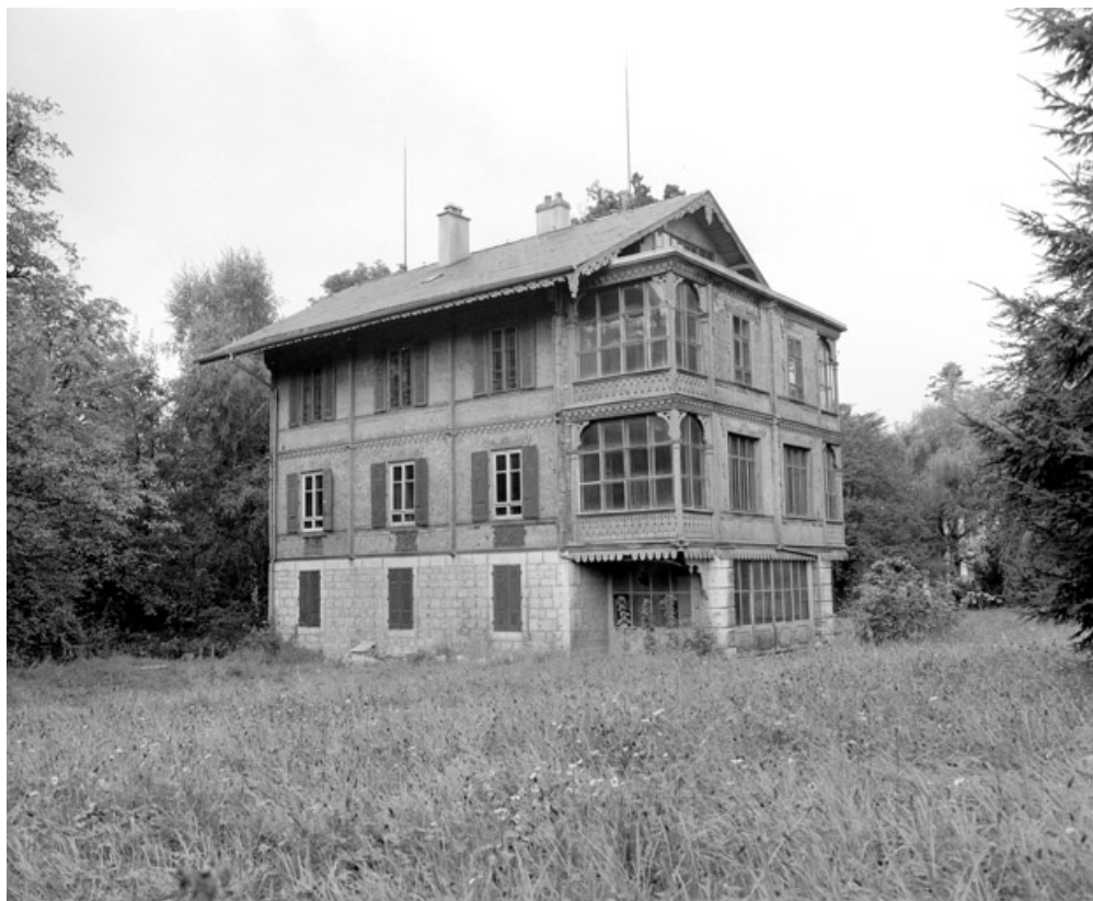
Chalet. Vue de trois quarts en 1981. SRI. Enquête régionale sur les bâtiments industriels (1979-1981). 90, Beaucourt, 1 rue Pierre Sellier
