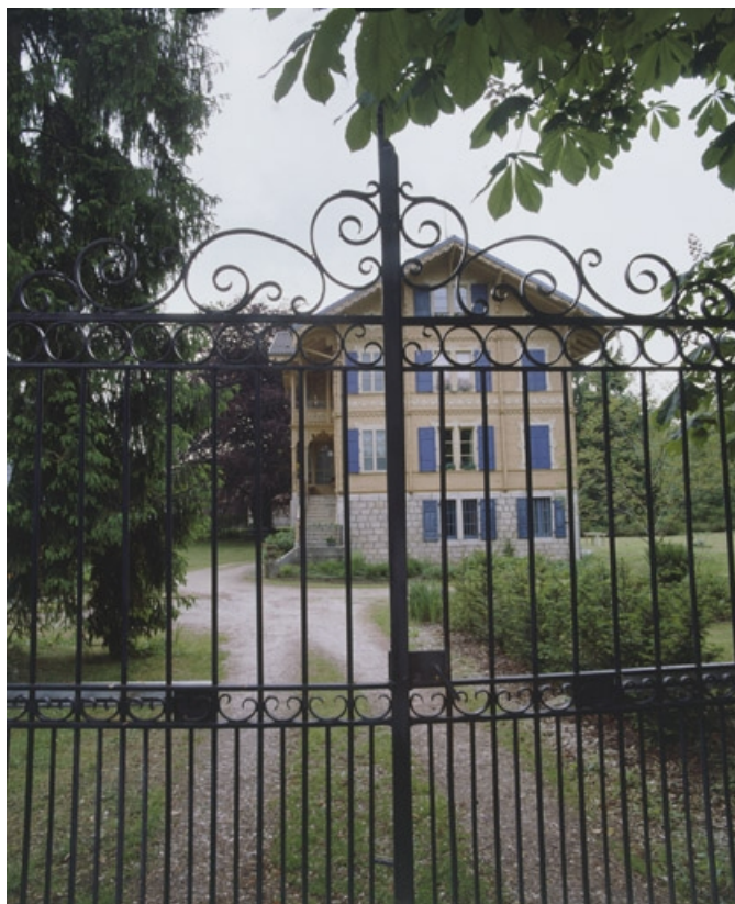
Chalet. Vue depuis la grille d'entrée.
