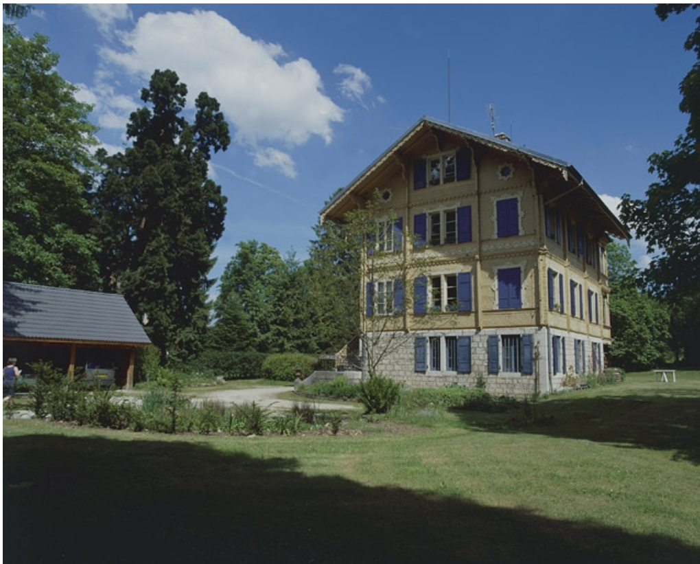
Chalet. Vue d'ensemble depuis le sud-ouest.
