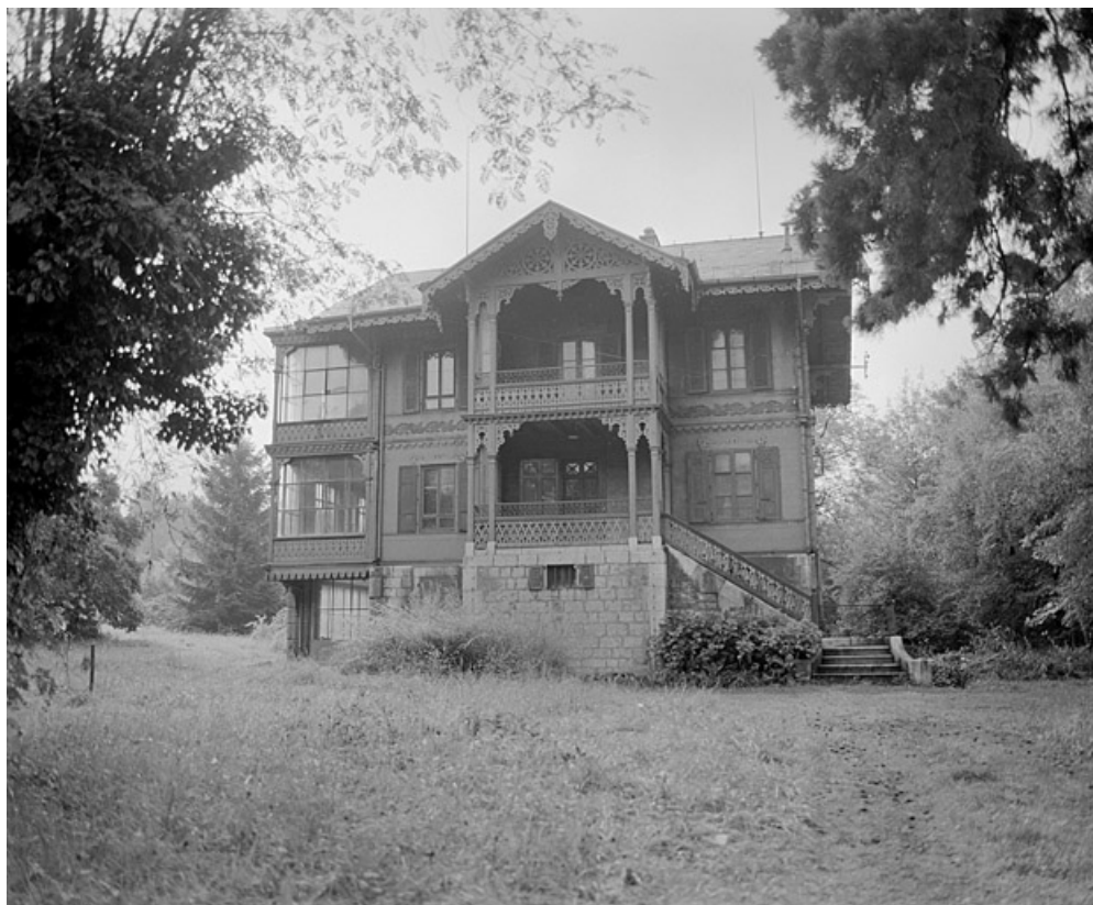
Chalet. Façade nord en 1981. SRI. Enquête régionale sur les bâtiments industriels (1979-1981). 90, Beaucourt, 1 rue Pierre Sellier
