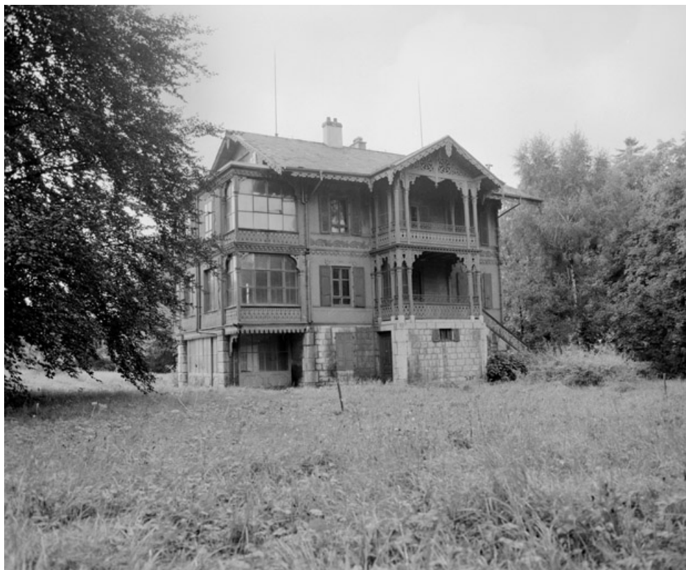
Chalet. Façade nord vue de trois quarts en 1981. SRI. Enquête régionale sur les bâtiments industriels (1979-1981). 90, Beaucourt, 1 rue Pierre Sellier
