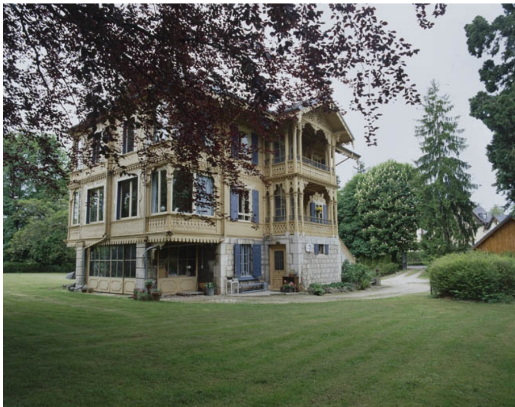
Chalet. Vue d'ensemble depuis le nord-est.
