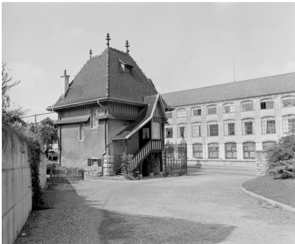
Conciergerie. Vue depuis le sud-est en 1981. SRI. Enquête régionale sur les bâtiments industriels (1979-1981). 90, Beaucourt, 7 rue Frédéric Japy
