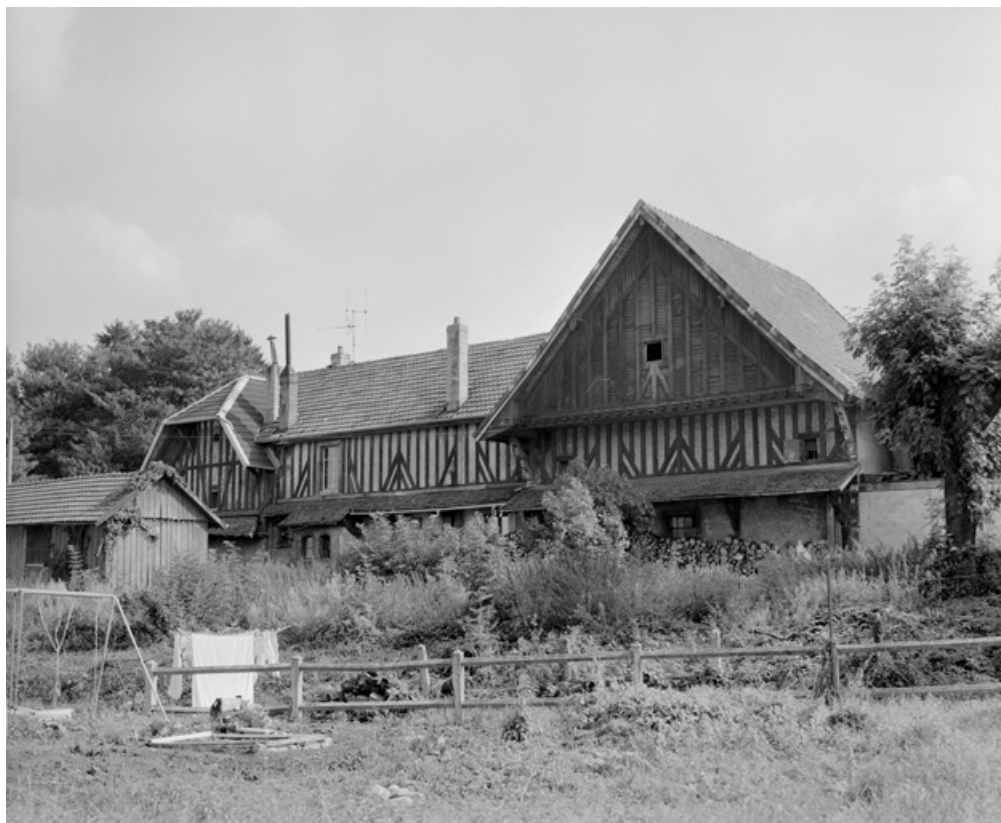
Dépendances : ferme des Grandes Planches. Façade antérieure en 1981. SRI. Enquête régionale sur les bâtiments industriels (1979-1981).
