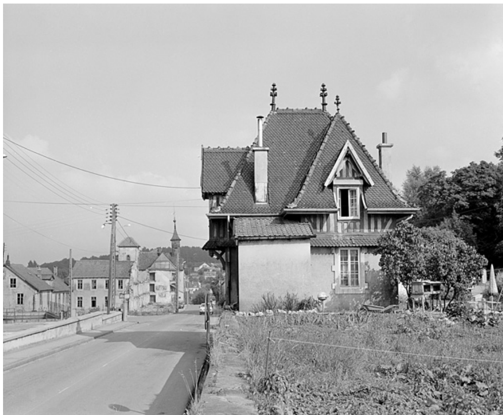
Conciergerie. Façade ouest en 1981. SRI. Enquête régionale sur les bâtiments industriels (1979-1981). 90, Beaucourt, 7 rue Frédéric Japy
