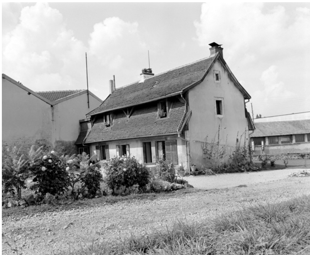
Logement du jardinier. Façade postérieure en 1981. SRI. Enquête régionale sur les bâtiments industriels (1979-1981). 90, Beaucourt, 7 rue Frédéric Japy
