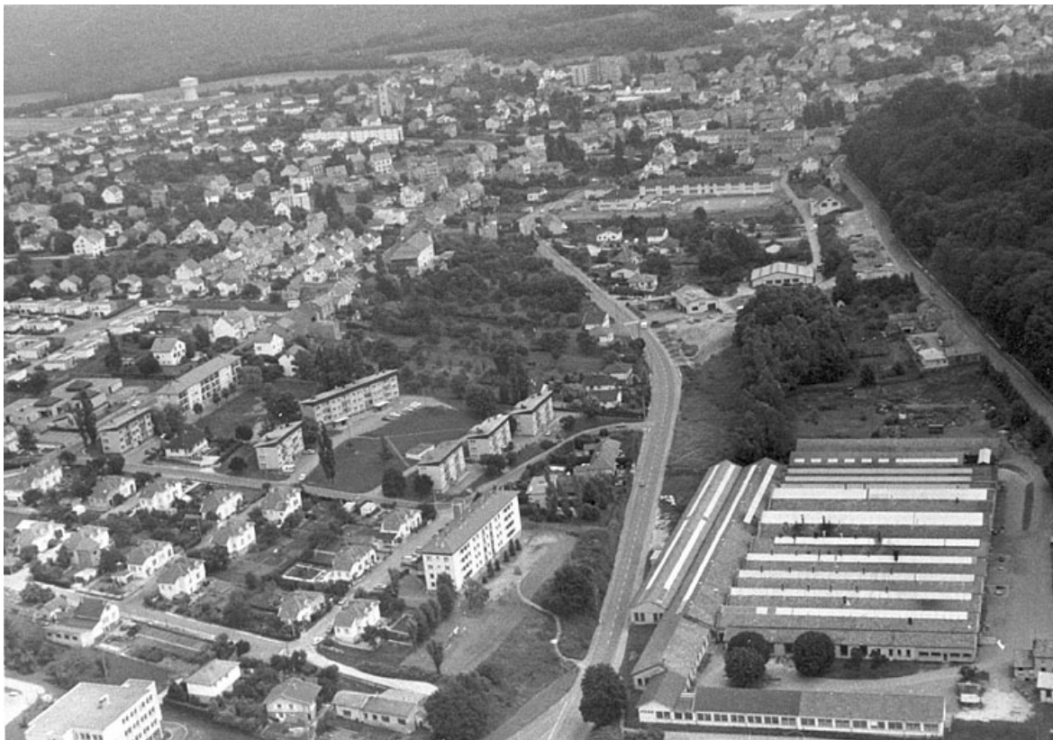
Vue aérienne depuis le nord-ouest en 1982.
