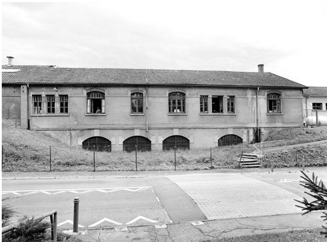
Façade postérieure des ateliers de fabrication.
