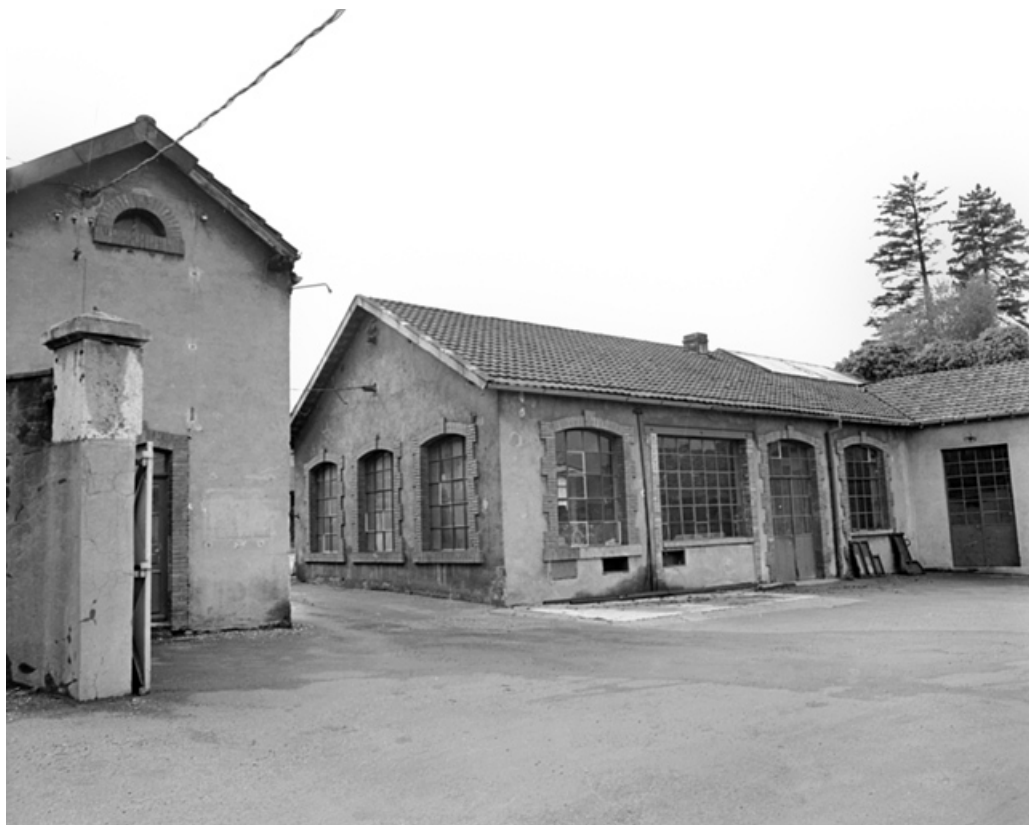
Les magasins généraux depuis l'entrée en 1981. SRI. Enquête régionale sur les bâtiments industriels (1979-1981). 90, Beaucourt rue de Vandoncourt
