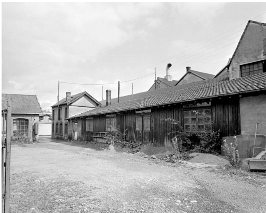
La cour de la fonderie en 1981. SRI. Enquête régionale sur les bâtiments industriels (1979-1981). 90, Beaucourt rue de Vandoncourt
