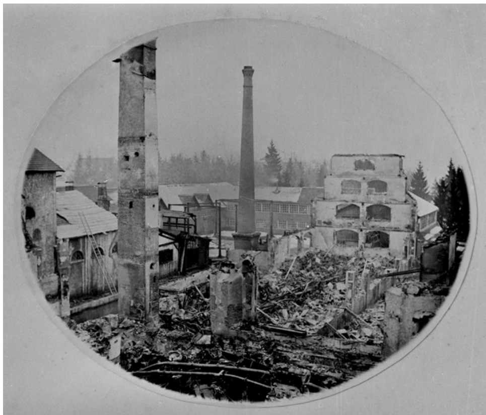
L'usine des Fonteneilles après l'incendie du 23 janvier 1881.
