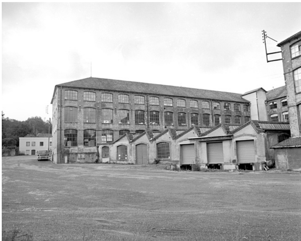
Élévation sur la cour dite du Fer à cheval en 1981. SRI. Enquête régionale sur les bâtiments industriels (1979-1981). 90, Beaucourt rue Frédéric Japy
