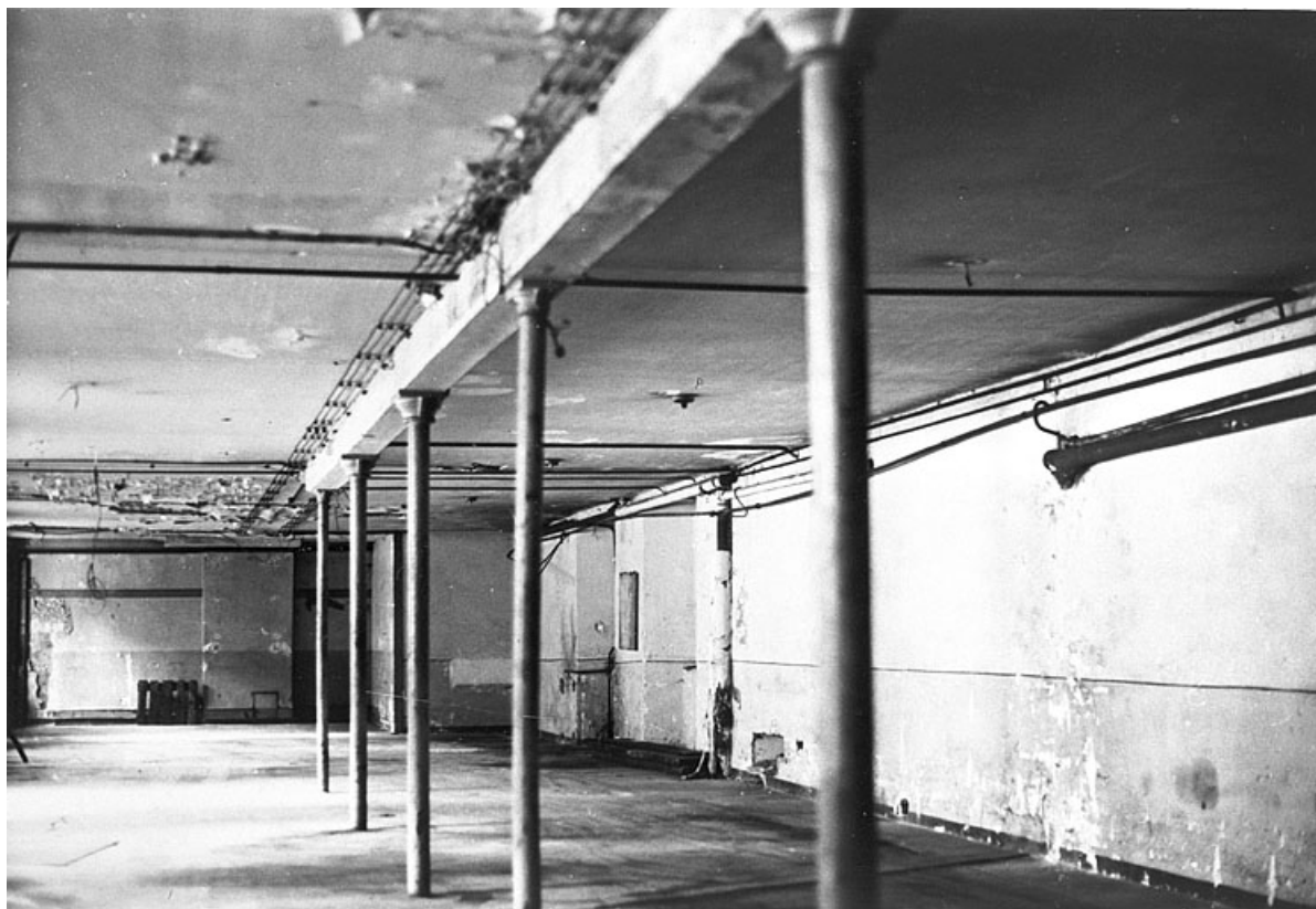
L'atelier au rez-de-chaussée (état en 1978).
