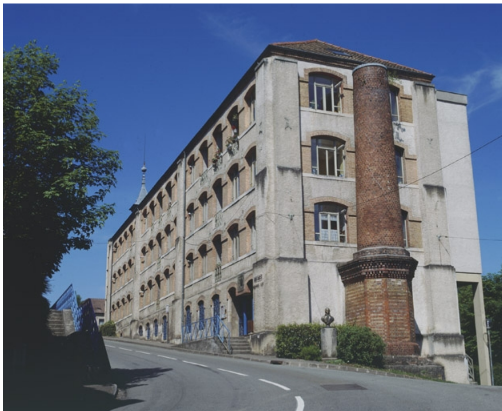
Vue de trois quarts droite de la façade antérieure.
