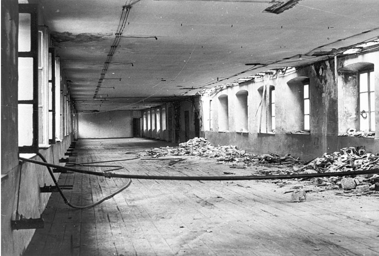
Atelier au second étage (état en 1978).
