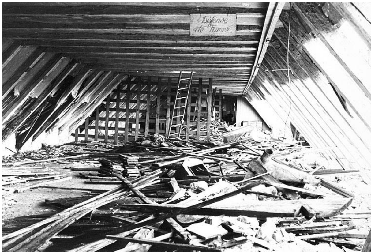
L'étage de comble (état en 1978).
