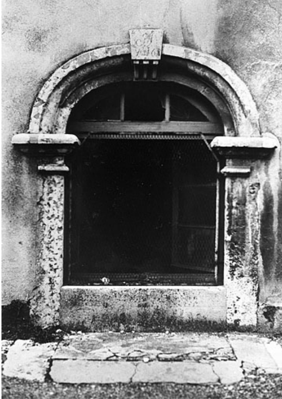
Baie sur la façade sud (état en 1978).
