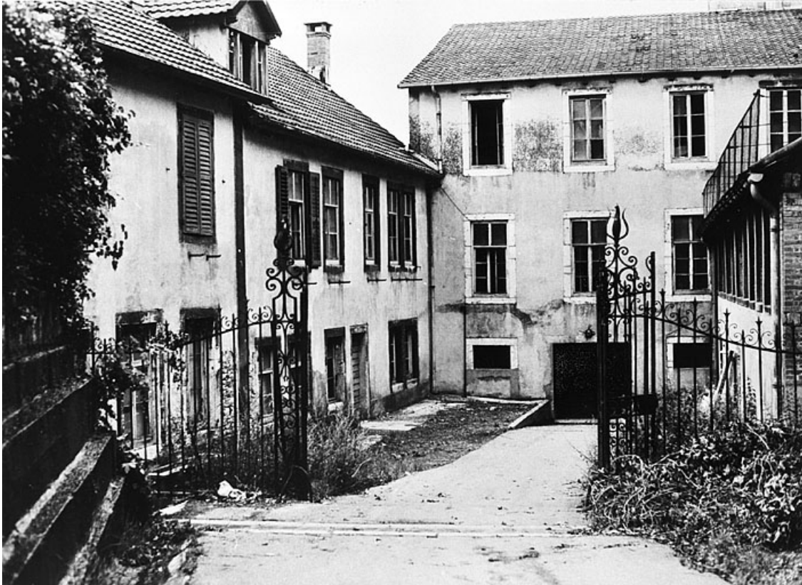
Bâtiments ouest : bureaux et logements à gauche, atelier de fabrication au fond (état en 1978).
