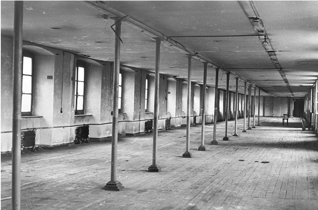
Atelier au premier étage (état en 1978). 90, Beaucourt, 16 à 30 rue Frédéric Japy
