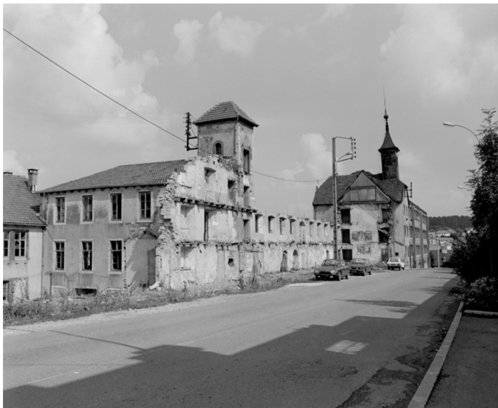
Vue d'ensemble de la Pendulerie en 1981. SRI. Enquête régionale sur les bâtiments industriels (1979-1981). 90, Beaucourt, 16 à 30 rue Frédéric Japy
