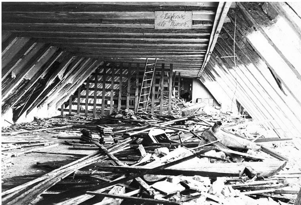
L'étage de comble (état en 1978).
