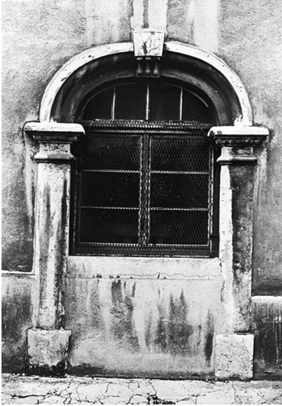
Seconde baie sur la façade sud (état en 1978).
