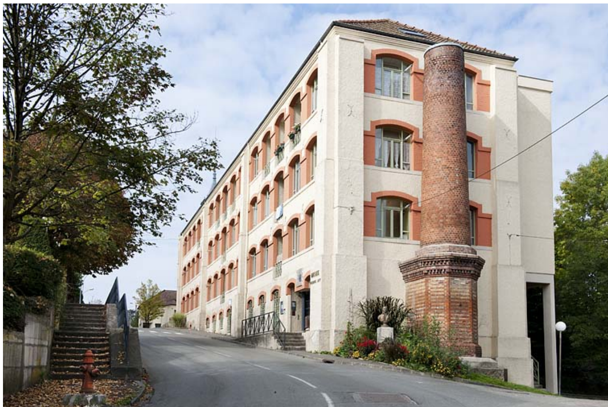
Vue de trois quarts droite de la façade antérieure.
