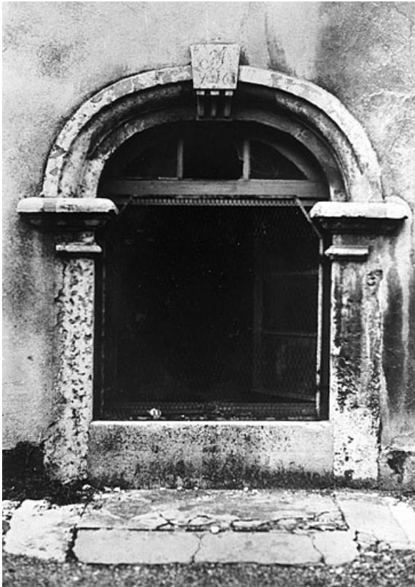
Baie sur la façade sud (état en 1978).
