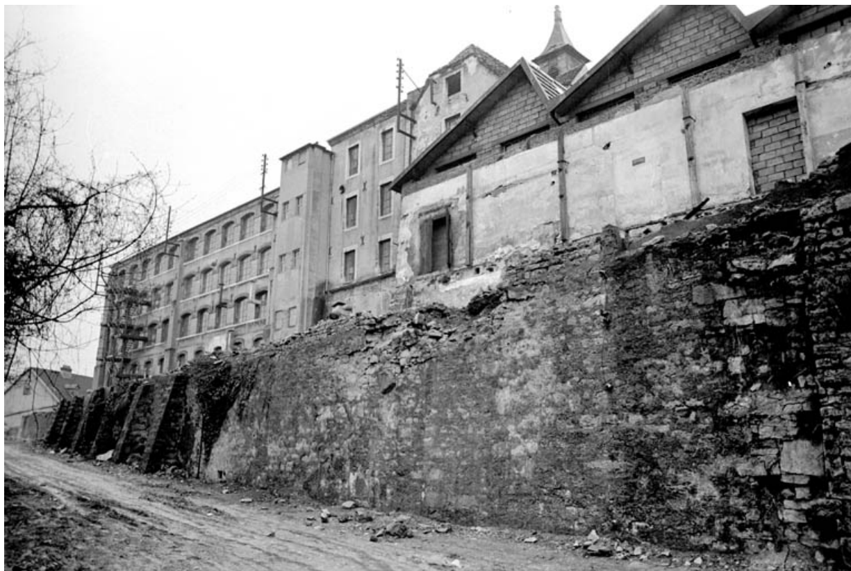
Façade postérieure de l'extension des années 1892 (état en 1981). SRI. Enquête régionale sur les bâtiments industriels (1979-1981). 90, Beaucourt, 16 à 30 rue Frédéric Japy
