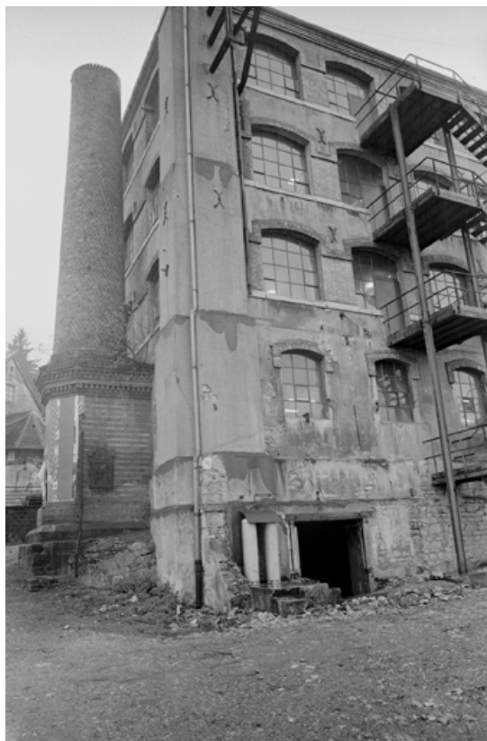
Extrémité de l'extension des années 1892 : détail de la cheminée sur la façade est (état en 1981). SRI. Enquête régionale sur les bâtiments industriels (1979-1981).
