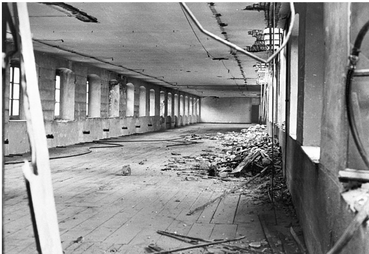
Atelier au second étage (état en 1978).
