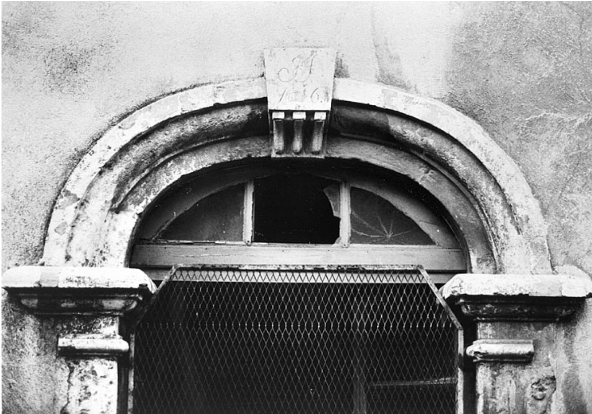
Détail d'une baie sur la façade sud (état en 1978). La clé d'arcade porte la date 1816 et les initiales F.J. (?), vestige de la reconstruction après l'incendie de 1815.
