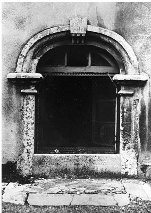
Baie sur la façade sud (état en 1978).
