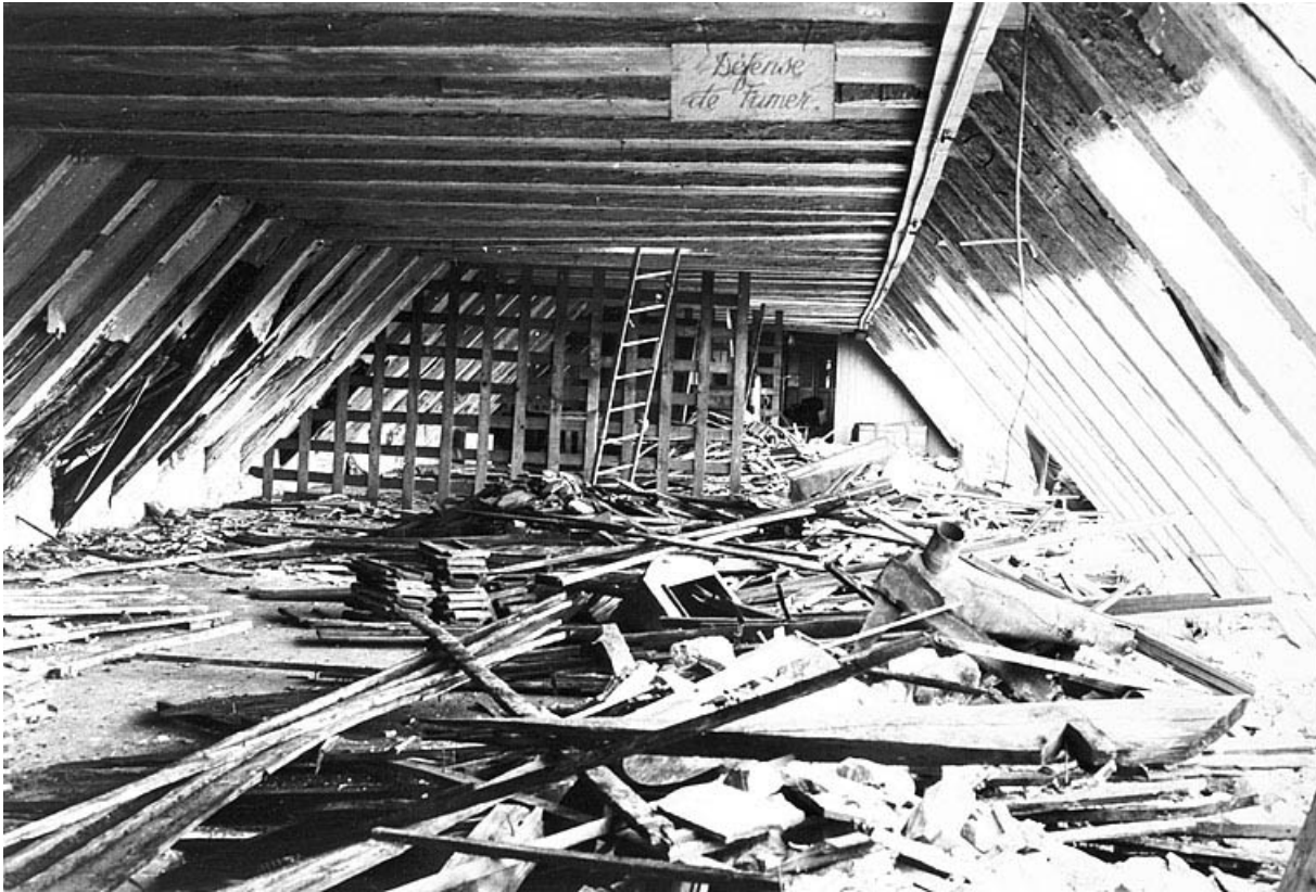
L'étage de comble (état en 1978).
