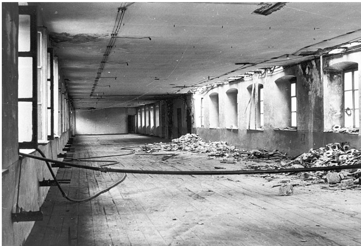
Atelier au second étage (état en 1978).
