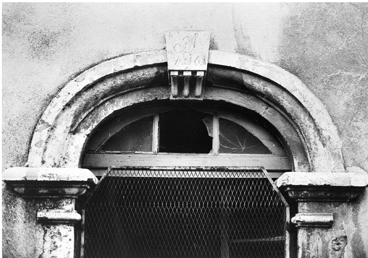
Détail d'une baie sur la façade sud (état en 1978). La clé d'arcade porte la date 1816 et les initiales F.J. (?), vestige de la reconstruction après l'incendie de 1815.
