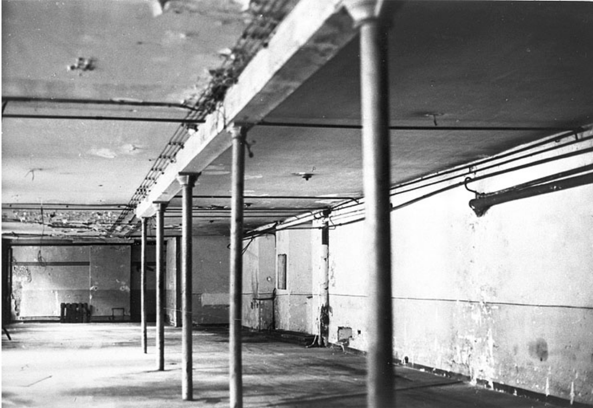
L'atelier au rez-de-chaussée (état en 1978).
