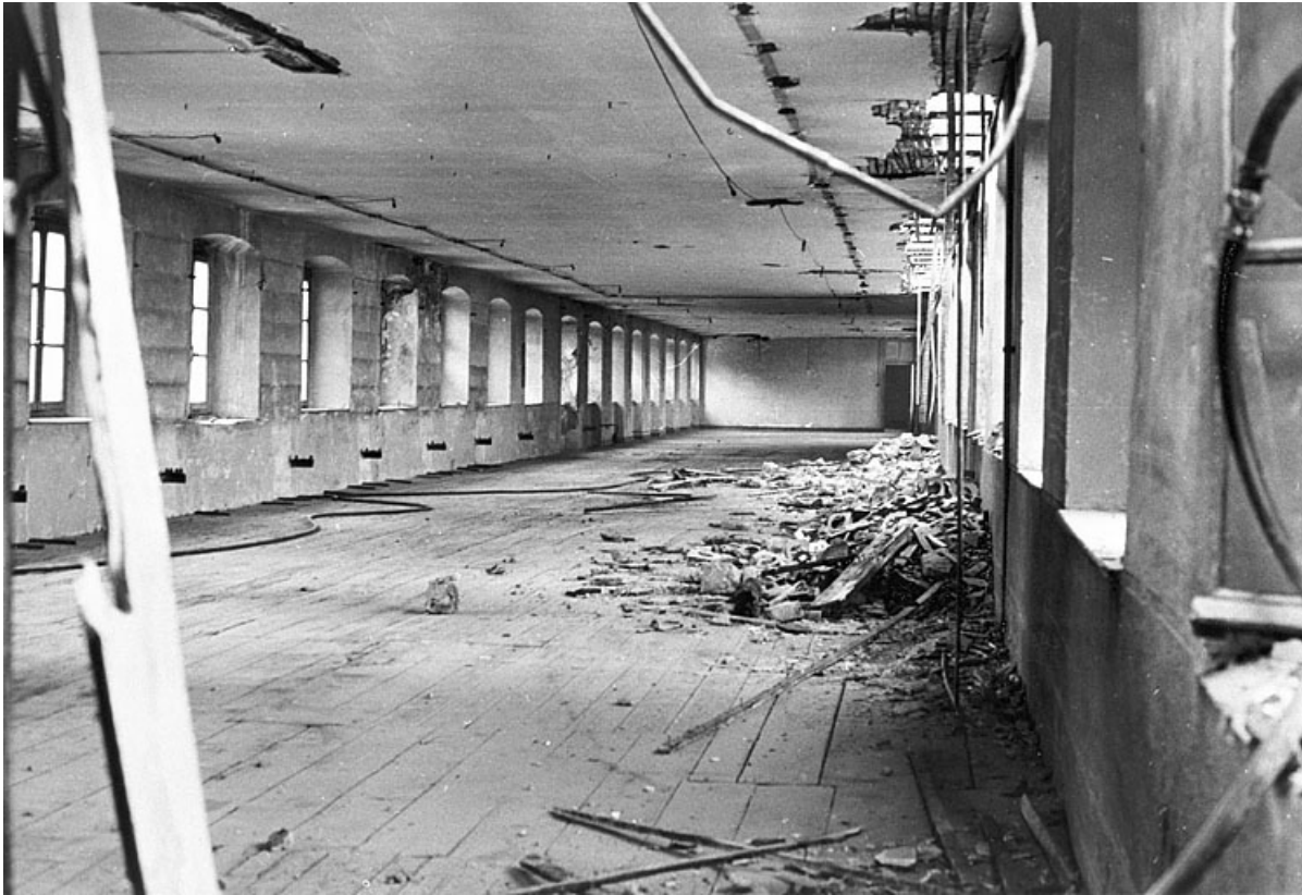
Atelier au second étage (état en 1978).
