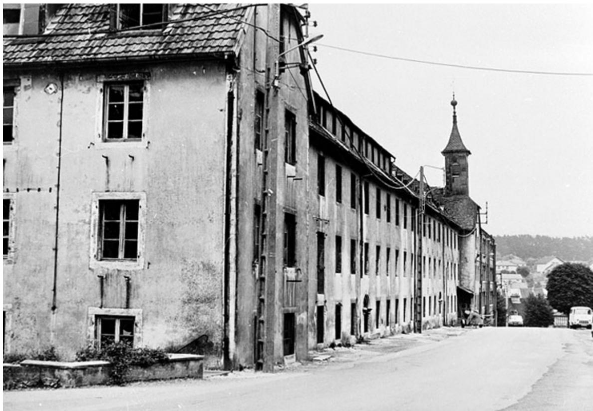
Façade sur rue avant destruction (état en 1978).
