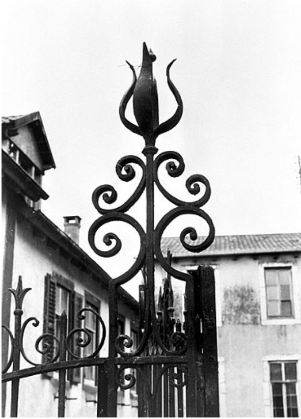
Bâtiments ouest : détail de la grille (état en 1978).
