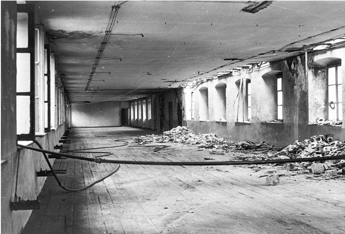
Atelier au second étage (état en 1978).
