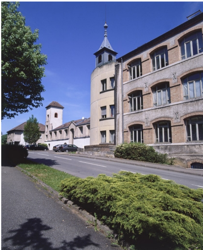
Façades sud depuis la rue Frédéric Japy. 90, Beaucourt, 16 à 30 rue Frédéric Japy
