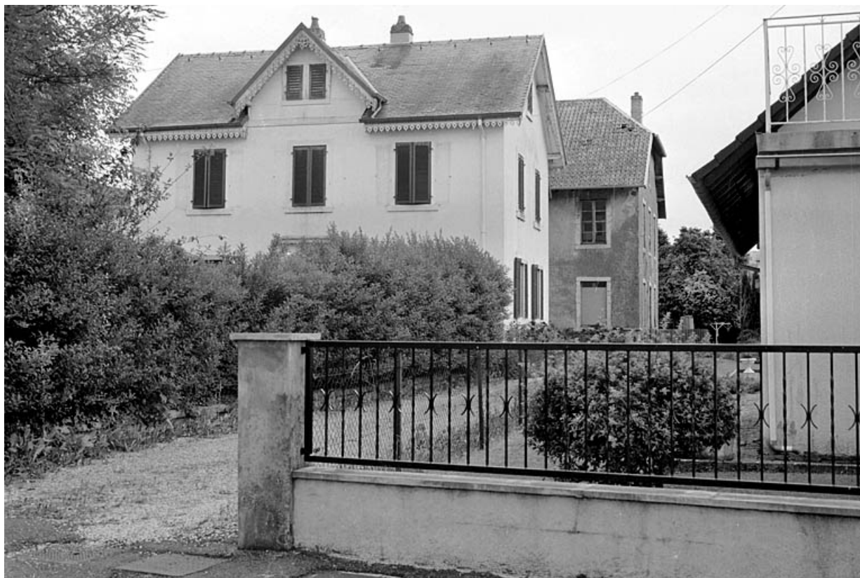
Vue d'ensemble depuis l'entrée. L'atelier de fabrication est masqué par le logement.
