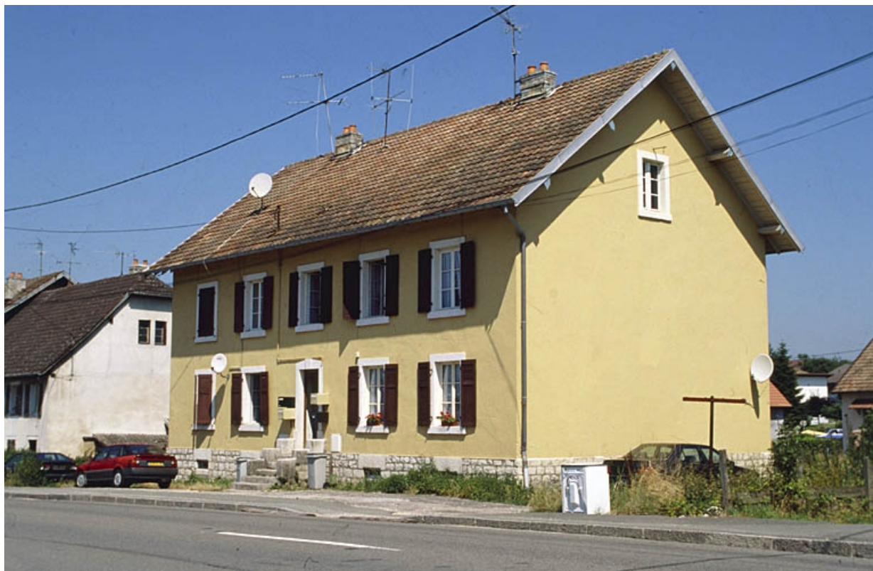
Maison à quatre logements (datée 1905) rue de Delle.
