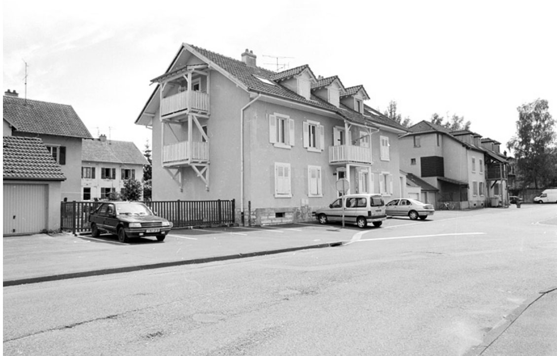
Logements collectifs (1902) rue Kléber. 90, Grandvillars, lieudit : cité Condemaine
